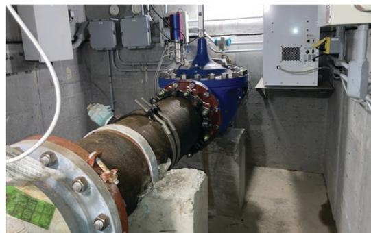
Exemple d'une chambre de régulation de pression : régulateur avec transmetteur de position et pilote électronique, débitmètre, robinet de prise pour vérification, transmetteurs de pression, pompe, chauffage et déshumidificateur.
