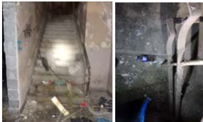
Photos 23 et 24. Escalier d'issue 2.
