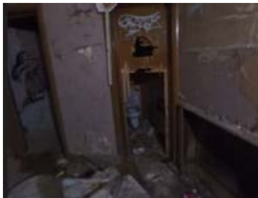
Photo 14. Porte de salle de bain débouchant sur l'issue 2
