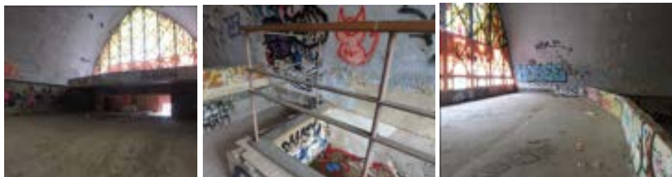
Photo 11 à 13. Moyen d'évacuation de la mezzanine
