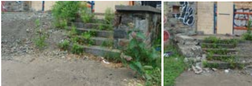
Photos 25 et 26. Escalier extérieur à l'entrée principale
