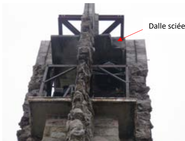
Figure 8. Repérage de la dalle du clocher
