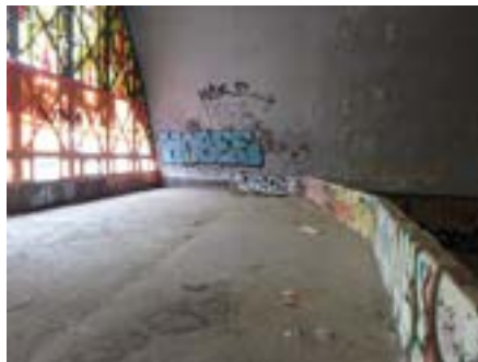
Photo 22. Garde-corps de la mezzanine
