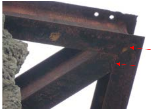
Figure 10. Soudure de coin de la structure d'acier
