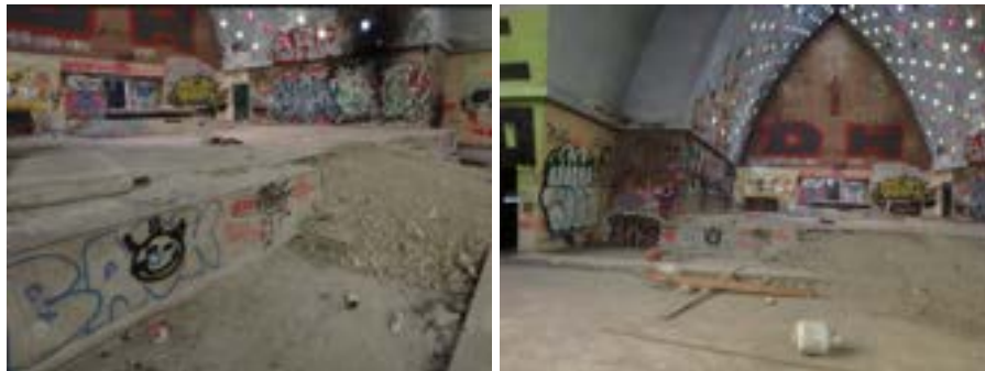
Photos 27 et 28. Marche avant l'escalier d'accès au chœur
