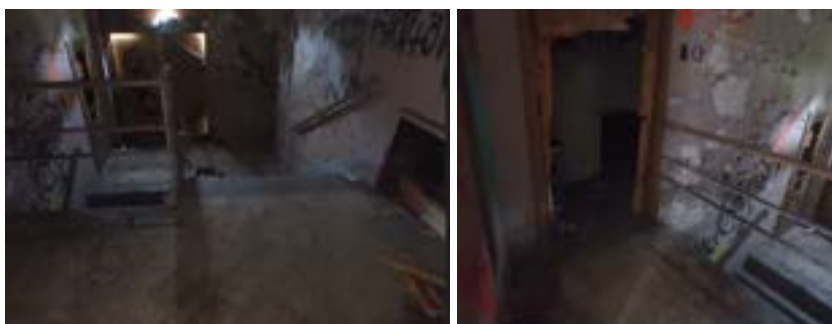
Photos 4 et 5. Escalier d'issue 5.
