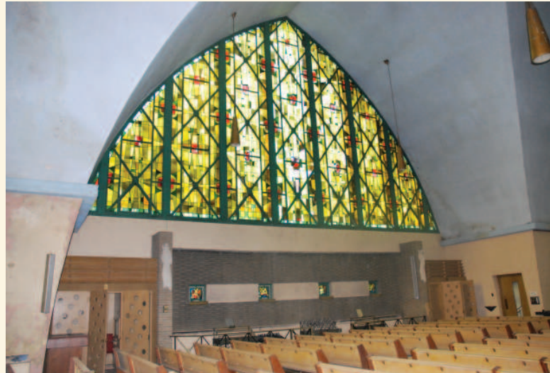
Verrière du transept ouest (Source : Ville de Montréal, juillet 2014)
