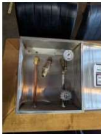
Vue de l'intérieur de la boîte avec valve, indicateur et branchement pour remplissage.
