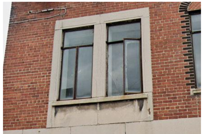
FIGURE 25 Détail d'une paire de fenêtres à l'étage de la façade principale. Ces fenêtres à battants avec imposte sont en acier et sont encadrées de pierre reconstituée en béton. Remarquez l'appareillage de la brique avec une rangée de boutisses à tous les six rangs. Source : Google Street View.
