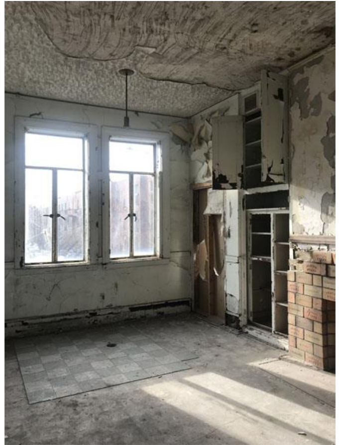
FIGURE 36 . Le bureau principal de l'étage se situant dans l'angle sud-est du bâtiment. Ce bureau comprenait un foyer, ce qui indique qu'il s'agissait probablement du bureau du président de l'entreprise. Source : STM.
