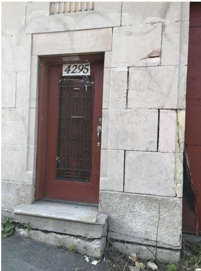
FIGURE 28. La porte d'entrée principale, ornée d'un grillage décoratif, au centre de la devanture revêtue de pierre reconstituée en béton moulé. Source : STM.
