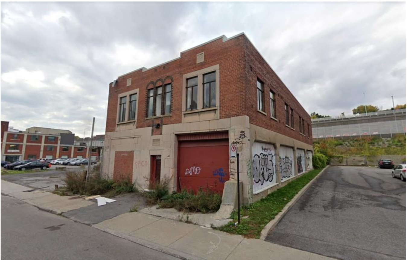
FIGURE 09 L'immeuble à l'étude situé au 4295, rue de Richelieu à Montréal. Source : Google Street View, octobre 2020.
