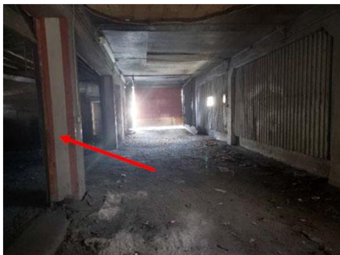
FIGURE 31. Autre vue intérieur du passage, cette fois vers l'arrière. Le mur de trouvant à droite était à l'origine ouvert sur l'extérieur. La flèche montre l'une des colonnes en béton de la structure de l'immeuble. Source : STM.
