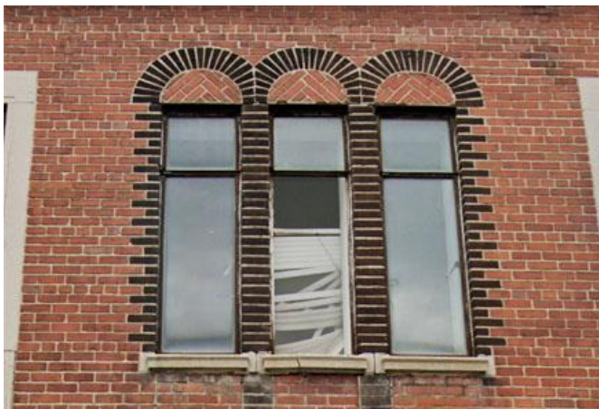
FIGURE 24 Détail de la façade principale montrant les fenêtres au-dessus de l'entrée centrale. Des briques de couleur foncées forment des chaînages autour des fenêtres ainsi que des arcs décoratifs dans la partie supérieure avec des tympans en briques disposées en chevrons. Les appuis en béton sont également ouvragés. Source : Google Street View.
