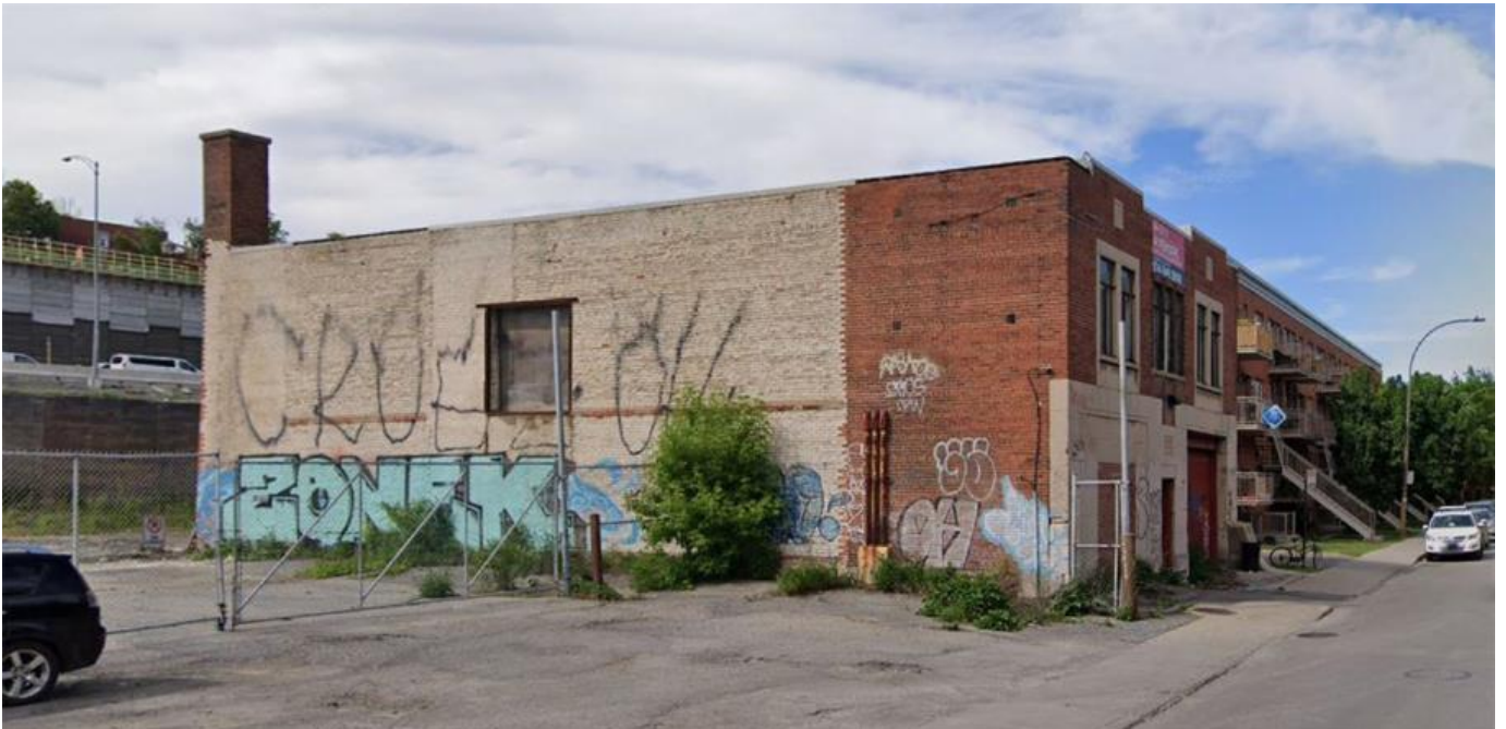
FIGURE 23 La façade latérale ouest est complètement aveugle. La partie plus pâle était mitoyenne jusque dans les années 1970. Seule la partie avant, ornée d'insertions de briques debout foncées, était originellement visible de la voie publique. La cheminée est d'origine. L'ouverture au centre du mur à l'étage a été pratiquée dans les années 1990. Source : STM.
