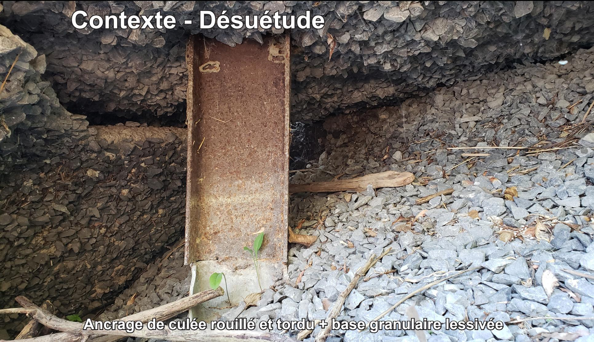
**Ancrage de culée rouillé et tordu + base granulaire lessivée**
