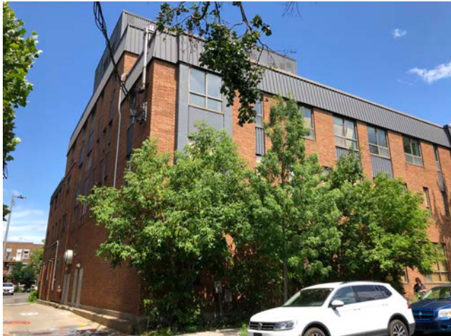
47. FAÇADE ARRIÈRE, RUE DROLET, 2025 (PASCALE BUSSEAU ARCHITECTE)
