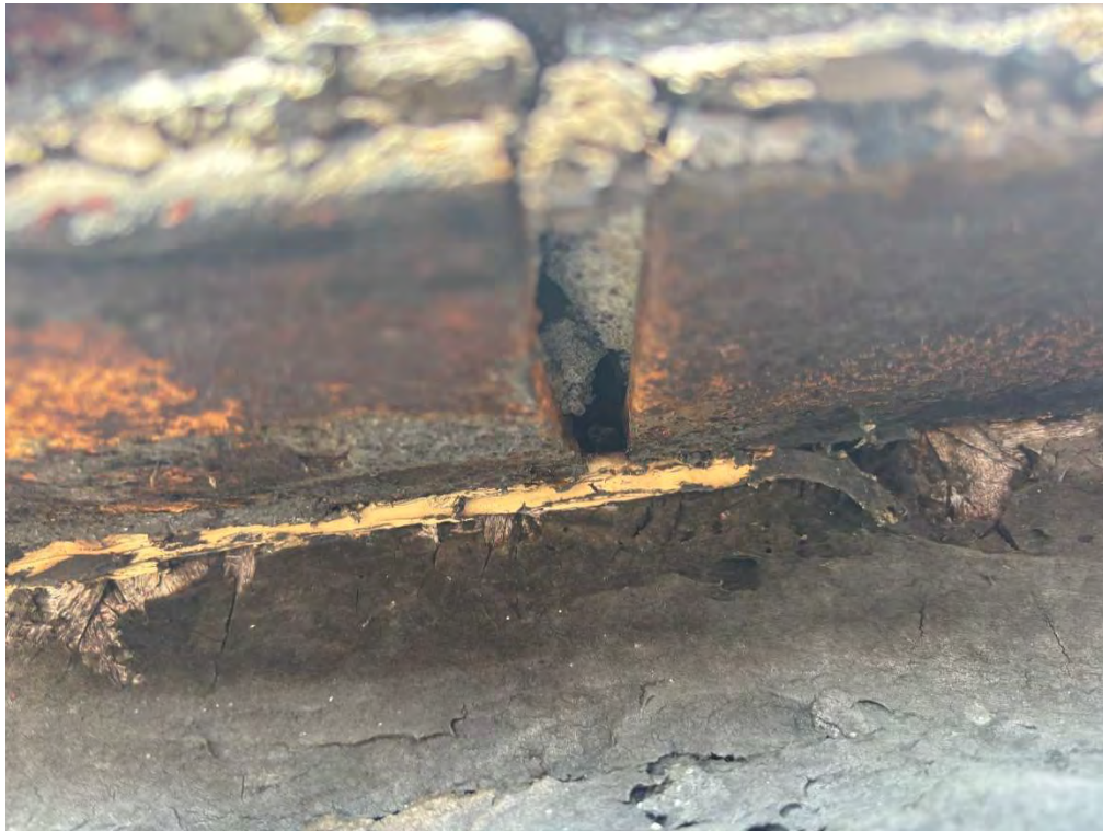
Cornière d'acier sciée en deux morceaux au centre du mur
