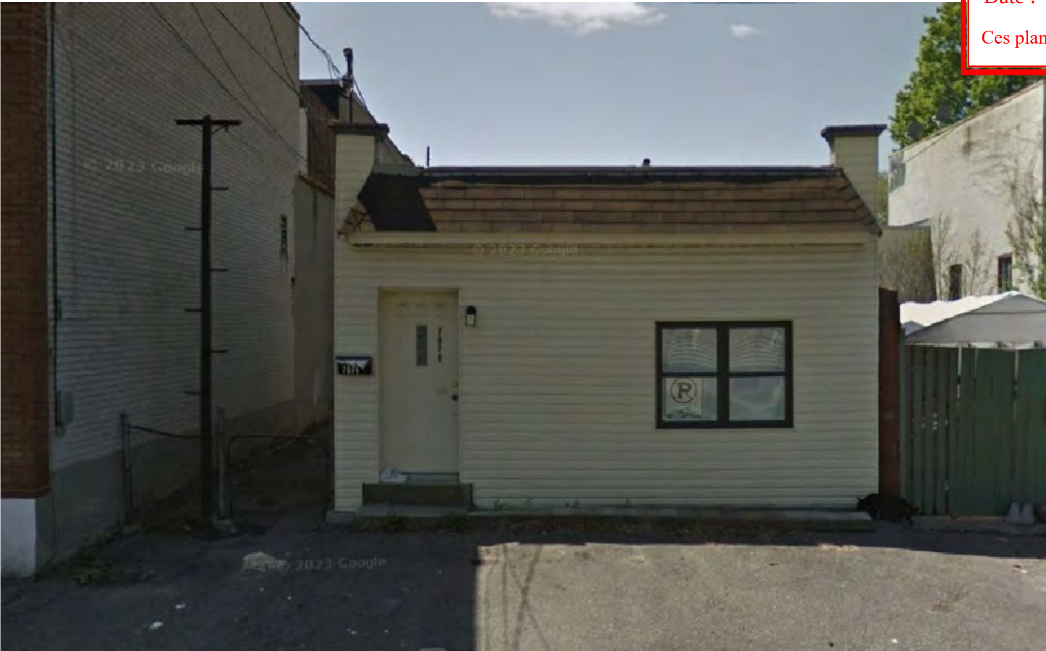
FAÇADE AVANT EXISTANTE
