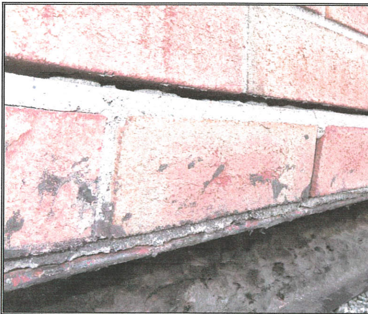
Vues rapprochées des désordres au niveau de l'appui (fer-angle)
