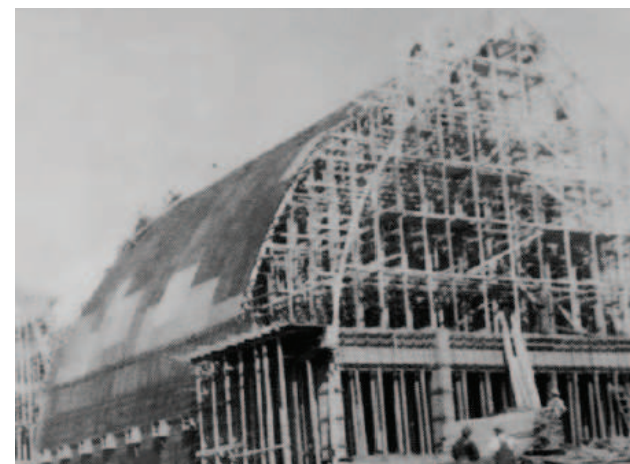
Au cours de la construction. (Source : Communauté chrétienne de St-Bernardin-de-Sienne : ensemble, 1912-1987)
