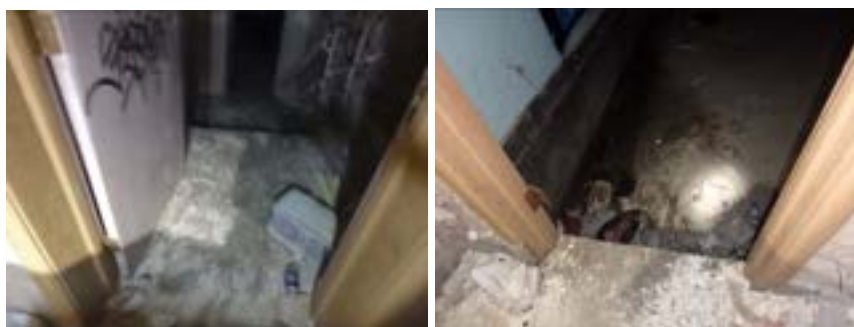
Photos 6 et 7. Escalier d'issue 4
