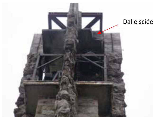
Figure 8. Repérage de la dalle du clocher
