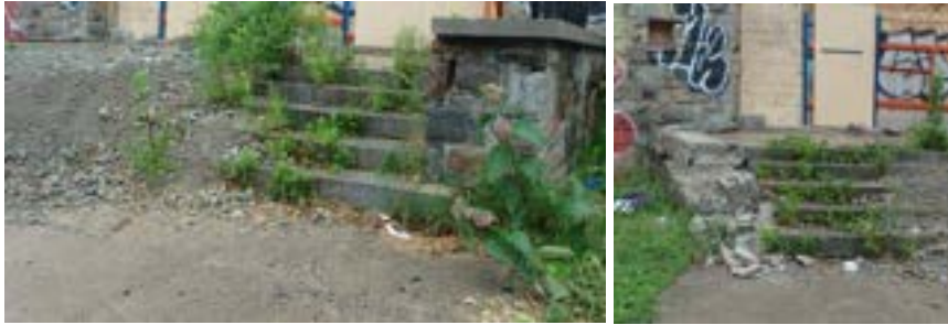
Photos 25 et 26. Escalier extérieur à l'entrée principale
