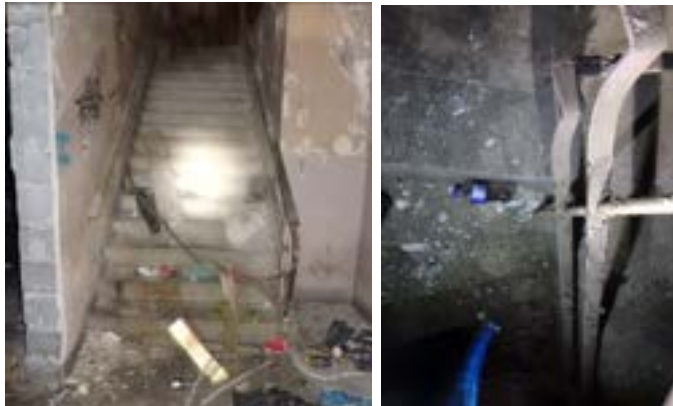
Photos 23 et 24. Escalier d'issue 2.
