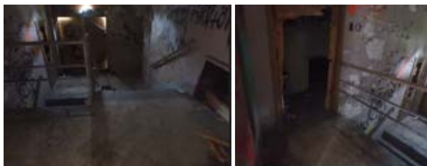
Photos 4 et 5. Escalier d'issue 5.
