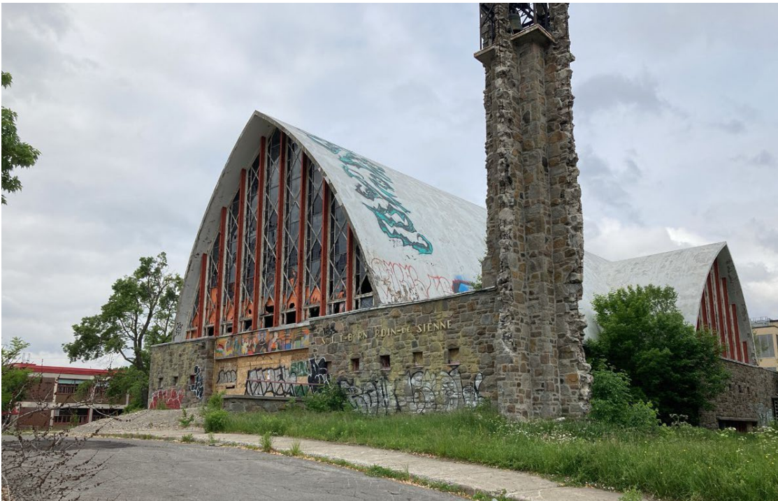
Église Saint-Bernardin-de-Sienne, état du bâtiment en 2023 (Source : Ville de Montréal, 2023)
