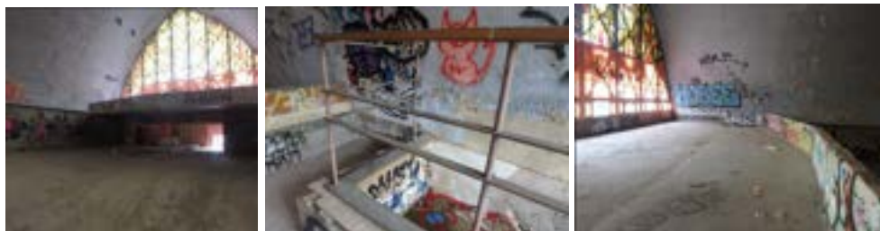
Photo 11 à 13. Moyen d'évacuation de la mezzanine
