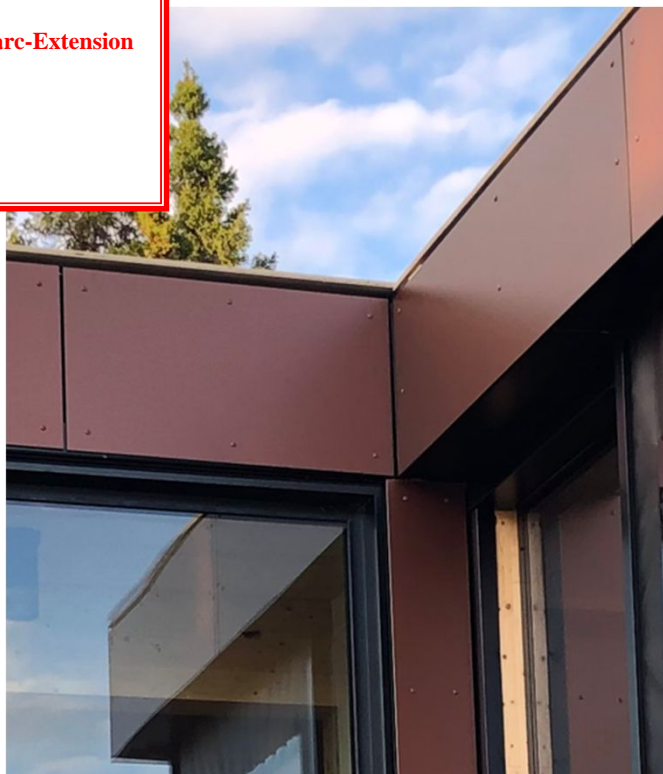
Parement de panneaux de stratifié haute pression Trespa Meteon Couleur Cuivre foncé
