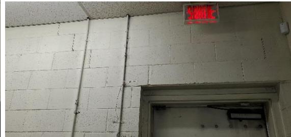
*Photo 12- Fissures Mur bloc béton*
