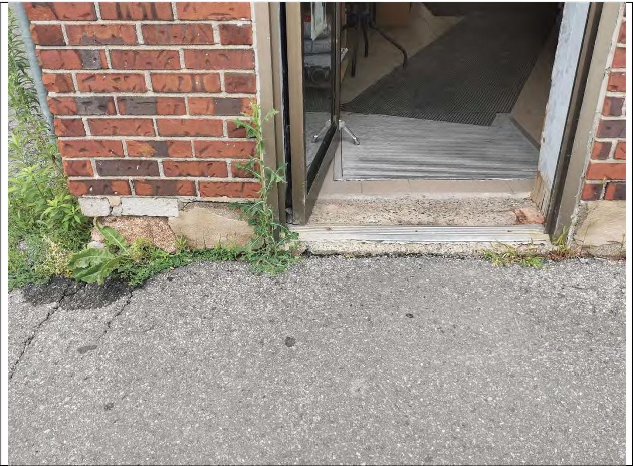
2 Mur de fondation en béton coulé avec crépi cimentaire en surface | EM 07-2021
