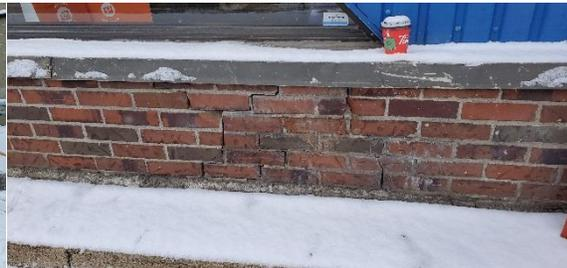
*Photo 4- fissures muret de briques*
