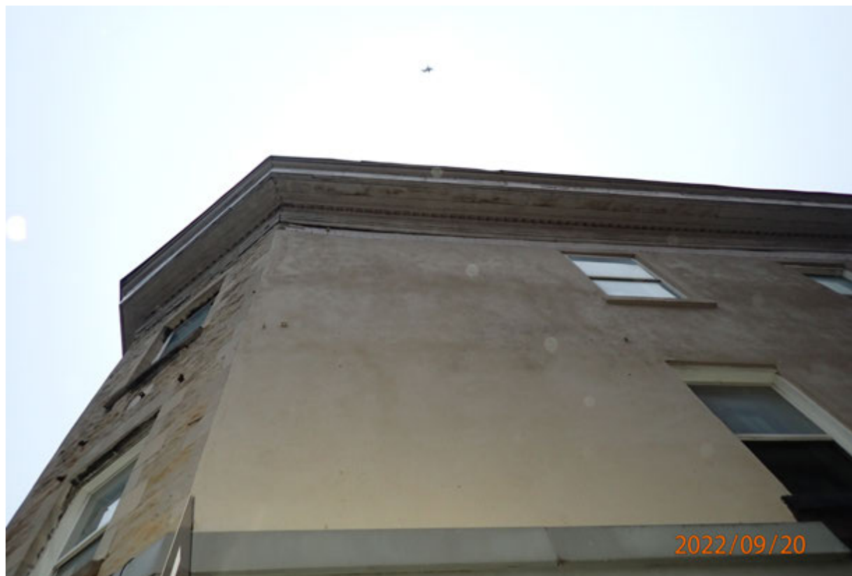
Façade sur rue de Berger, montrant la brique couverte de crépie et 6 rangées de brique peintes blanc.
