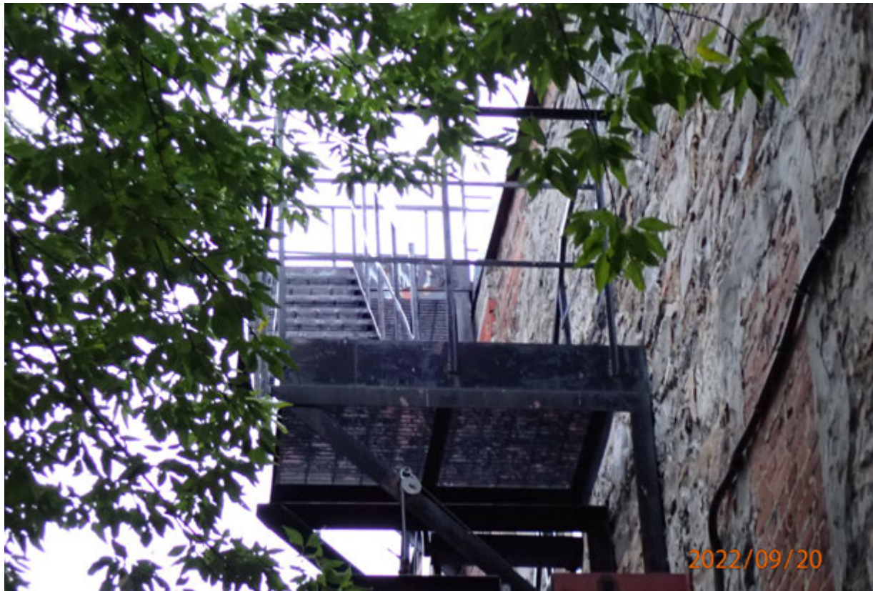
Mur latéral avec escalier de secours et remplissage ponctuel en brique.
