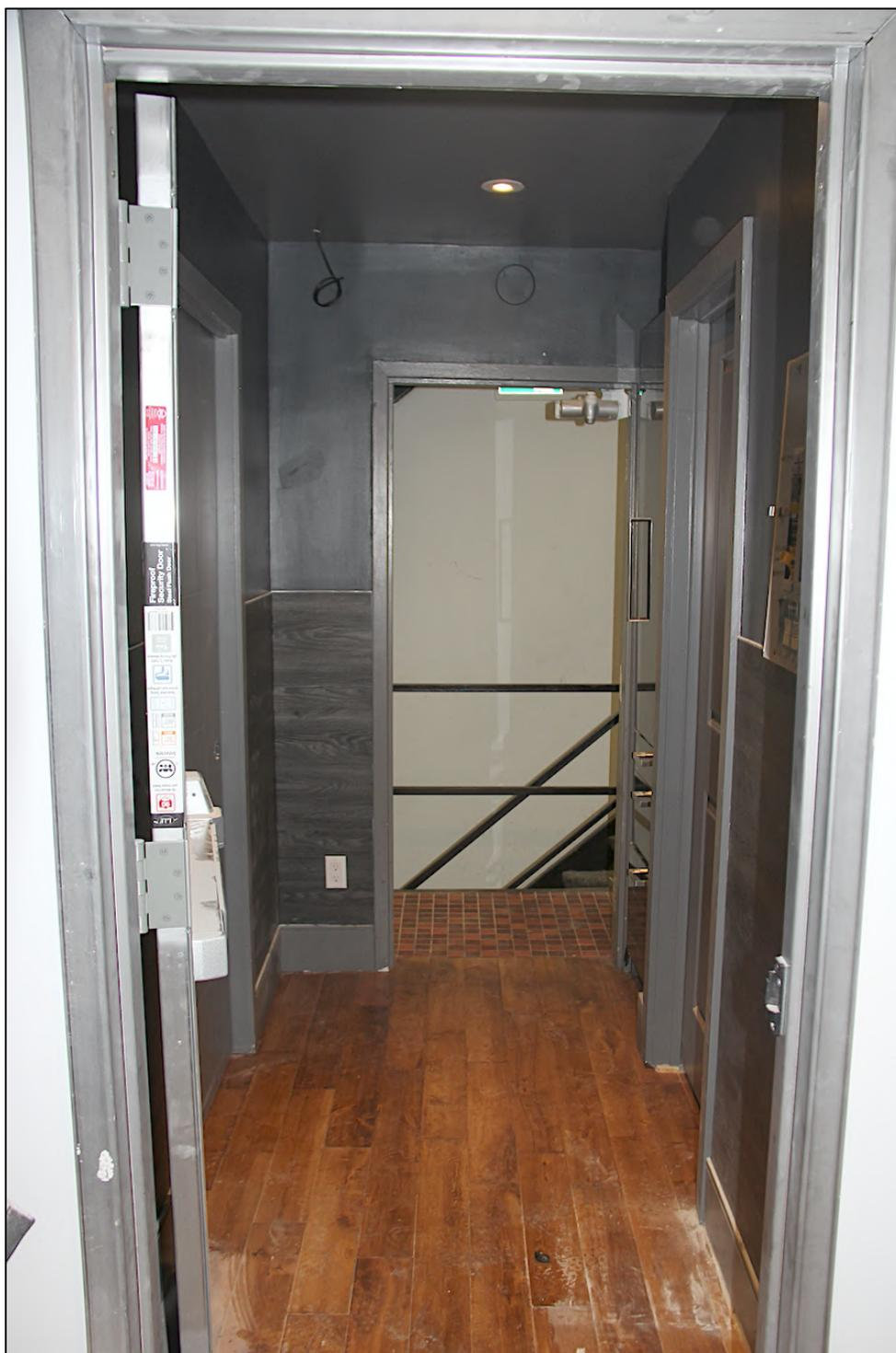
Notez que l'escalier du côté PUB est en acier et auto porteuse entre les palier. Cela veut donc dire que l'escalier n'est pas fixé sur le mur mitoyen et ne perce pas le gypse du mur mitoyen. Le transfert de bruit d'impact sont donc réduit au minimum.
