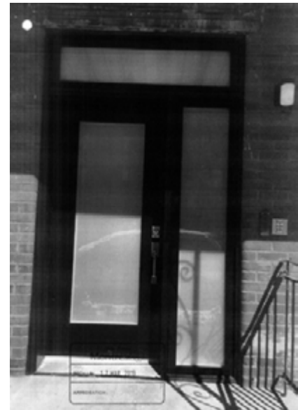
Porte principale installée
