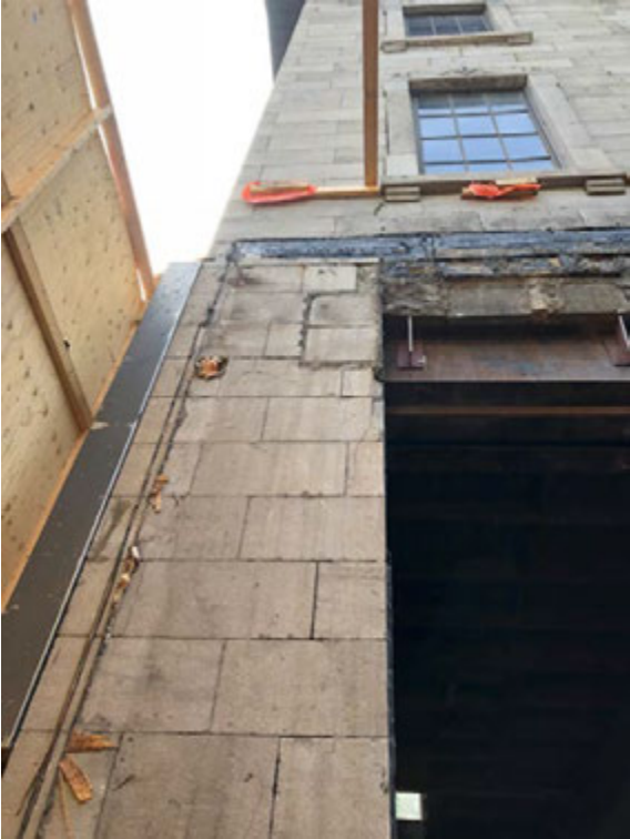
Photo, juin 2018 illustrant la façade avant suite à la démolition de l'avant-corps
