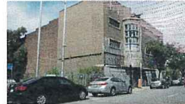
Photo 1 - Le site (vue à partir de la rue Sainte-Catherine)
