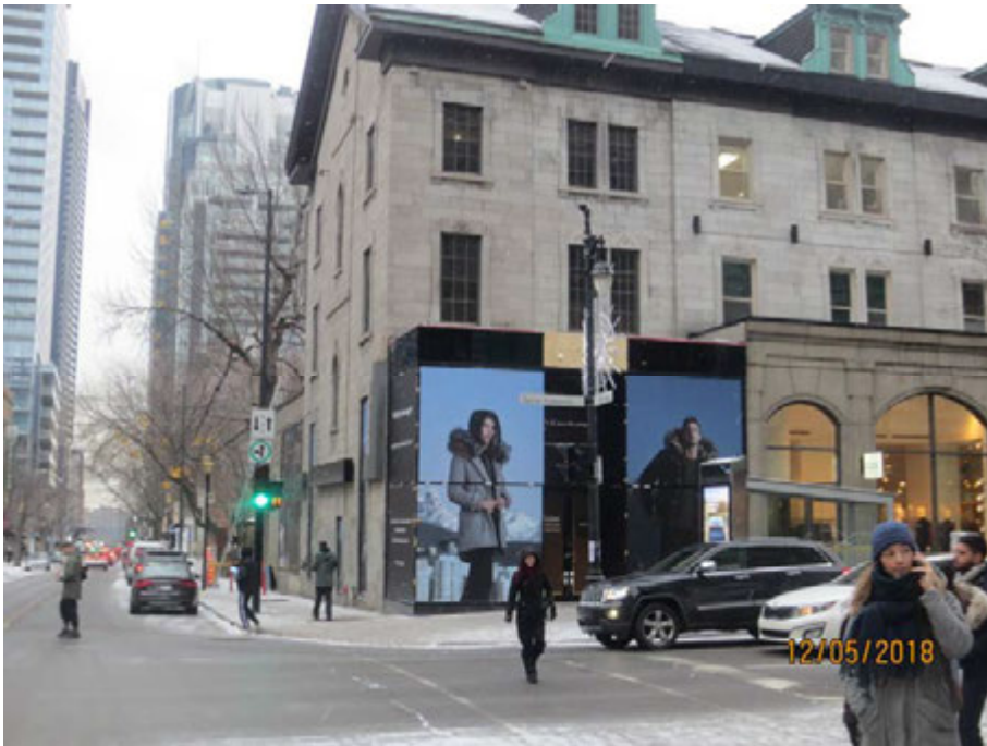
Photo du tel que construit, décembre 2018
