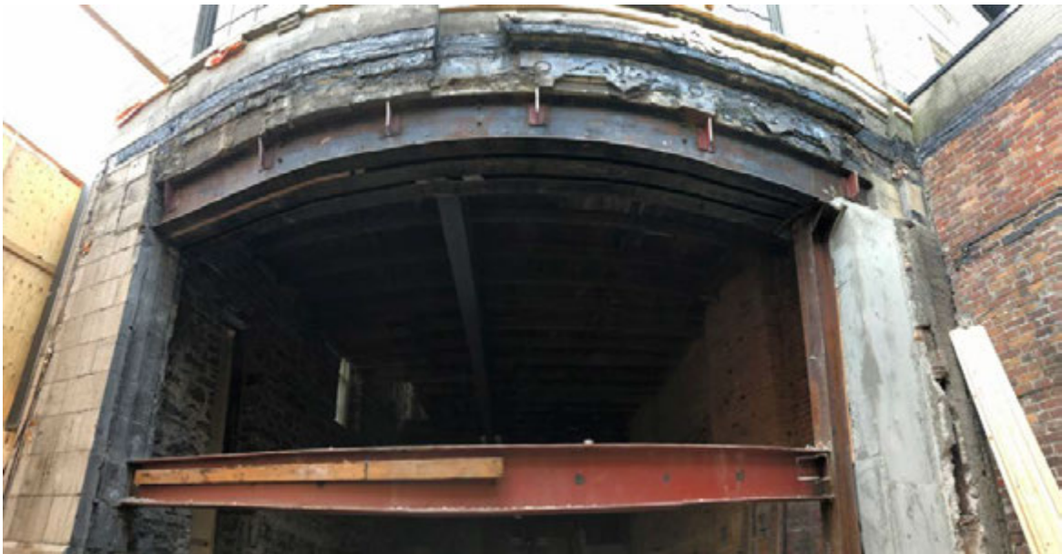
Photo panoramique, juin 2018 illustrant la façade avant suite à la démolition de l'avant-corps
