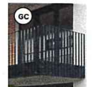
GARDE-CORPS EN BARROTINS PEINTS NOIR Installé devant la dalle des balcons peints noirs
