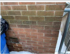
Section de maçonnerie de briques humides au dos des poubelles – Côté nord
