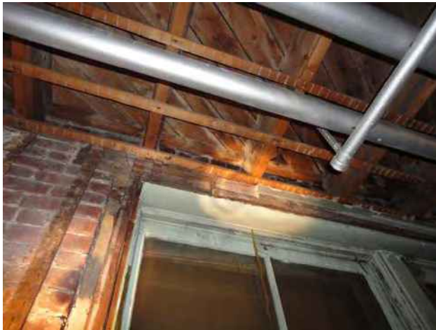
Côté intérieur d'une fenêtre dont la périphérie a été dégarnie. À partir du haut, on voit le pontage de bois, les solives encastées dans la maçonnerie et le linteau de bois. À gauche, on aperçoit le cadre, le sous-cadre et la face intérieure du mur massif de maçonnerie. Une fourrure verticale servant à fixer le lattis de bois est encore présente
