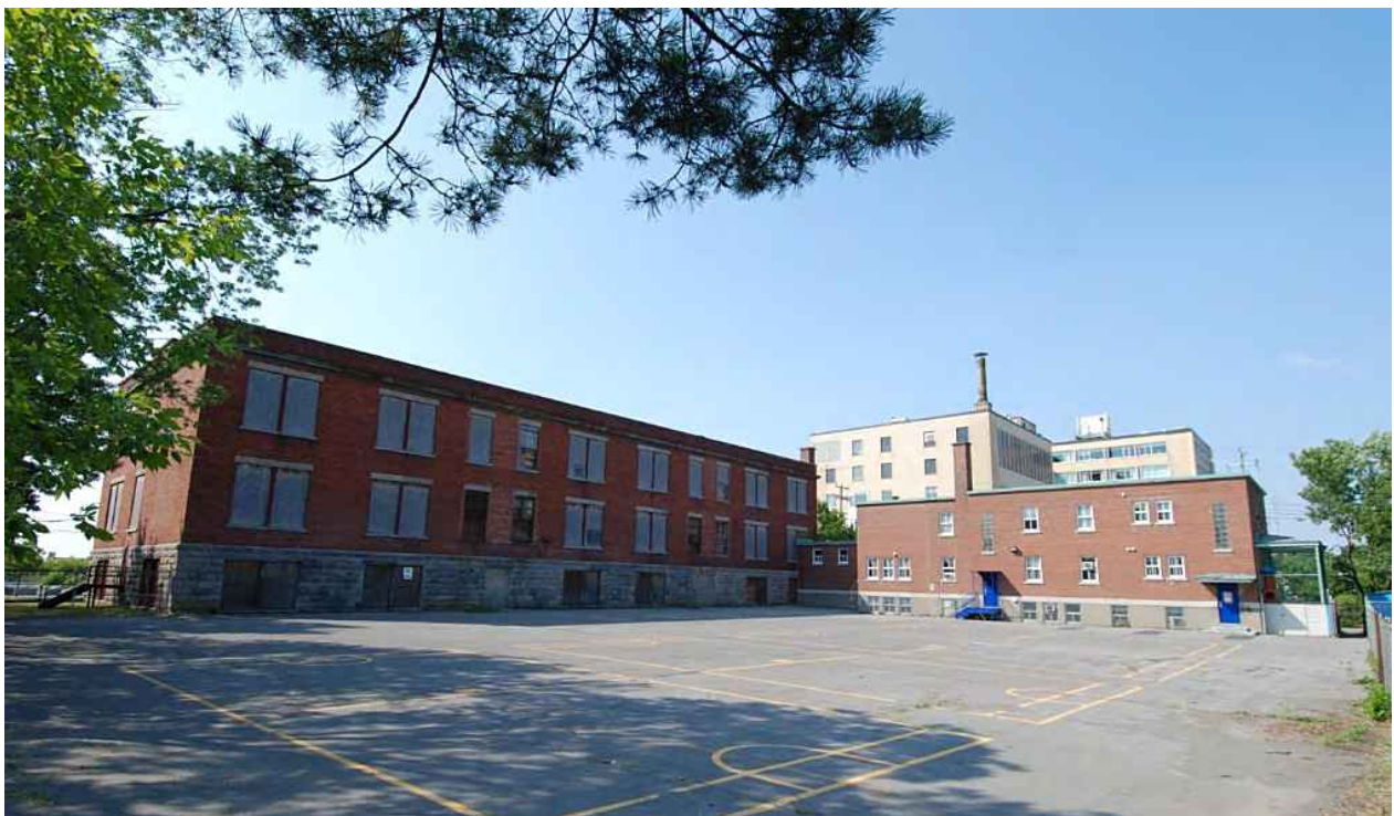
Façades sud et ouest de l'école ainsi que la façade arrière de l'ancienne résidence des religieuses. Source : Mario Brodeur, juillet 2012.
