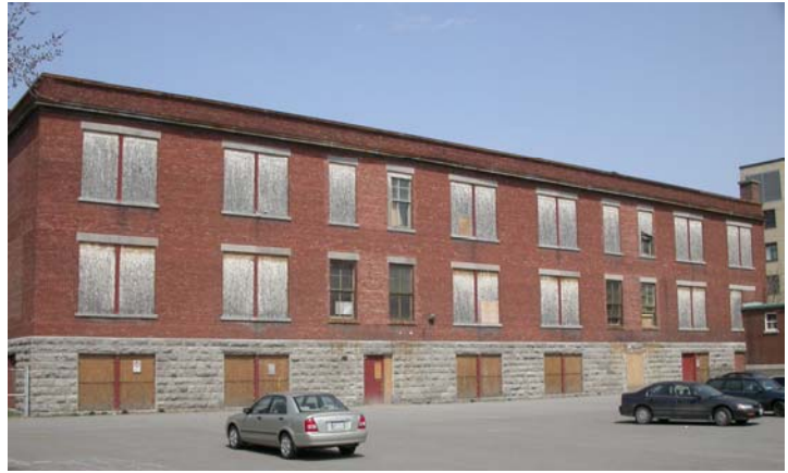
Façade arrière - est
