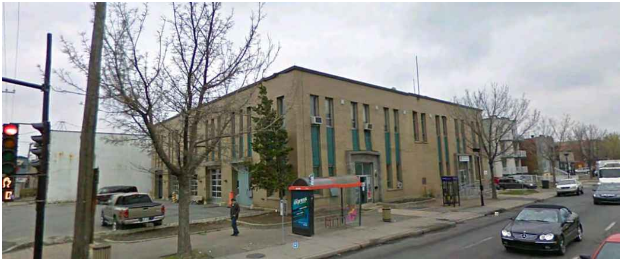
Caserne de pompiers n° 9. Source : Google Earth.
