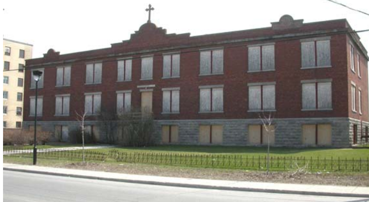
Façade principale – rue Jarry
