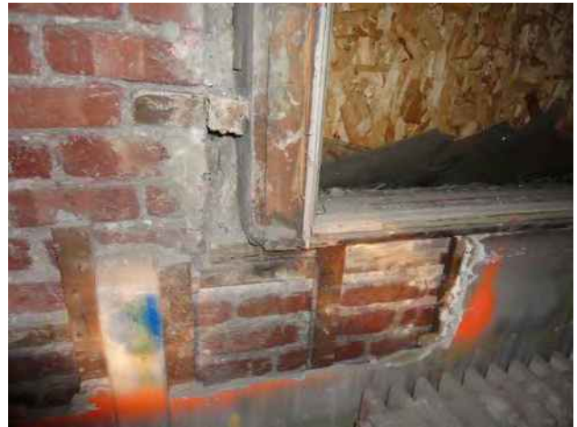
Vue d'un coin inférieur dégarni d'une fenêtre
