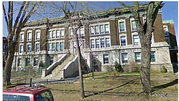
École Saint-Jean-Baptiste-de-La-Salle, 2355, boulevard Pie-IX, construite en 1918 (Charles A. Reeves). Source : Google Earth.
