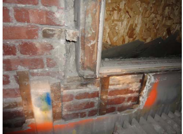
Vue d'un coin inférieur dégarni d'une fenêtre
