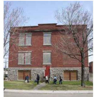
Façade latérale sud – entrée à mi-niveau
