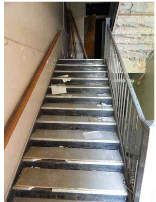
Escalier sud – marches recouvertes de contreplaqué
