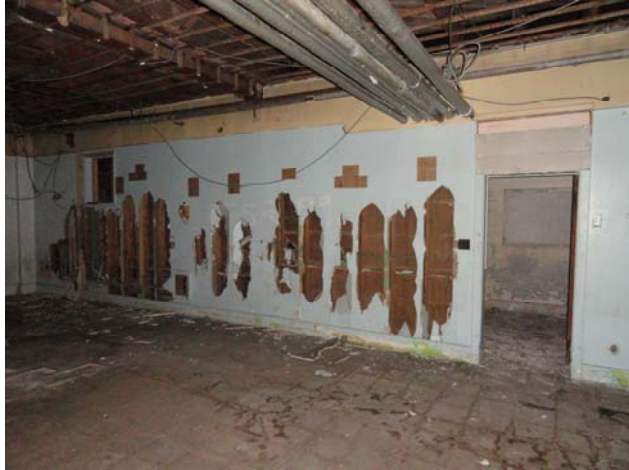
Cloison intérieure vandalisée
