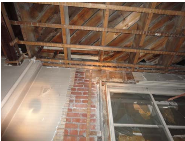
Vue intérieure d'un mur extérieur – fenêtre, maçonnerie et lattis de bois avec enduit cimentaire – la maçonnerie intérieure est dans un état stable et sa réparation est possible ;
