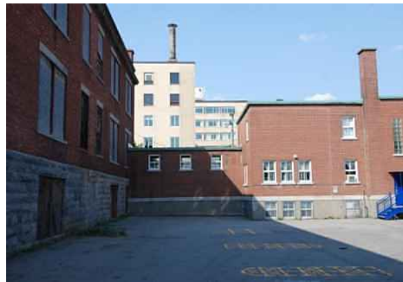
La cour arrière. Source : Mario Brodeur juillet 2012.
