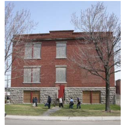
Façade latérale sud – entrée à mi-niveau
