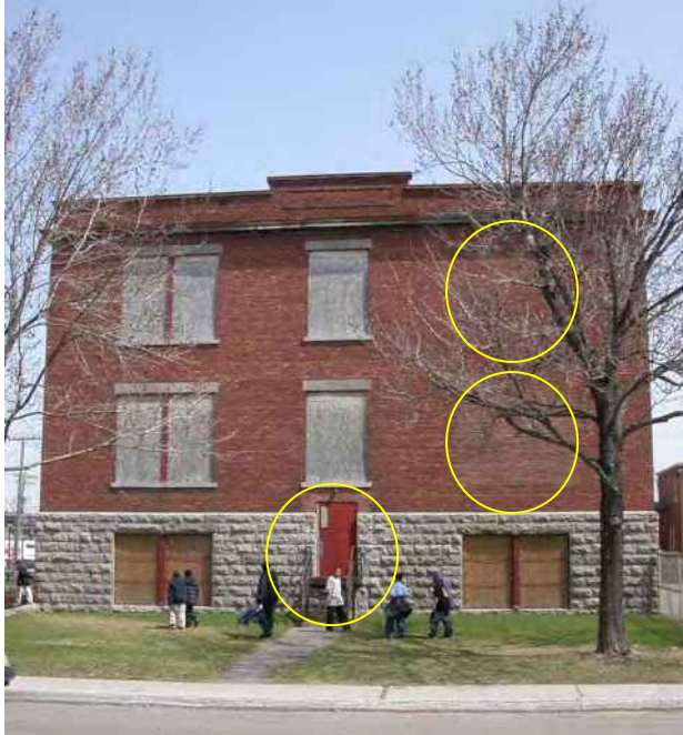
La façade sud a subi des modifications modifiant le niveau d'accès au bâtiment. Deux fenêtres ont également été murées.
