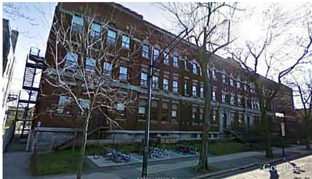
École Saint-Marc, 6365, 1 ère Avenue, construite en 1917-18 (Irénée Vautrin). Source Google Earth.
