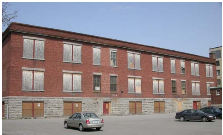
Façade arrière - est
