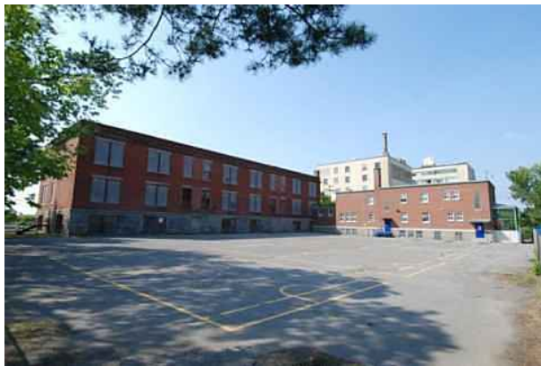
La cour arrière. Source : Mario Brodeur juillet 2012.
