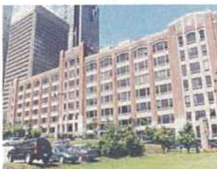
Edifice du 715 Peel, Montréal
