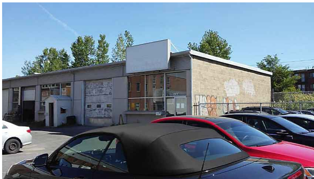
Photo 4. Garage/entrepôt détaché indépendant du bâtiment principal.
