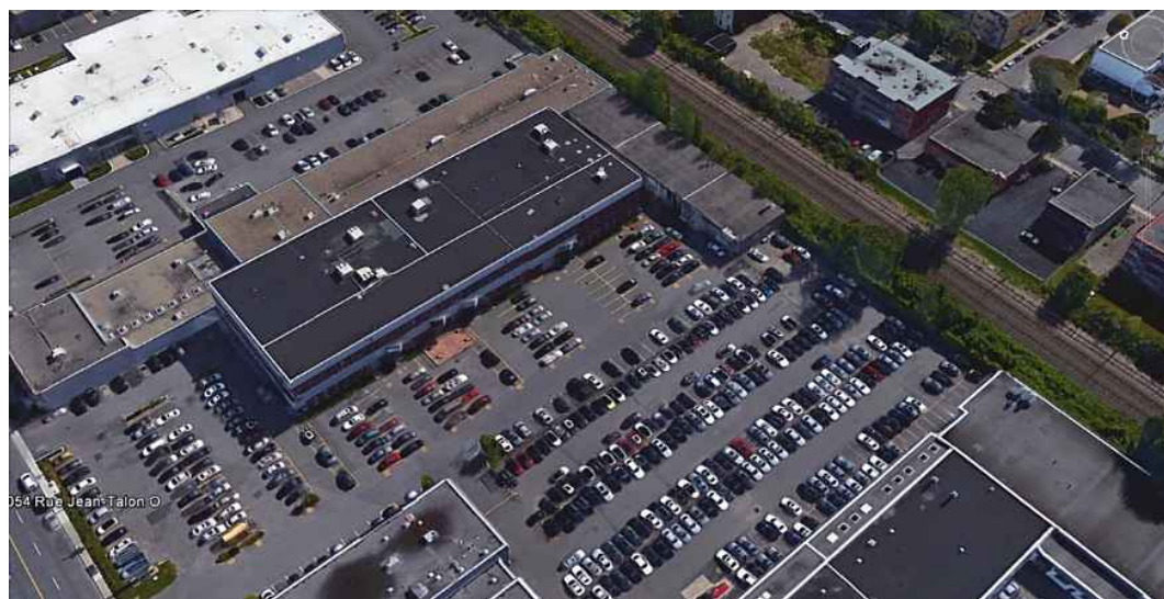
Photo 1. Localisation du site du nouvel aménagement de la garderie.
