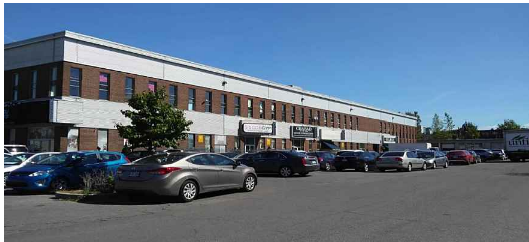
Photo 2. Surface asphaltée imperméable assurant un drainage vers le réseau municipal.
