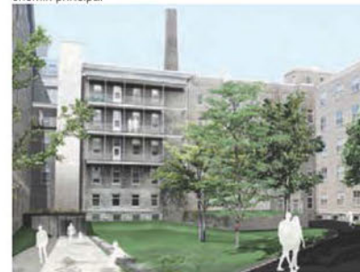
Axe 3 | Vue de la cour intérieure et de l'accès à la Chapelle
