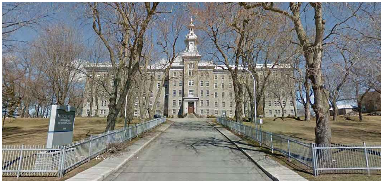
La Maison mère des Soeurs de Sainte-Anne (aile A), vue depuis la rue Provost (Source : Google Maps)
