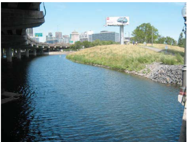
Photo 5 : Bassin Peel (Vue de la rive droite – Tirée de exp, 2014).
