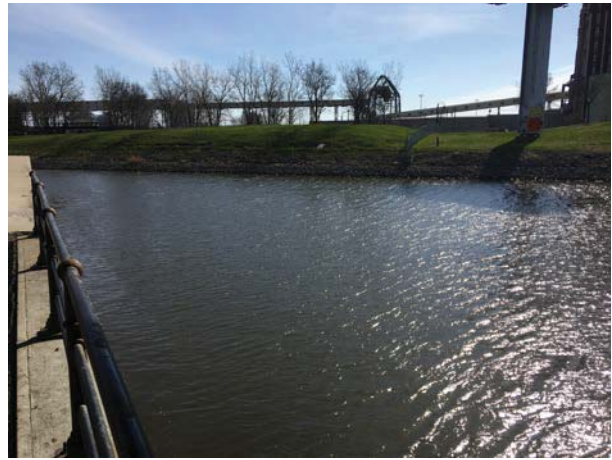
Photo 2 : Bassin Peel (Vue de la rive gauche – Photo prise le 25 avril 2017).
