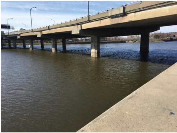
Photo 1 : Bassin Peel (Vue de la rive gauche – Photo prise le 25 avril 2017).
