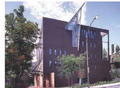
Vue de la façade du bâtiment sur la rue
