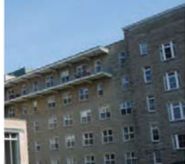
Jonction arrière entre bâtiments B et C
