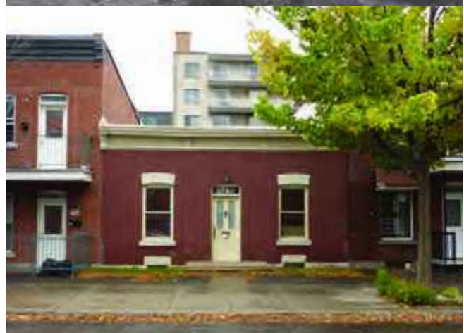
Aujourd'hui menacées, la plupart des maisons de type shoebox ont été érigées au début du 20 e siècle. Ci-haut, le 5974, avenue Louis-Hébert, dans l'arrondissement de Rosemont—La Petite-Patrie, en 1925. En bas, une photographie récente du 5740, rue Saint-André, érigé en 1905.
