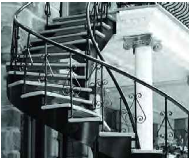
Le patrimoine vernaculaire montréalais s'exprime par différentes caractéristiques architecturales, dont les escaliers en fer forgé qui serpentent devant les façades des plex.
