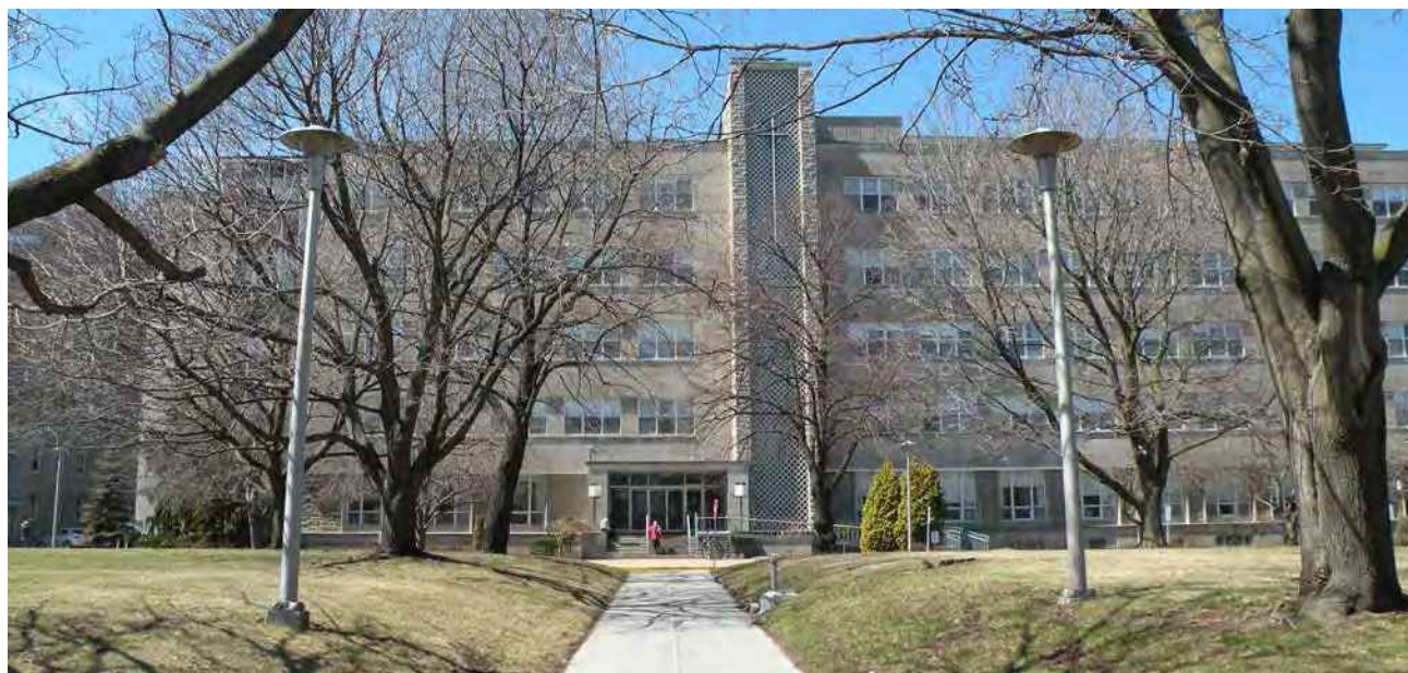
La Maison mère des Soeurs de Sainte-Anne (aile C), vue depuis la rue Esther-Blondin (Source : Patri-Arch, 2016) N.B. En l'absence de mention, les plans et photographies proviennent de la Ville de Montréal (VdM)
