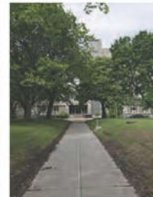
Vue de l'entrée de l'aile C à partir de l'avenue Esther-Blondin
