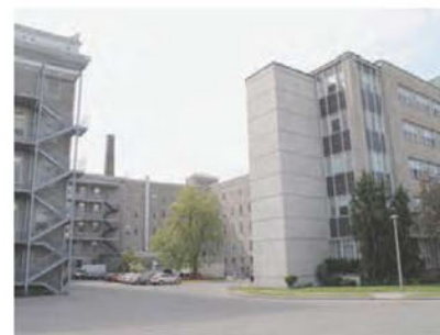
Vue de la cour de service actuelle
