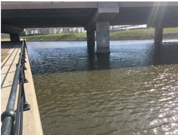
Photo 3 : Bassin Peel (Vue de la rive gauche – Photo prise le 25 avril 2017).
