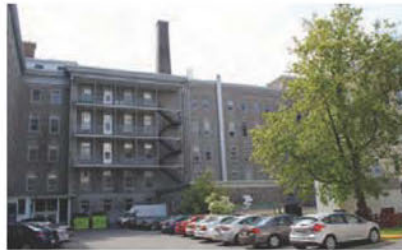
Vue vers cour intérieure à la jonction des ailes A-B-C
