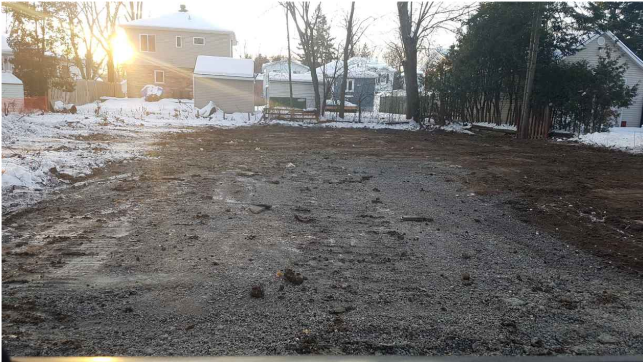
Terrain du 5060, rue Dauville
