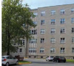
Jonction verticale avant entre bâtiments B et C pour estomper le non-alignement des étages
