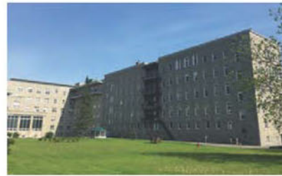
Jonction entre les ailes B et C
