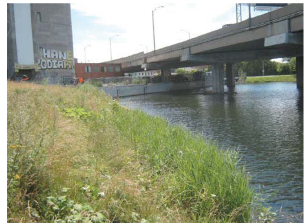
Photo 6 : Bassin Peel (Vue de la rive droite – Tirée de exp, 2014).
