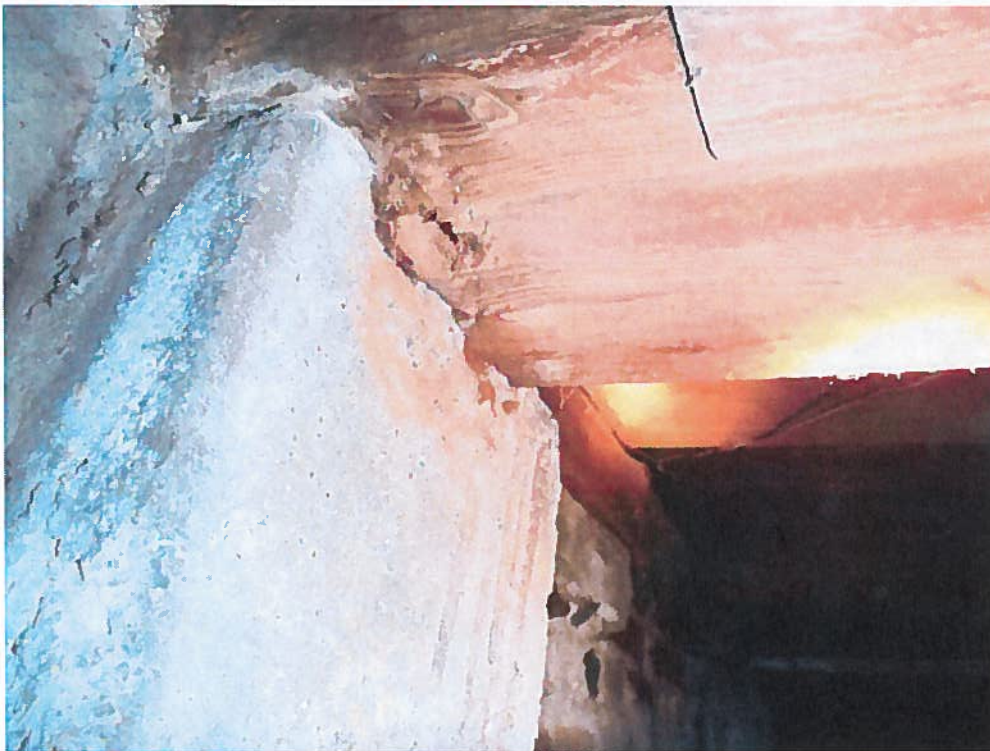
Photo 26 : Extrémité de la poutre partiellement pourrie et écrasée à son appui au mur de fondation arrière
