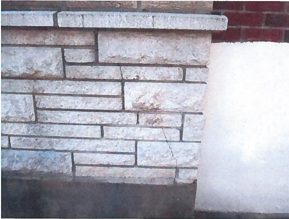
Photo 11 : Fissuration du parement de maçonnerie en façade avant à la jonction du bâtiment voisin Nord
