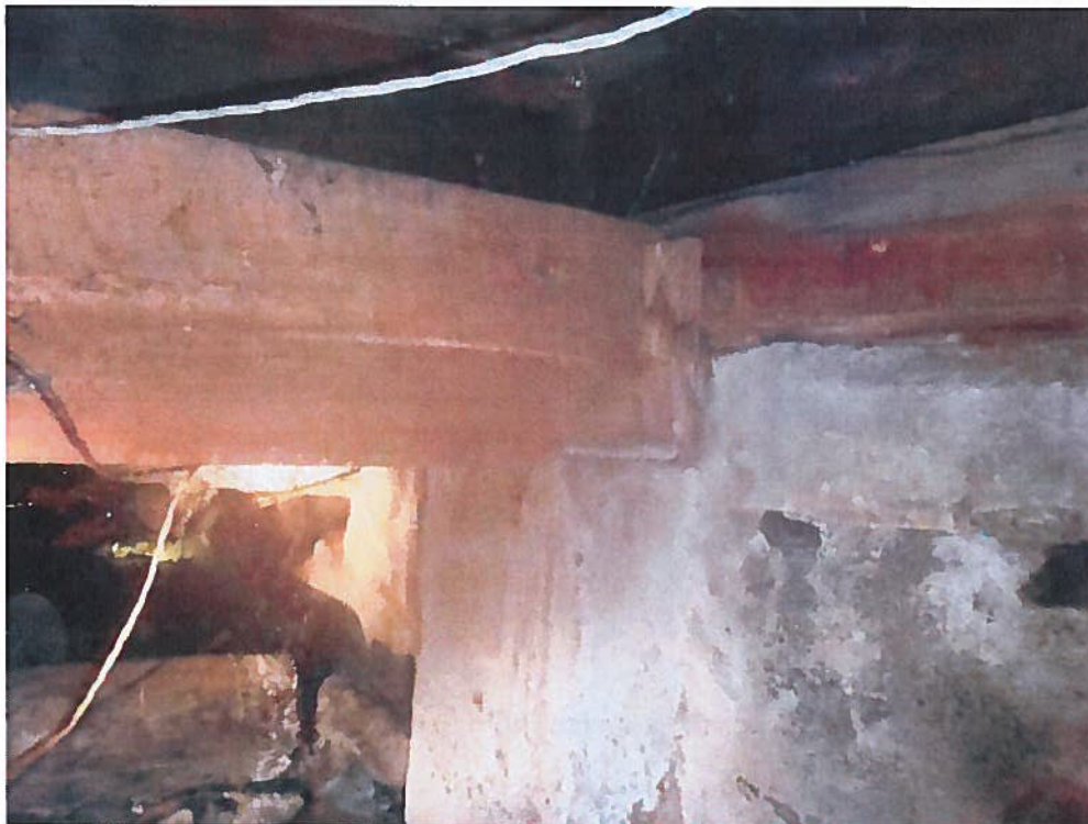
Photo 2 : Efflorescences en face interne du mur de fondation arrière sous l'appui de la poutre
