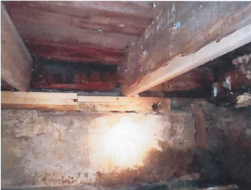
Photo 16 : Lisse d'assise au mur mitoyen Nord remplacée par une pile de pièce de bois de sciage
