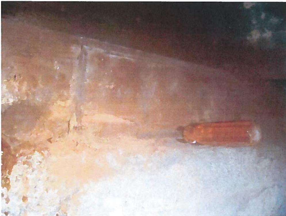
Photo 12 : Tournevis enfoncé sans effort dans la lisse où s'appuient les solives au mur mitoyen Nord
