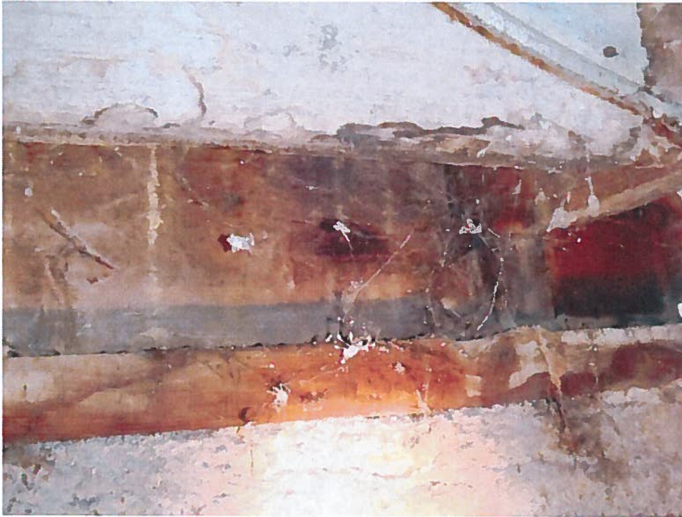
Photo 21 : Solive de rive et lisse d'assise tachées par la moisissure et pourries en façade avant
