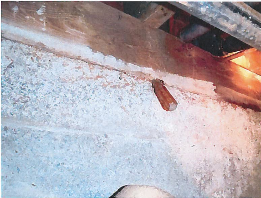
Photo 14 : Tournevis enfoncé sans effort dans la lisse où s'appuient les solives au mur mitoyen Nord
