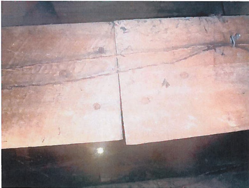
Photo 34 : Jonction d'un pli de poutre assemblé faiblement et s'étant un peu affaissée
