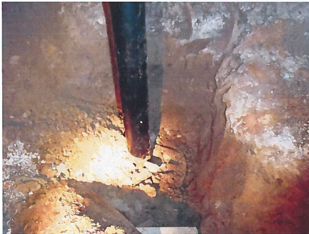
Photo 28 : Vérin d'acier de la photo précédente posé sur une dalle de patio ronde de 12" de diamètre
