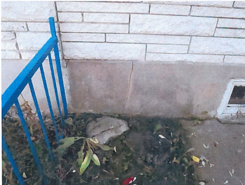
Photo 10 : Fissure de la fondation avant près de la limite de propriété Sud
