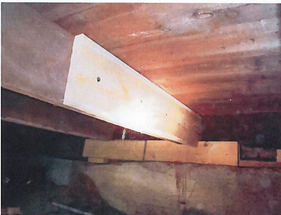
Photo 18 : Extrémité de solive pourrie doublée sur quelques pieds près de son appui au mur mitoyen Nord
