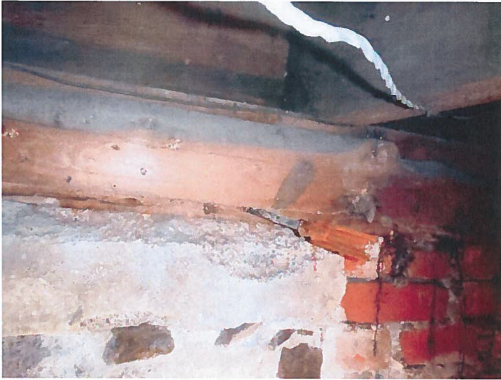
Photo 13 : Tournevis enfoncé sans effort dans la lisse d'assise au mur de fondation arrière
