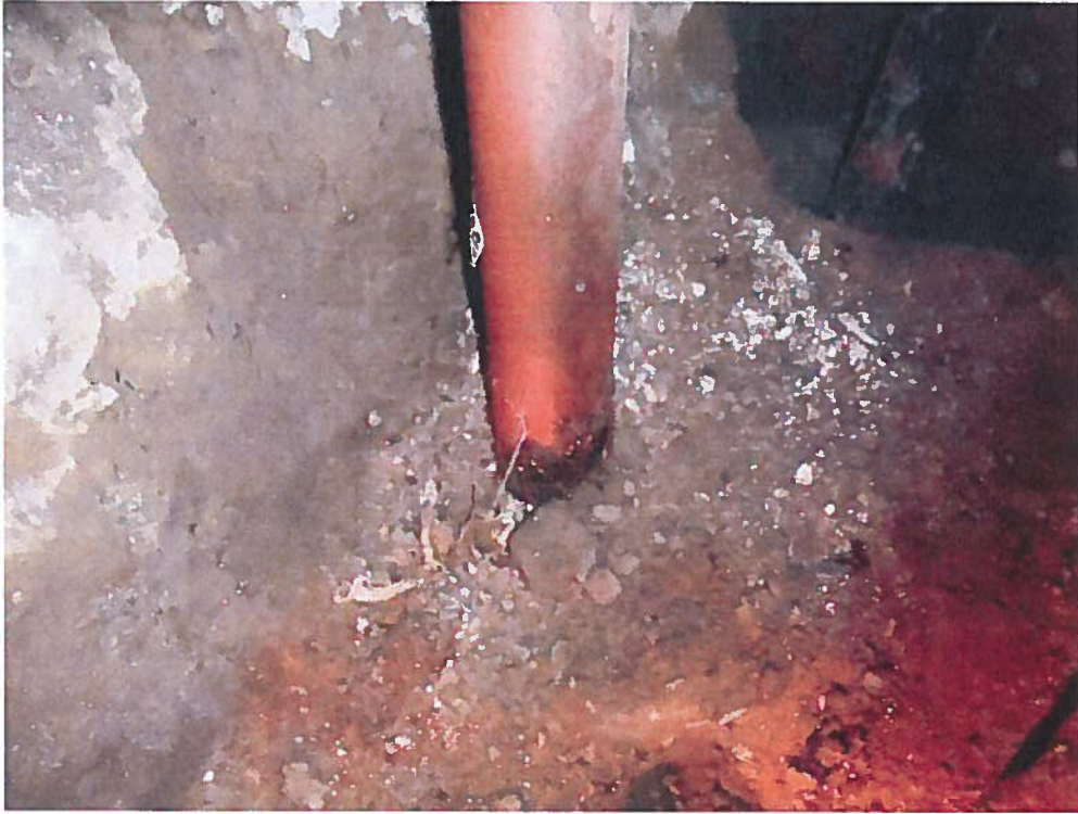
Photo 33 : Base très corrodée du vérin de la photo 27 qui porte une solive là où il est en contact avec le sol
