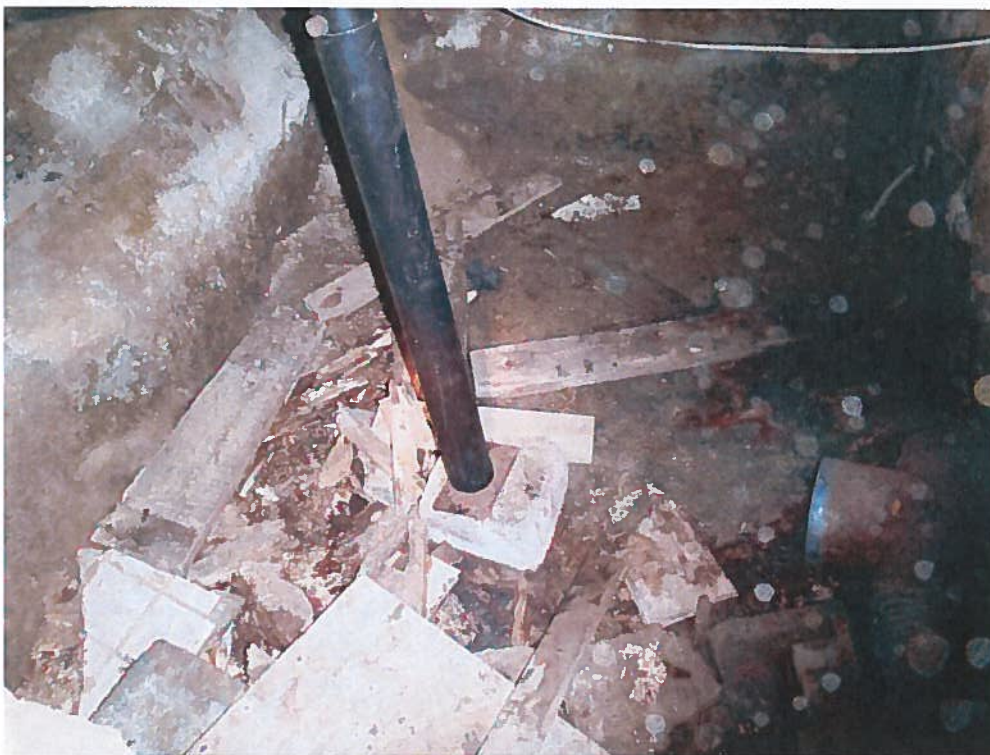
Photo 31 : Appui improvisé fait d'un vérin posé sur un pavé vers l'avant de la coupe faite dans la poutre
