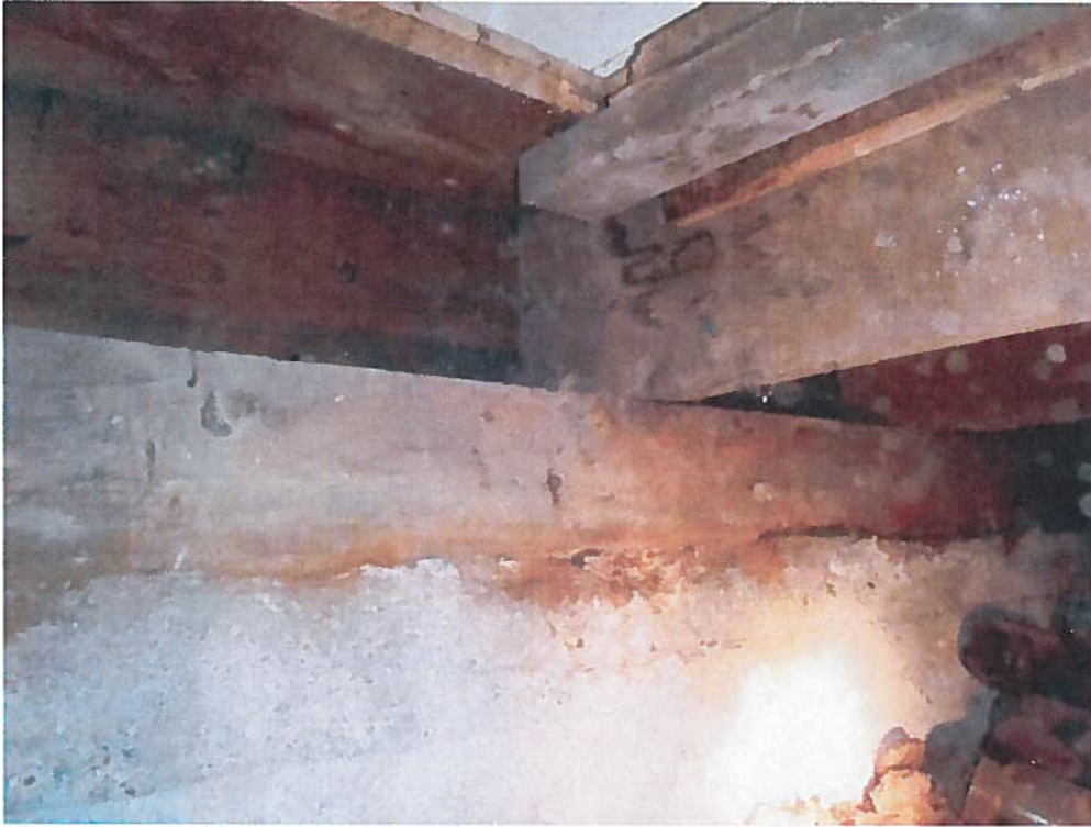
Photo 15 : Lisse d'assise pourrie où s'appuient les solives au mur mitoyen Nord
