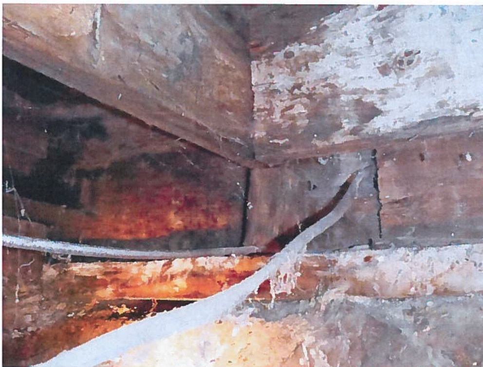
Photo 20 : Solive de rive et lisse d'assise tachées par la moisissure et pourries en façade avant
