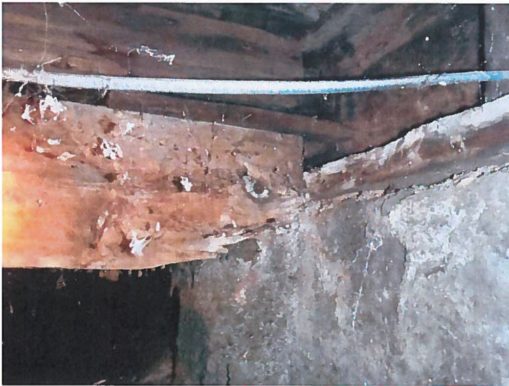
Photo 24 : Extrémité de la poutre maîtresse pourrie et écrasée à son appui au mur de fondation avant
