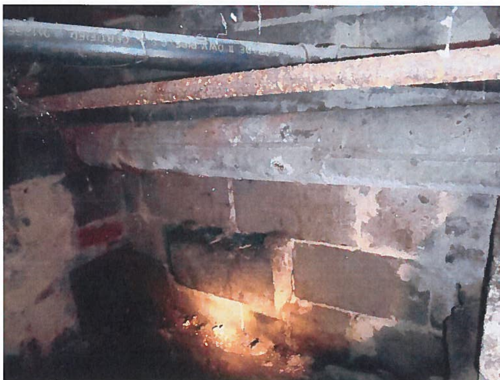
Photo 6 : Fondation de la section arrière avec bloc de béton déchaussé
