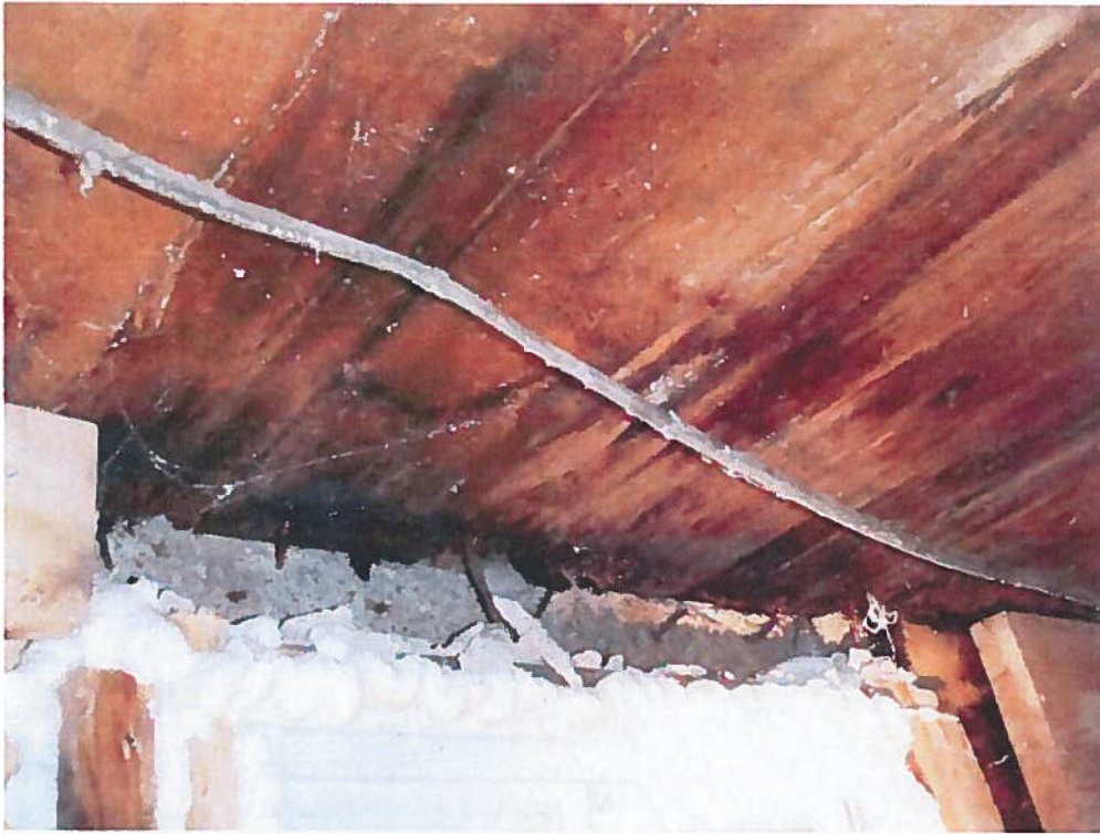
Photo 23 : Dégradation par la moisissure et la pourriture du sous-plancher en façade avant
