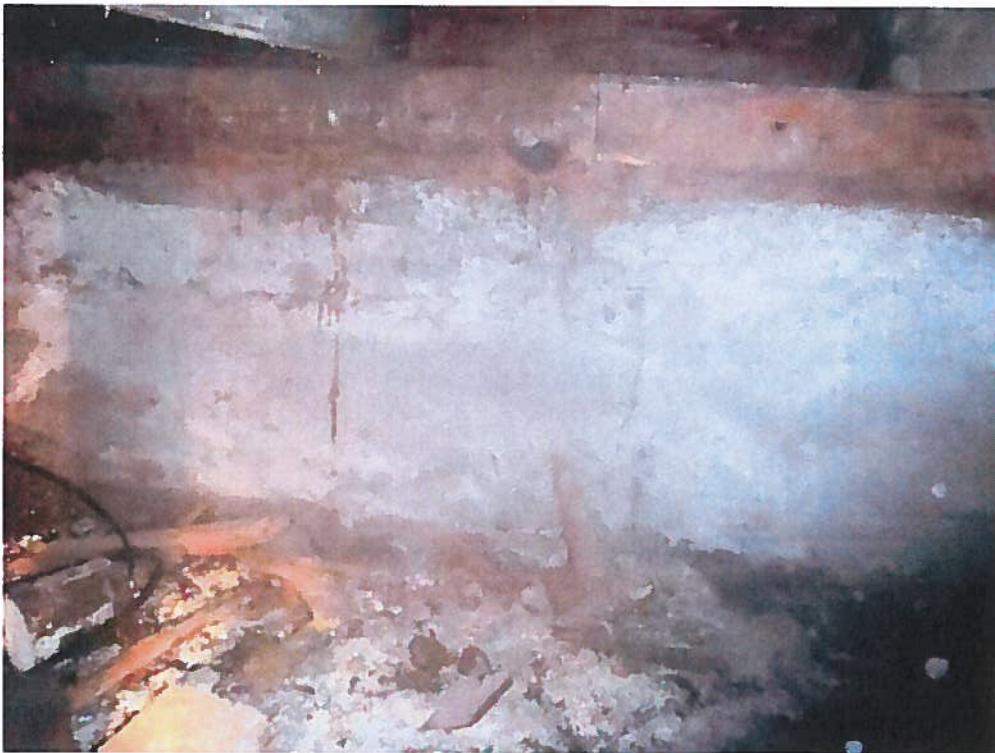
Photo 4 : Fissure au mur de fondation mitoyen Nord avec présence d'efflorescences
