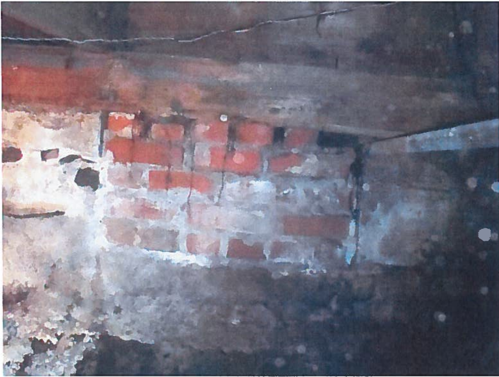
Photo 9 : Ouverture dans le mur de fondation arrière bouchée avec de la brique et solive de rive pourrie
