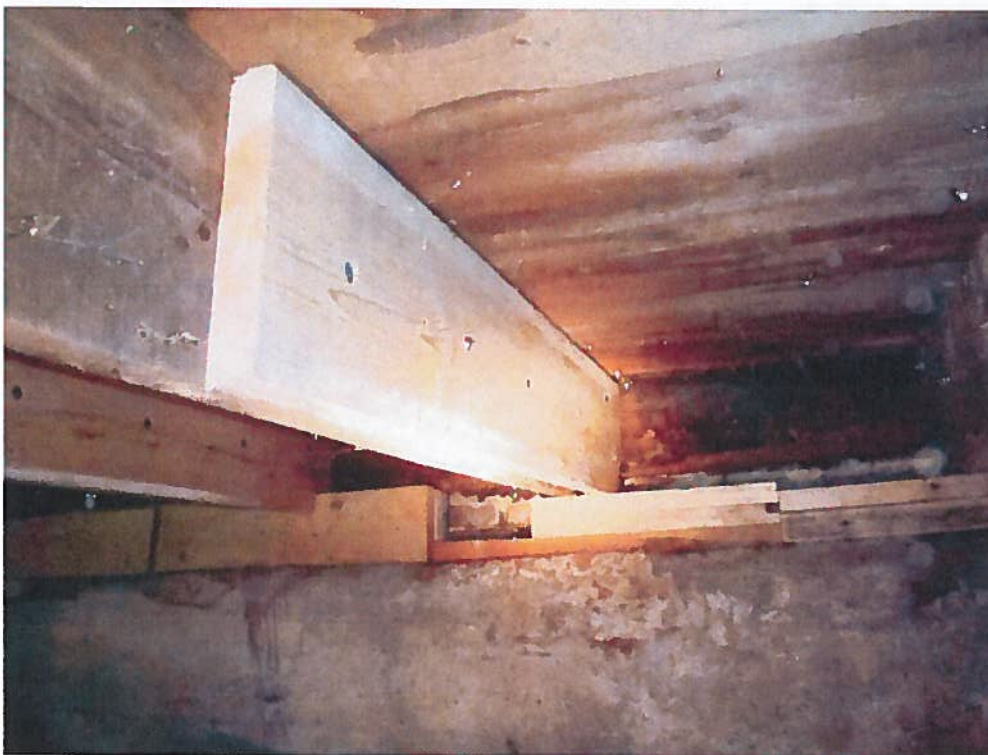
Photo 17 : Extrémité de solive pourrie doublée sur quelques pieds près de son appui au mur mitoyen Nord
