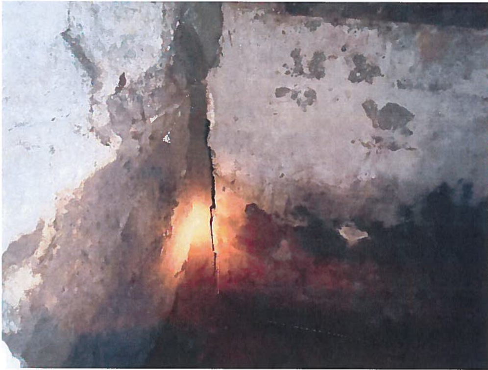
Photo 7 : Mur de béton de la section arrière déplacé par rapport au mur de fondation mitoyen Sud
