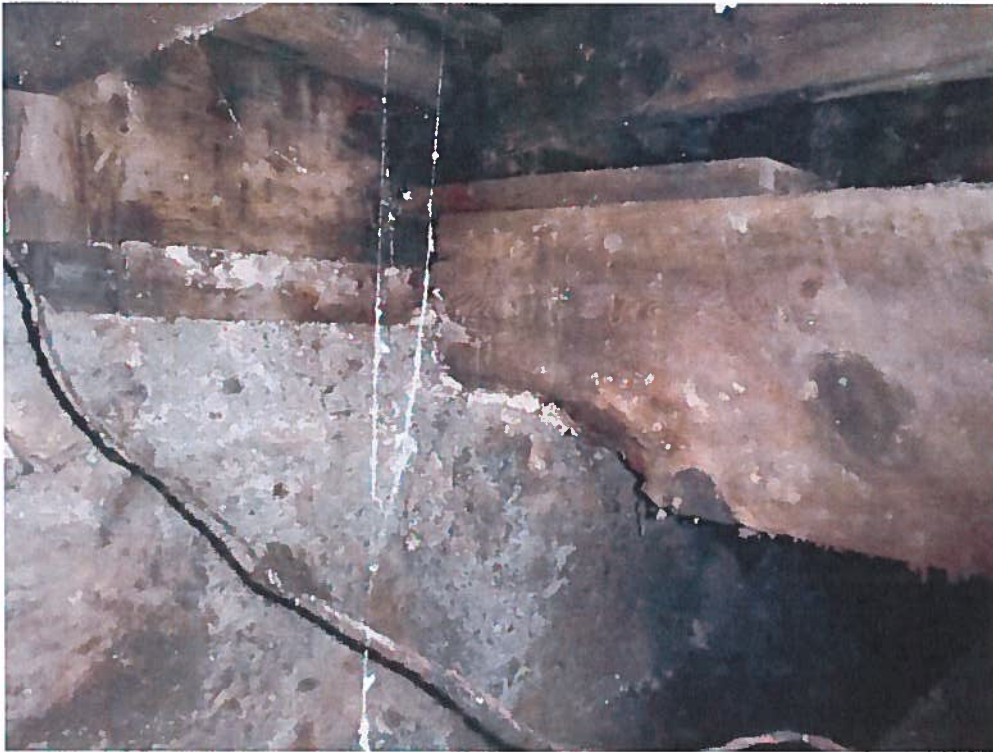
Photo 25 : Extrémité de la poutre maîtresse pourrie et écrasée à son appui au mur de fondation avant
