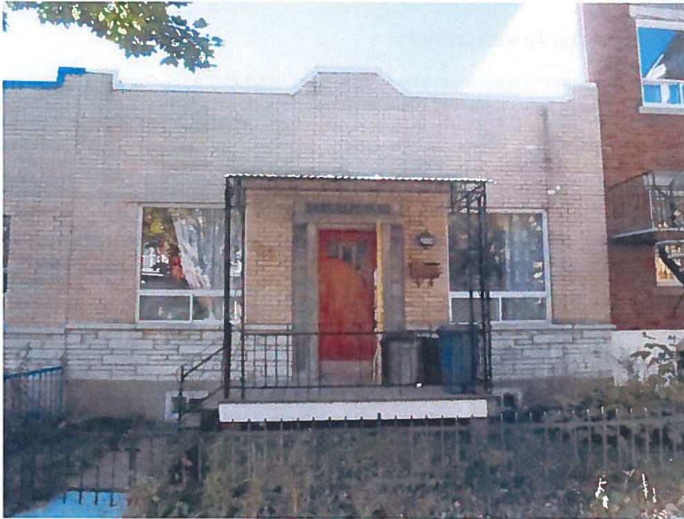
Photo 1 : Bâtiment d'un étage faisant l'objet de la présente inspection
