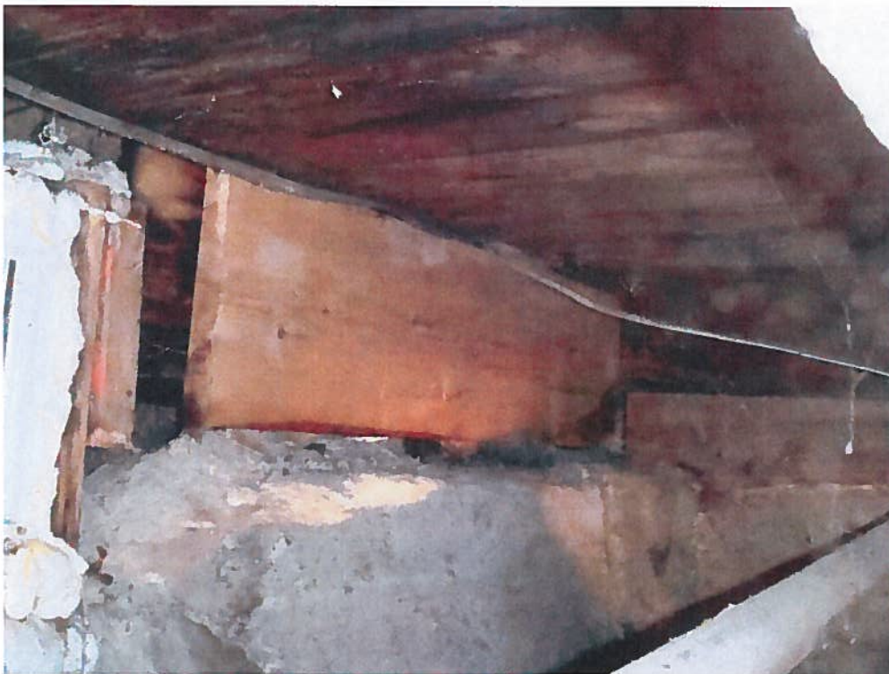
Photo 22 : Solive de rive et lisse remplacées sur quelques pieds par un 2" x 12" en façade avant
