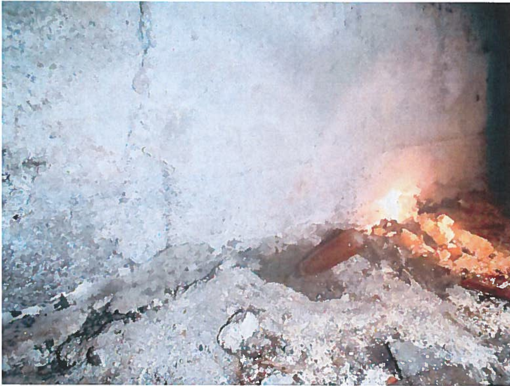
Photo 3 : Fondation mitoyenne Nord sans semelle et d'à peine 2' de haut avec efflorescences
