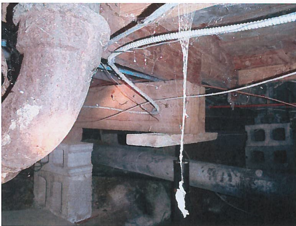
Photo 32 : Vérin et appui en blocs de béton situé en bordure de tranchée près d'où la poutre a été coupée
