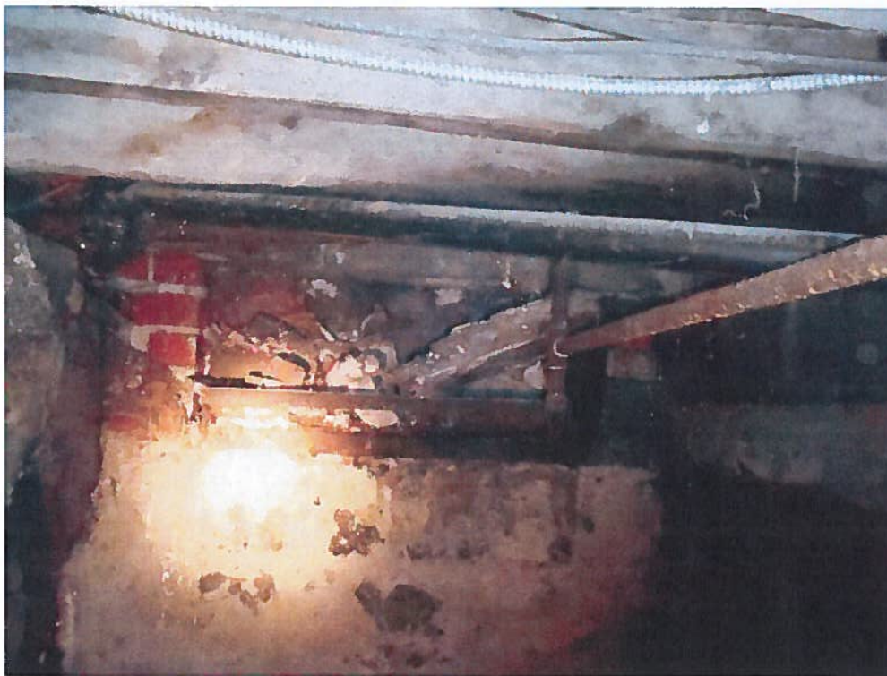
Photo 5 : Fondation sous l'ancienne cheminée en façade arrière avec trappe remplie de débris
