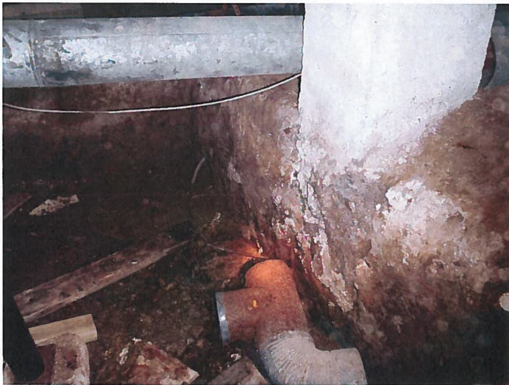
Photo 30 : Portion enterrée de la colonne de la photo 29 détériorée où elle est exposée par une excavation
