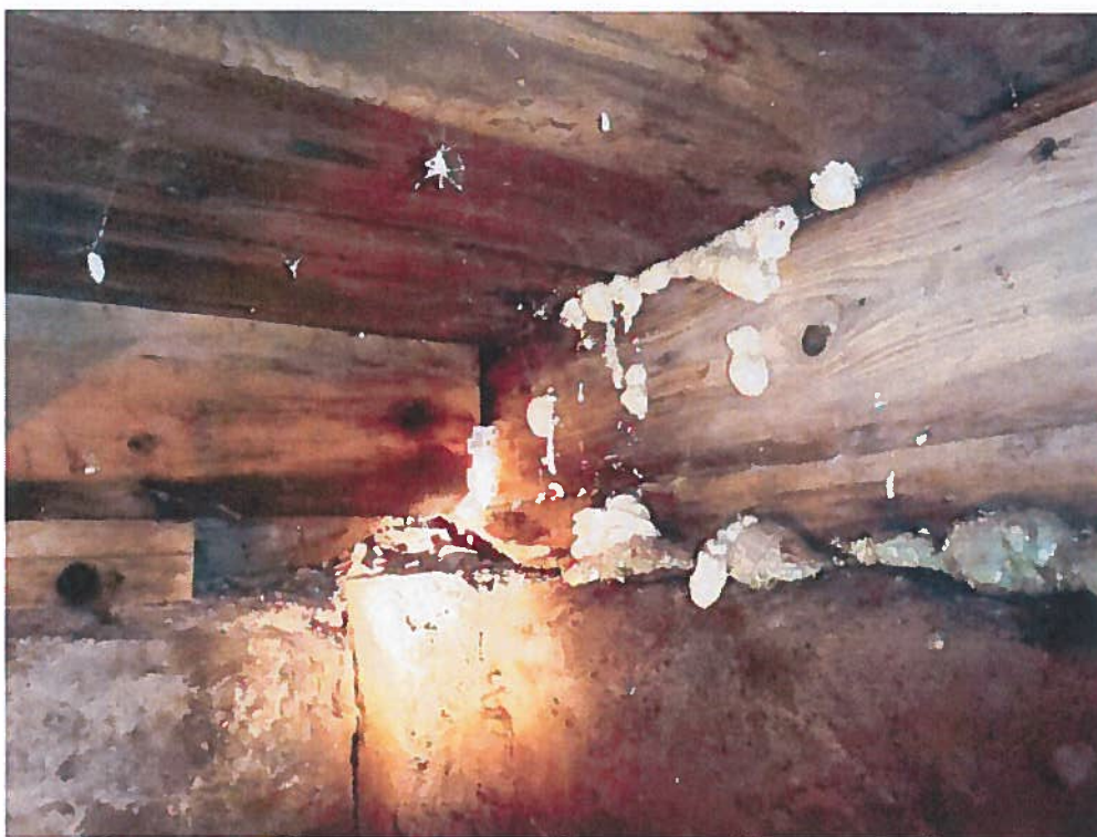
Photo 19 : Solives de rive et lisse d'assise tachées et pourries à la jonction des murs avant et mitoyen Nord
