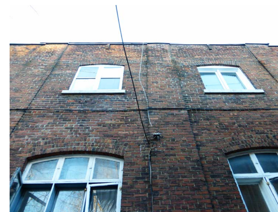
6 PHOTO - CÔTÉ (APRÈS INTERVENTION) A-500/ ÉCHELLE:
