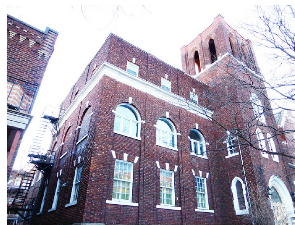
5 PHOTO (APRÈS INTERVENTION) A-500/ ÉCHELLE:
