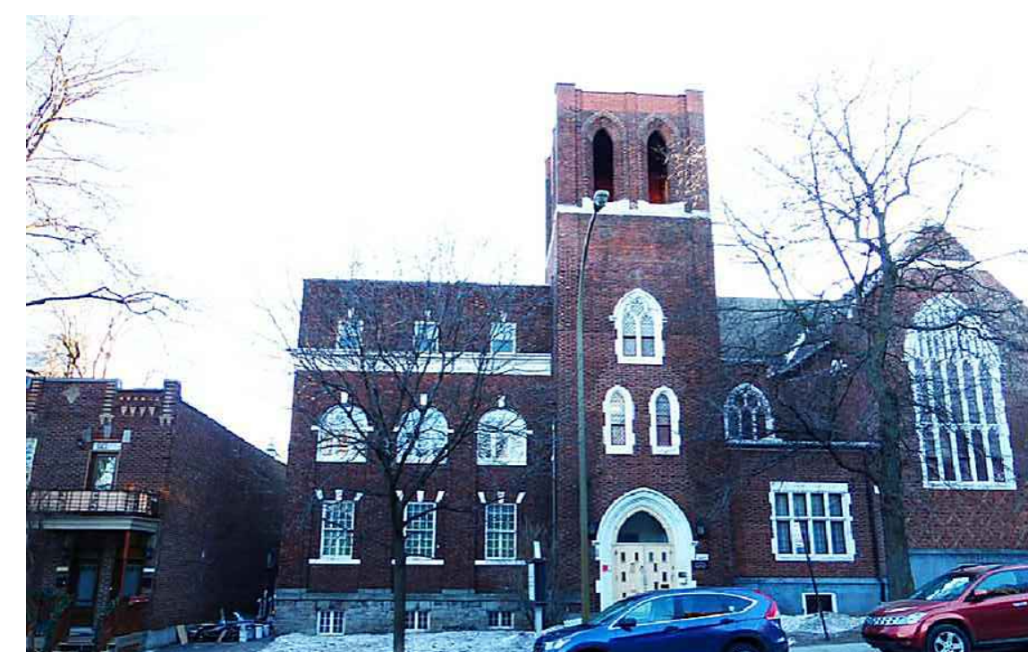
4 PHOTO (APRÈS INTERVENTION) A-500/ ÉCHELLE:
