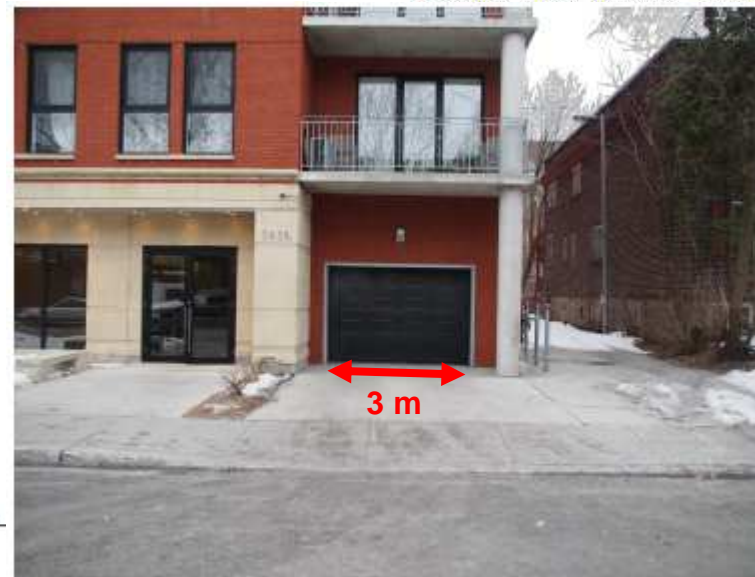
Porte de garage - existante
