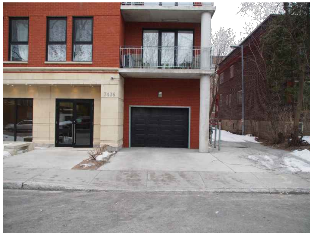
Porte de garage - existante
