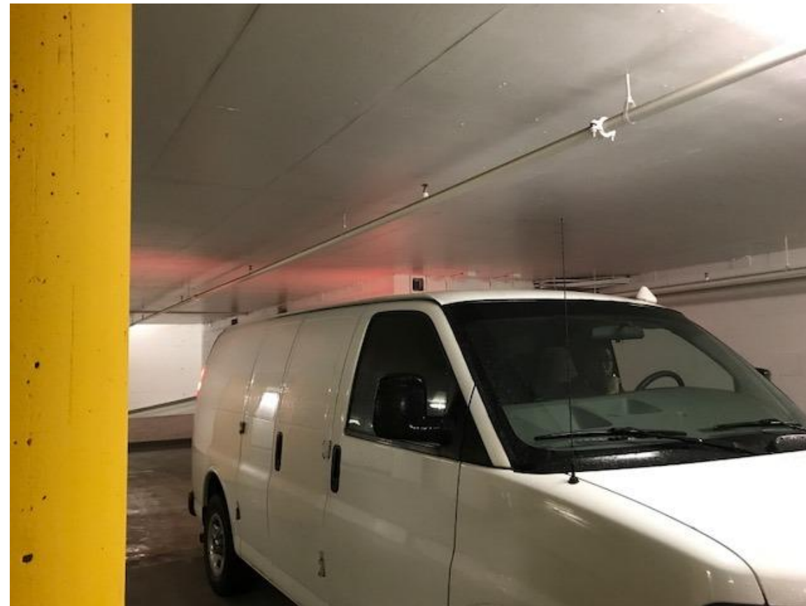
PHOTO 4 - AIRE DE CHARGEMENT
