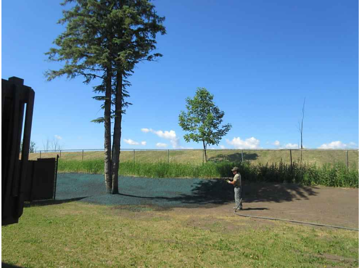
Ensemencement hydraulique (pulvérisation d'un mélange de semences, d'engrais et de paillis avec de l'eau) suite à l'excavation d'une zone infestée d'herbe à puce et de plantes indésirables.
