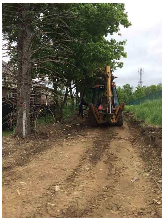
Excavation sur Paul-Pouliot.
