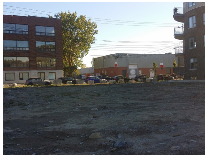
Photo 4 : Rue Saint-Ambroise et bâtiments commerciaux (Vue vers le sud)
