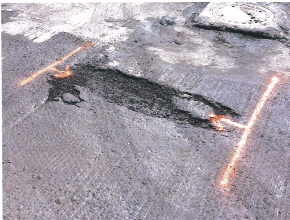
Rue Alexis Nihon, Arrondissement de Saint-Laurent Correction en profondeur
