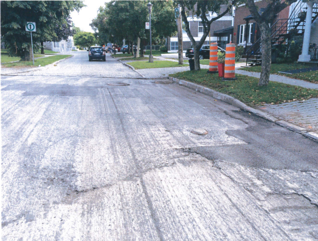
15 e Avenue, Arrondissement de Lachine Correction en profondeur
