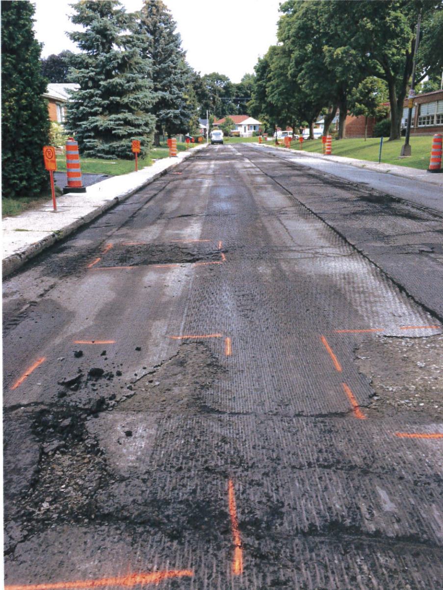
52 e Avenue, Arrondissement de Lachine Correction en profondeur
