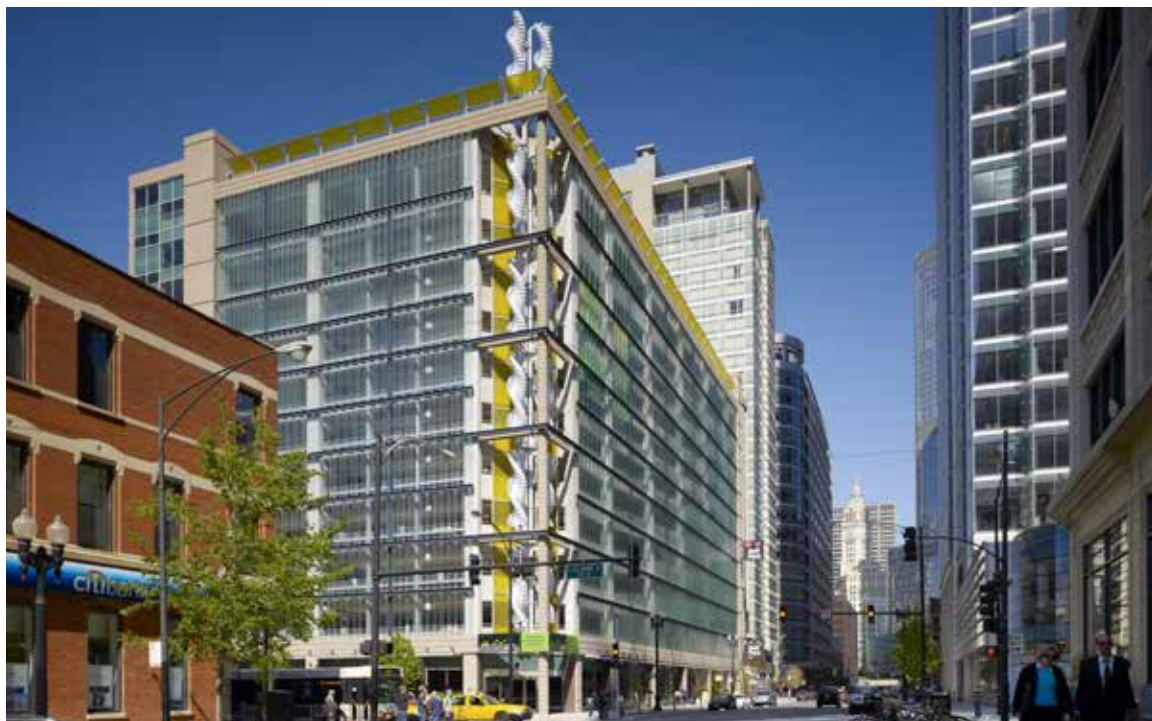
Crédit : Walker Parking Consultants
