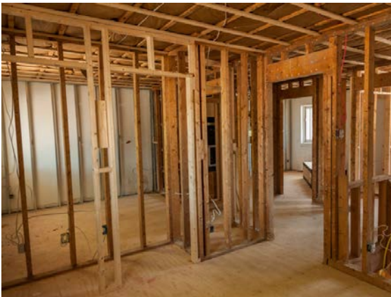
Un logement en travaux de modernisation
