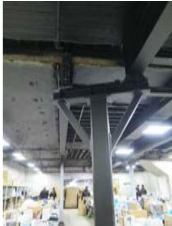
**[148]** Une colonne qui supporte des poutres sur deux axes différents (SDB, 2021, 8838)
