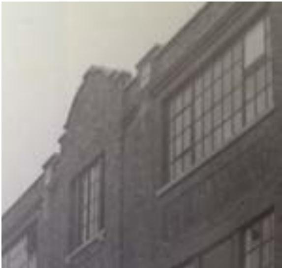
[67] Un détail de la photo au-dessus [63], montrant les rectangles de briques sous les fenêtres, les fenêtres de métal avec leurs linteaux de briques en soldat et leurs allèges de pierre artificielle, et les motifs de pierre artificielle dans la partie supérieure de chaque pilastre (Communauté urbaine de Montréal, *Op. cit.*)
