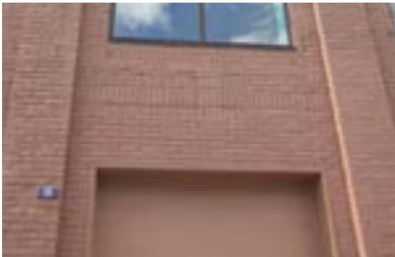
**[102]** Des briques de remplacement installées dans le mauvais sens (SDB, 2021, 9354)
