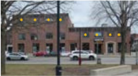
[82] La façade principale sur le boulevard Saint-Laurent, où la plupart des fenêtres d'origine ont été remplacées par des fenêtres agrandies vers le bas; les ouvertures de proportions horizontales d'origine qui restent (\*) ont des fenêtres fixes avec de petites sections coulissantes dans la partie inférieure qui datent des années 1980 ou 1990; les quatre fenêtres dans la partie nord du 2<sup>e</sup> étage ont été agrandies vers le bas avant 2007 (SDB, 2021, 9071)
