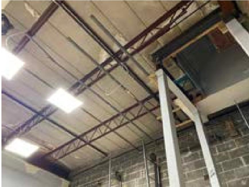
Photo – Toit du volume d'un étage en poutrelles d'acier et dalles de Siporex
