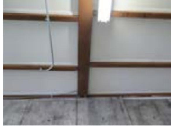
**[171]** Un détail du plafond, avec des planches de bois, des poutres d'acier et du filage électrique exposé (SDB, 2021, 8778)
