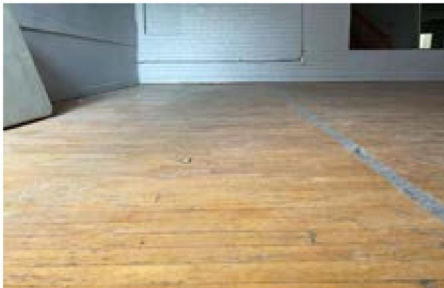
Photo – Dalle de classe montrant un affaissement au deuxième étage
