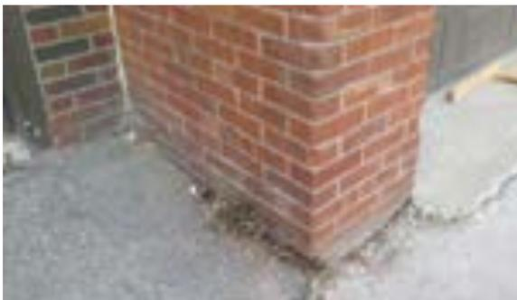
[130] Les briques endommagées et les joints sans mortier dans la partie inférieure du mur, côté sud (SDB, 2021, 9329)
