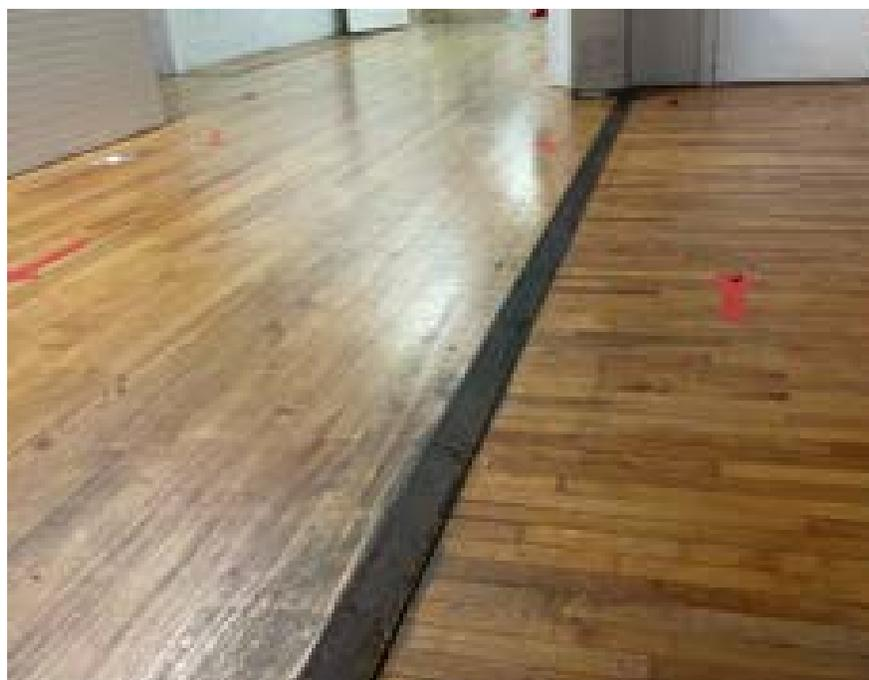
Photo – Dalle de classe montrant un affaissement au deuxième étage
