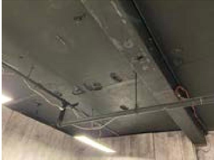
Photo – Structure de plancher en béton armé dans un secteur du rez-de-chaussée qui montre un écaillage du béton et de l'armature exposée
