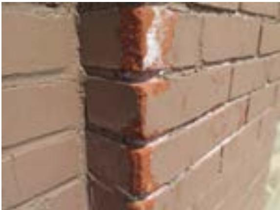
[90] Les problèmes d'effritement de la brique provoqués par sa peinture; on voit aussi les joints qui sont réparés d'une manière inappropriée (SDB, 2021, 9384)
