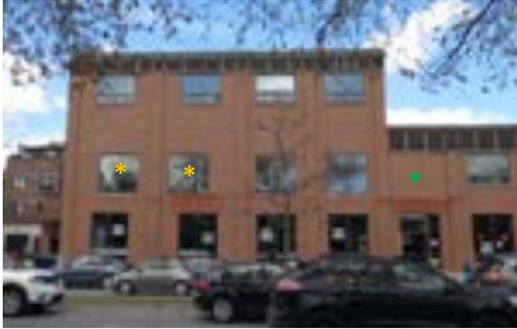
**[69]** Les deux nouvelles ouvertures de fenêtres percées vers 1978 (\*), qui ne sont pas alignées avec les ouvertures des fenêtres du rez-de-chaussée et du 3<sup>e</sup> étage, telles que montrées dans le dessin de permis **[68]** (ces fenêtres ont été agrandies vers le bas depuis); l'autre nouvelle fenêtre proposée **[68]** n'a jamais été installée (\*) (SDB, 2021, 9439)
