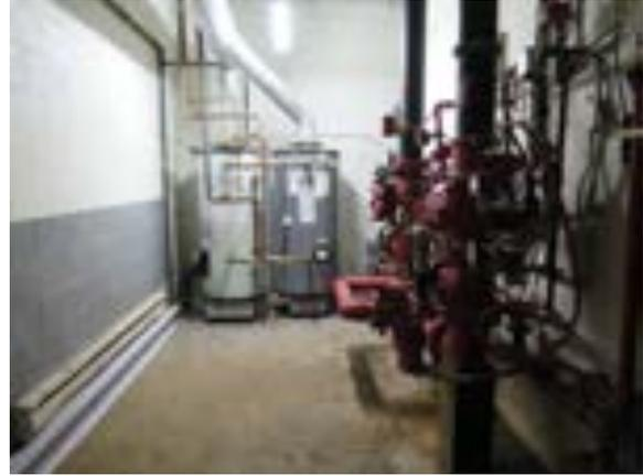
[151] La salle mécanique, située du côté sud du rez-de-chaussée, où on retrouve les réservoirs d'eau chaude et les contrôles du système de gicleurs (SDB, 2021, 8821)
