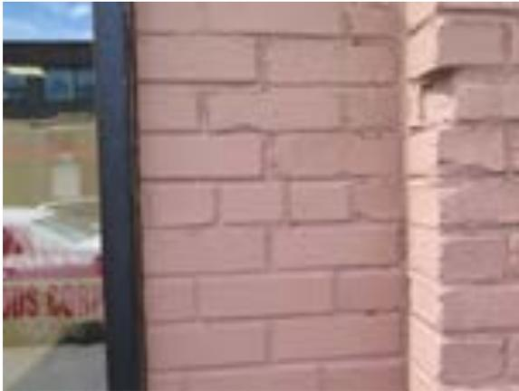
**[101]** Des briques endommagées et une série de fissures qui ont été mal réparées (SDB, 2021, 9359)
