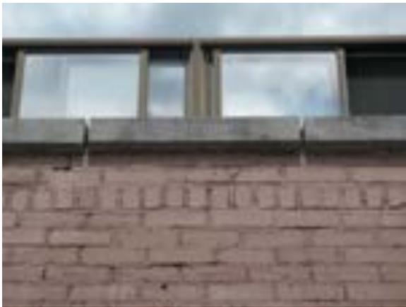
**[107]** Une allège sans mortier dans ses joints et des joints mal réparés en dessous (SDB, 2021, 9376)
