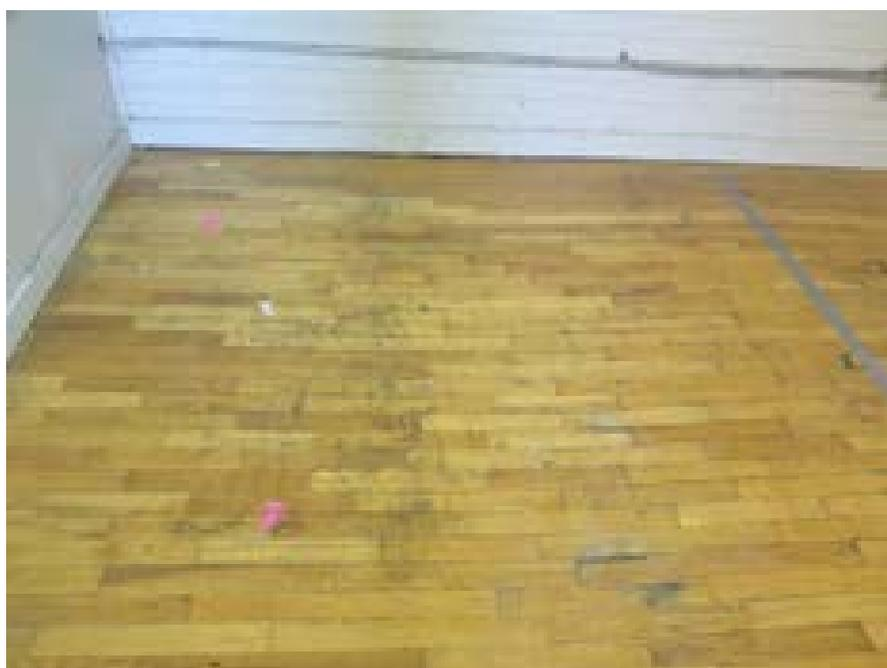
Photo – Coin d'une salle de classe montrant un affaissement au deuxième étage
