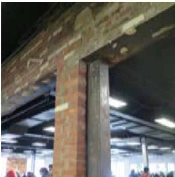
**[141]** Une section d'un ancien mur de brique dont les grandes ouvertures sont renforcées par des éléments d'acier (SDB, 2021, 8856)
