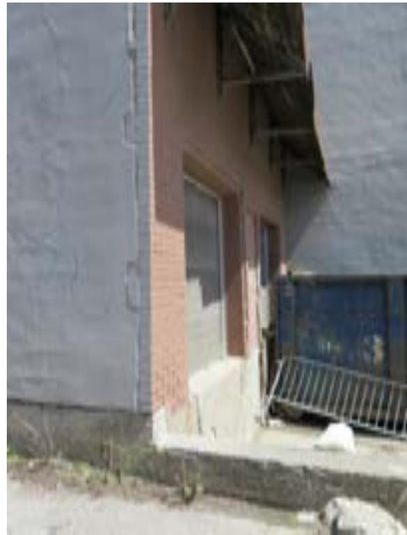
**[124]** La jonction maladroite entre la brique de la façade du quai de déchargement et son mur nord en bloc de béton, fini avec du crépi peint, et la condition de la structure en acier qui supporte l'auvent en papier goudronné (SDB, 2021, 9419)
