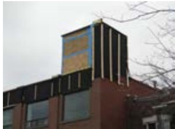
**[105]** Un détail du treillis de protection et des renforts autour de la partie supérieure du monte-charge sur la rue Faillon (SDB, 2021, 9108)
