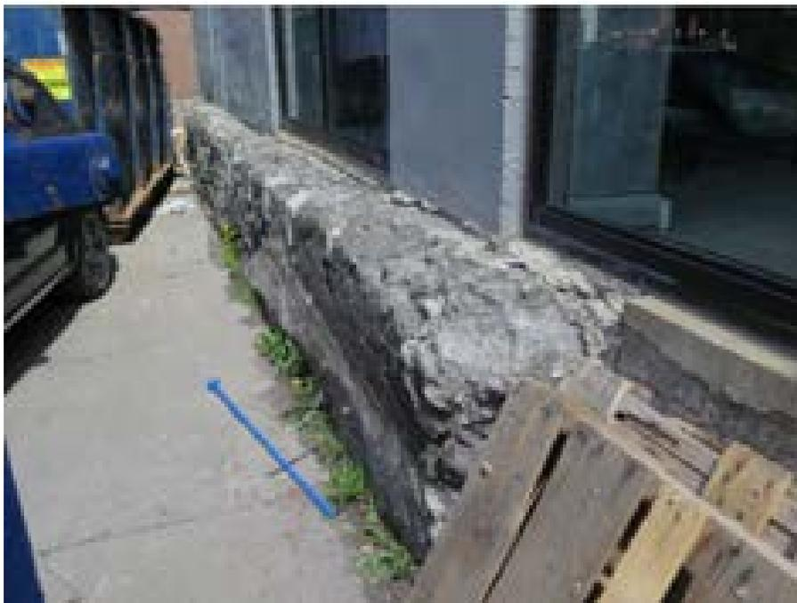
Photo – Mur de fondation en mauvais état du côté du quai de livraison
