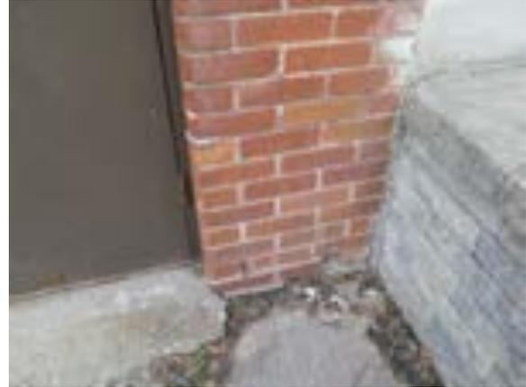
[131] Les briques endommagées et manquantes et les joints mal réparés et sans mortier dans la partie inférieure du mur, côté nord (SDB, 2021, 9331)
