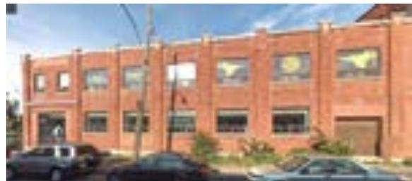
**[51]** Une vue de la portion d'origine de la façade secondaire sur la rue Faillon en octobre 2007, avant l'agrandissement des fenêtres, la peinture de la brique et la simplification du couronnement; les fenêtres ne sont pas d'origine et l'ouverture de fenêtre du rez-de-chaussée au coin a déjà été agrandie (Google Street View, octobre 2007)
