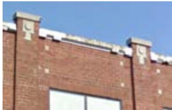
**[52]** Un détail du couronnement sur la rue Faillon, avec ses éléments décoratifs en pierre artificielle qui couronnent les pilastres, son solin en trois couches, son rectangle en brique avec des coins en carrés de pierre artificielle et la rangée de briques en soldat au-dessus de la fenêtre, en 2009 (Google Street View, avril 2009)
