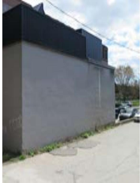
**[127]** Les irrégularités dans la surface de crépi du mur nord du quai de déchargement, surmonté d'un écran acoustique (SDB, 2021, 9415)
