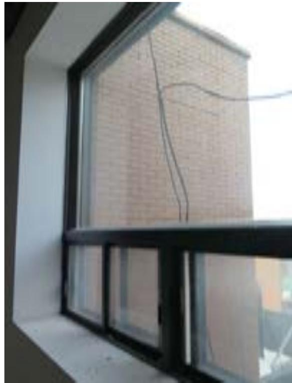
**[198]** Un détail des fenêtres de cet étage, de modèle fixe avec des petites sections coulissantes, qui ont remplacées les fenêtres d'origine dans les années 1980 ou 1990 (SDB, 2021, 8702)
