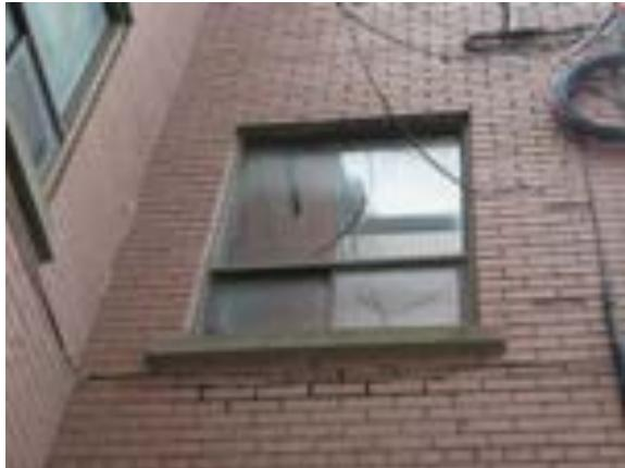
**[87]** Le petit mur est (arrière) qui donne sur la ruelle possède une ouverture de fenêtre de proportions plus verticales que les autres ouvertures d'origine; celle-ci a une fenêtre fixe et coulissante qui date des années 1980 ou 1990 (SDB, 2021, 9417)
