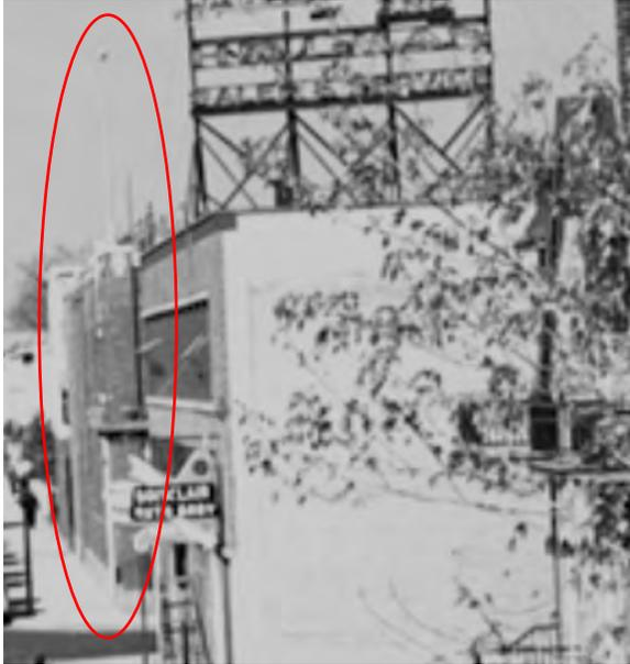
**[43]** Un détail d'une photo du boulevard Saint-Laurent prise vers 1955 **[24]**, avant ou pendant l'expansion sur les lots vers le nord; on y voit les détails du couronnement, avec ses éléments en pierre artificielle, ainsi qu'un mât (Armour Landry, vers 1955, BAnQ, P97,S1,D15410-15410)
