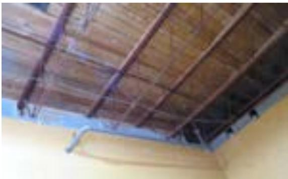
[190] Le plafond de l'escalier et la structure du toit en acier et en bois (SDB, 2021, 8691)
