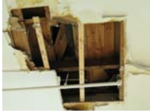
**[186]** Un trou dans le plafond qui montre la structure de bois de la toiture du bâtiment d'origine (SDB, 2021, 8907)
