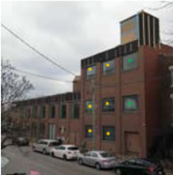
[83] La façade secondaire sur la rue Faillon, où toutes les fenêtres dans la section de deux étages ont été agrandies vers le bas (vers 2009 au 2<sup>e</sup> étage et entre 2011 et 2014 au rez-de-chaussée); les seules ouvertures de fenêtres d'origine sont dans la section de trois étages, et elles ont des fenêtres fixes (\*) ou fixes avec une petite section coulissante dans la partie inférieure (\*) datant des années 1980 ou 1990 (SDB, 2021, 9106)
