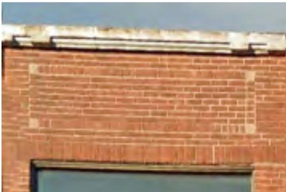
**[48]** Une photo de 2011, montrant les détails des rectangles de briques entourés de briques carrées, avec des carrés de pierre artificielle aux quatre coins, ainsi que les briques en soldat au-dessus de la fenêtre; on y voit aussi les détails des solins d'origine (Google Street View, octobre 2011)
