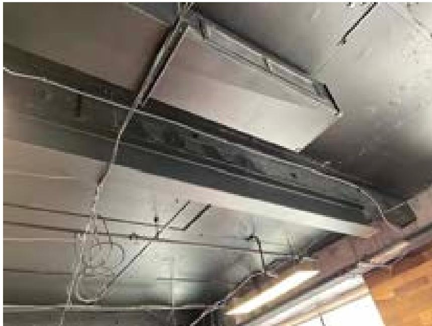
Photo - Poutre maîtresse au plafond du rez-de-chaussée ayant été renforcée avec un autre élément d'acier. Témoignage supposé du retrait d'un axe porteur antérieur.
