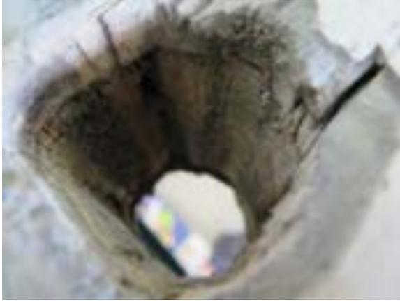
**[169]** Un trou entre les espaces du gym du rez-de-chaussée et du 2<sup>e</sup> étage, montrant la structure en bois du plancher du 2<sup>e</sup> étage (SDB, 2021, 8779)
