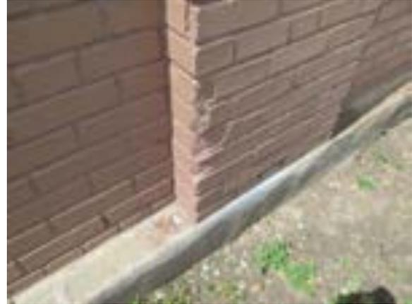
**[97]** Des coins des pilastres avec des briques endommagées et peintes pour cacher les défauts (SDB, 2021, 9348)
