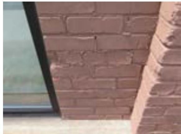
**[99]** Des briques endommagées et des joints mal réparés (SDB, 2021, 9357)
