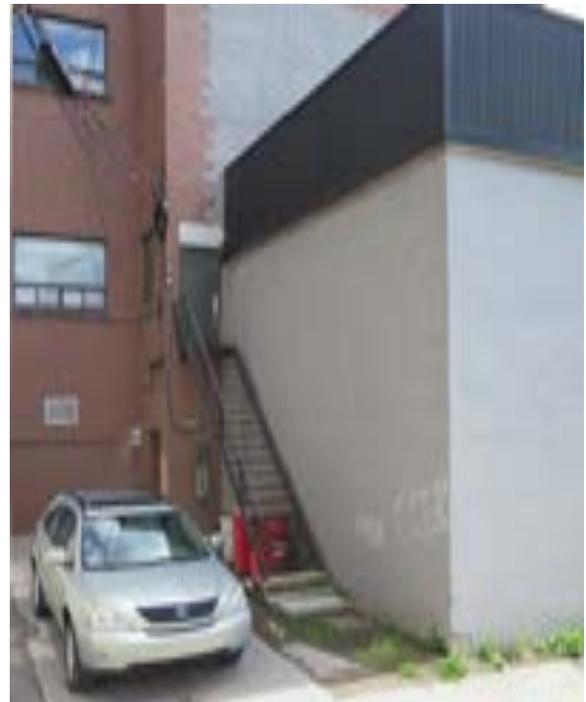
**[128]** Le mur est du quai de déchargement, en blocs de béton revêtus de crépi, également surmonté d'un écran acoustique; un escalier d'une sortie d'urgence en acier peint le longe (SDB, 2021, 9413)
