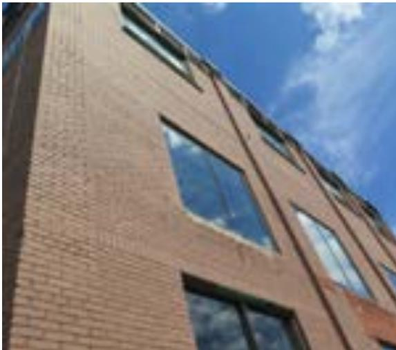
**[70]** Le mauvais alignement de l'ouverture de la fenêtre dans la première section au 2<sup>e</sup> étage (SDB, 2021, 9400)
