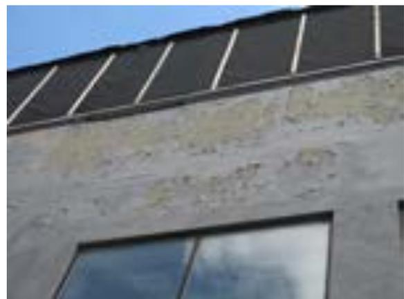
**[121]** Un détail du treillis de protection sur la partie supérieure du mur, où la peinture sur le crépi s'enlève (SDB, 2021, 9405)
