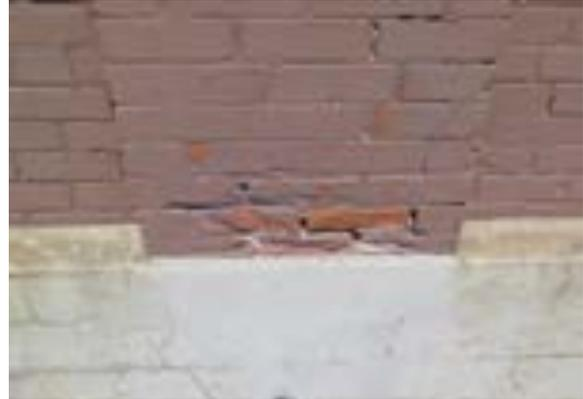
[91] Les briques qui ont perdu leur surface extérieure dure en raison de l'infiltration d'eau entre la peinture et la brique; on voit aussi des joints mal réparés et sans mortier (SDB, 2021, 9392)
