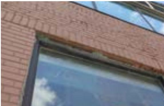
**[81]** Un détail typique montrant la mauvaise installation des vitrines au rez-de-chaussée au niveau des linteaux (SDB, 2021, 9366)
