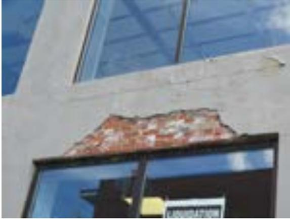
**[122]** Une section de crépi qui s'enlève, exposant la brique; on voit aussi des signes d'infiltration d'eau sous la fenêtre supérieure (SDB, 2021, 9404)
