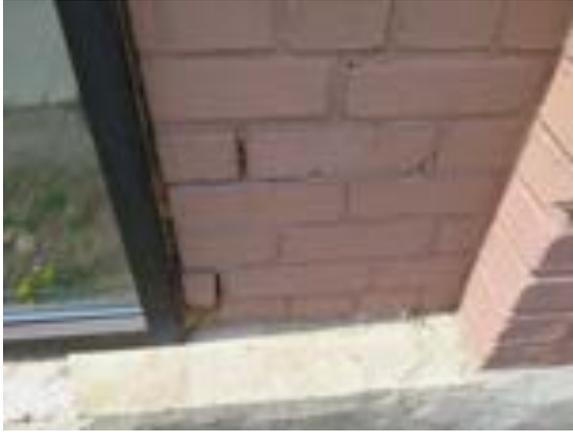
**[100]** Un des nombreux exemples de joints vides et de la maçonnerie mal réparée après l'installation des nouvelles fenêtres (SDB, 2021, 9358)
