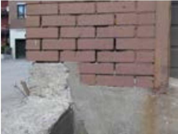
**[126]** Des joints sans mortier et mal réparés de la façade de brique peinte, ainsi que des cadres de porte rouillés et des réparations provisoires et inappropriées du mur de fondation (SDB, 2021, 9408)
