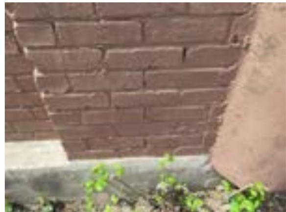
**[98]** Des joints mal réparés (SDB, 2021, 9356)
