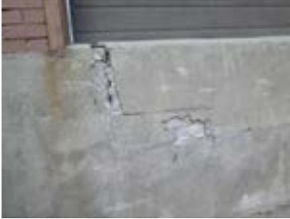
**[125]** Le mur de fondation, en partie (au moins sous les portes) fini en brique revêtu de crépi; les multiples fissures, les sections manquantes et les signes de réparations antérieures du crépi suggèrent que la structure a peut-être bougé avec le temps (SDB, 2021, 9407)
