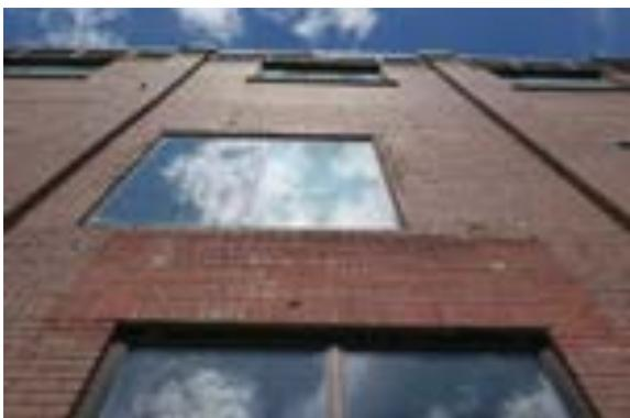
**[71]** Le mauvais alignement de la fenêtre dans la deuxième section (SDB, 2021, 9397)
