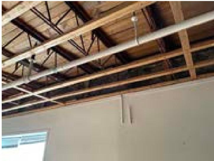
Photo – Structure de toit en poutrelles d'acier et platelage de bois
