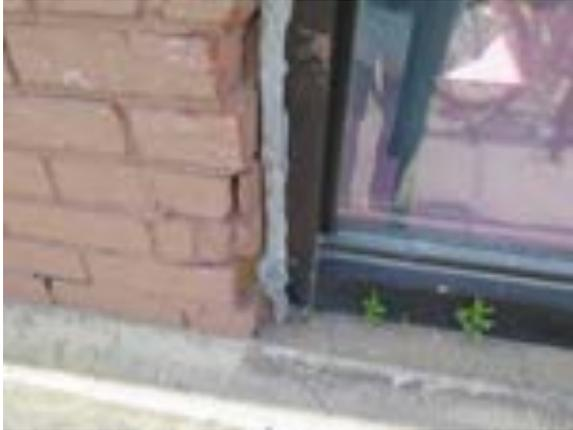
**[79]** La qualité inappropriée des réparations de la maçonnerie et de l'installation de calfeutrage lors de l'installation des vitrines du rez-de-chaussée vers 1978 et depuis (SDB, 2021, 9367)
