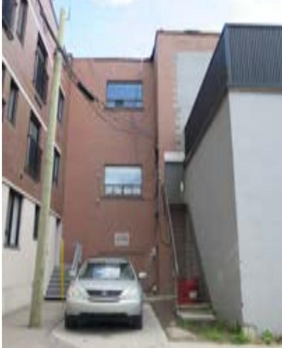
**[86]** Le mur nord au bout de la ruelle, derrière le quai de déchargement, possède ses ouvertures d'origine, avec des fenêtres fixes et coulissantes datant des années 1980 ou 1990 (SDB, 2021, 9412)
