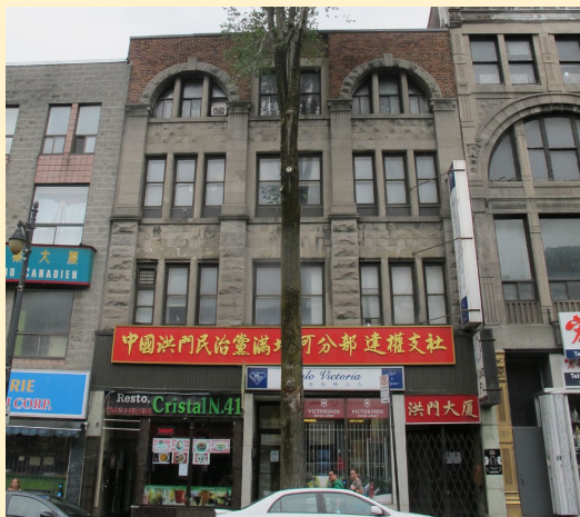
Édifice Drapeau et Savignac 1068-1072, boulevard Saint-Laurent Photo : Luce Lafontaine Architecte
