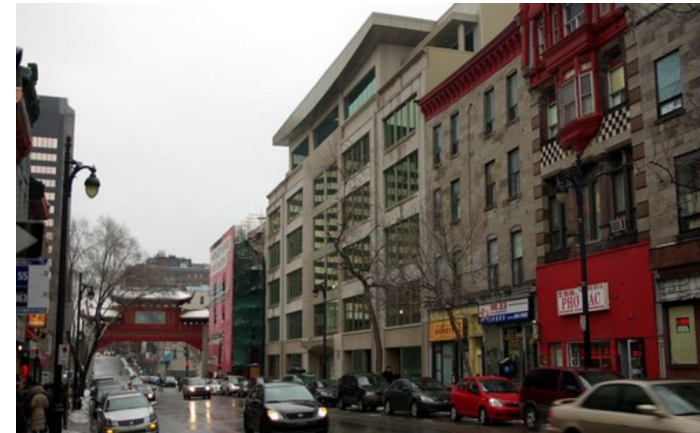
Construction de la Plaza Swatow, 2009 (spacing.ca) Extrait de l'étude de Luce Lafontaine, architecte.
