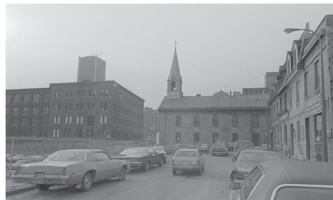
Vue de la rue De La Gauchetière vers l'église avant la construction du Complexe Guy-Favreau, 1977 (BANQ) Extrait de l'étude de Luce Lafontaine, architecte.
