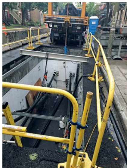
Installation d'une chambre de jonction
