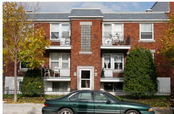
Situation avant travaux (a.2005)
