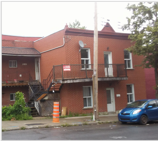
Photo de la façade montrant le parapet- 2017
