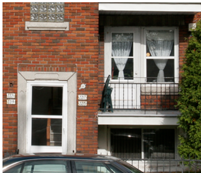
État avant les travaux - Ouverture type donnant sur un balcon
