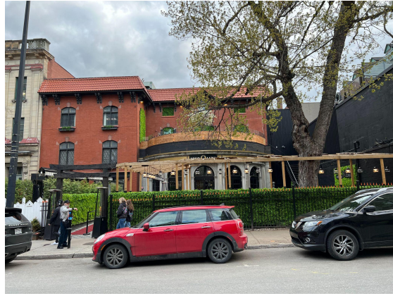
État actuel - Façade rue de la Montagne
