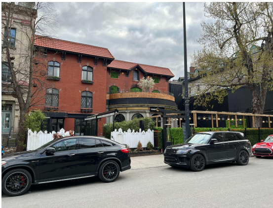
État actuel - Façade rue de la Montagne
