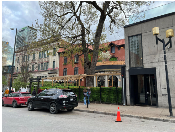
État actuel - Façade rue de la Montagne
