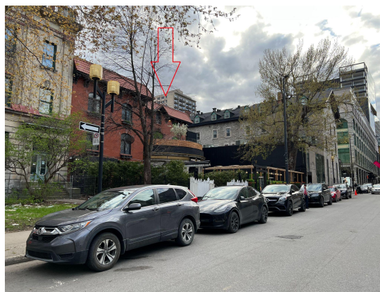
État actuel - Emplacement, rue de la Montagne
