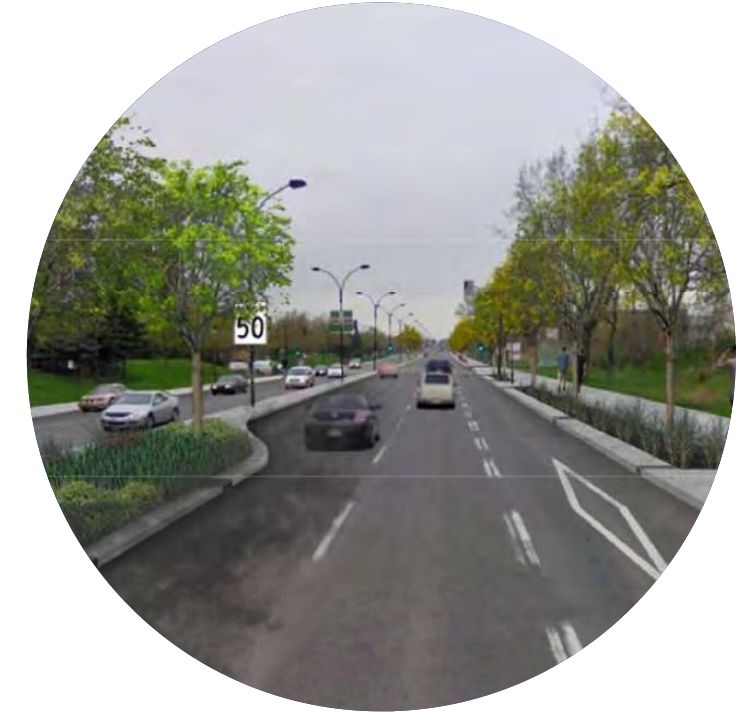
Avenue Papineau, Montréal, axe « rive-rive » réaménagé pour intégrer des infrastructures vertes visant la biorétention des eaux pluviales
