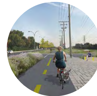
Réaménagement aux abords du poste de transformation Saint-Jean d'Hydro-Québec à Dollard-des-Ormeaux Source: Hydro-Québec
