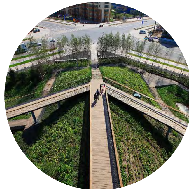
Qunli Stormwater Wetland Park, Chine, valorisation d'un parc par la mise en place d'un ancrage à la rue
