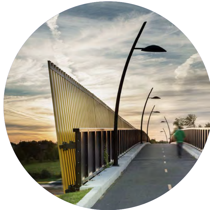
Passerelle multifonctionnelle au-dessus de l'A-15, Candiac, reliant deux secteurs de la ville par un lien actif sécuritaire, efficace et convivial
