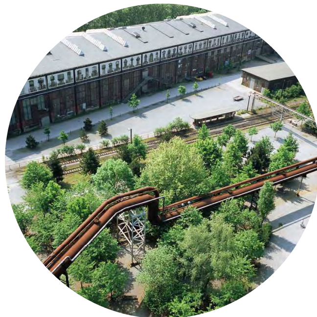
Landschaftspark Duisburg Nord, Duisburg, Allemagne, valorisation des pipelines comme monument structurant l'aménagement paysager Source: Micheal Latz
