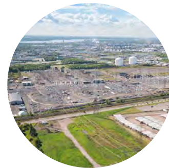
Poste de transformation du Bout-de-l'Île d'Hydro-Québec à RDP-PAT Source: Hydro-Québec
