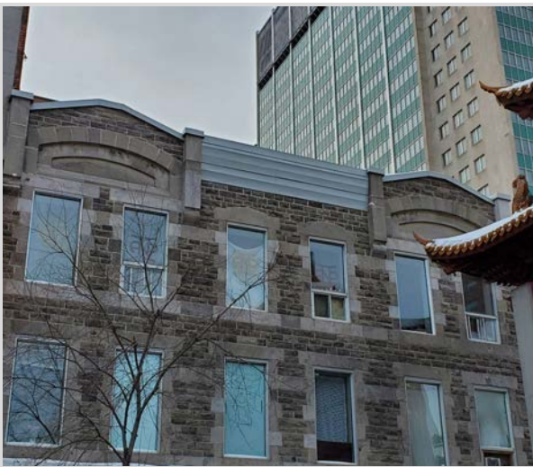
Photo de la façade après les travaux
