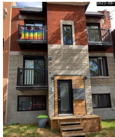
Situation actuelle (après travaux)
