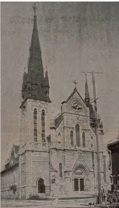
L'église avant l'incendie de 1922 (*photo date inconnue)
