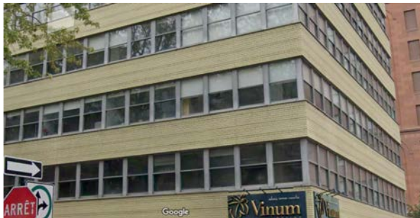
Bandeau de fenêtres d'origine et existant
