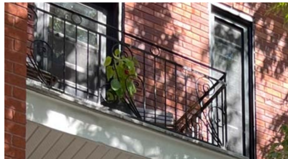
balcon existant 3e niveau
