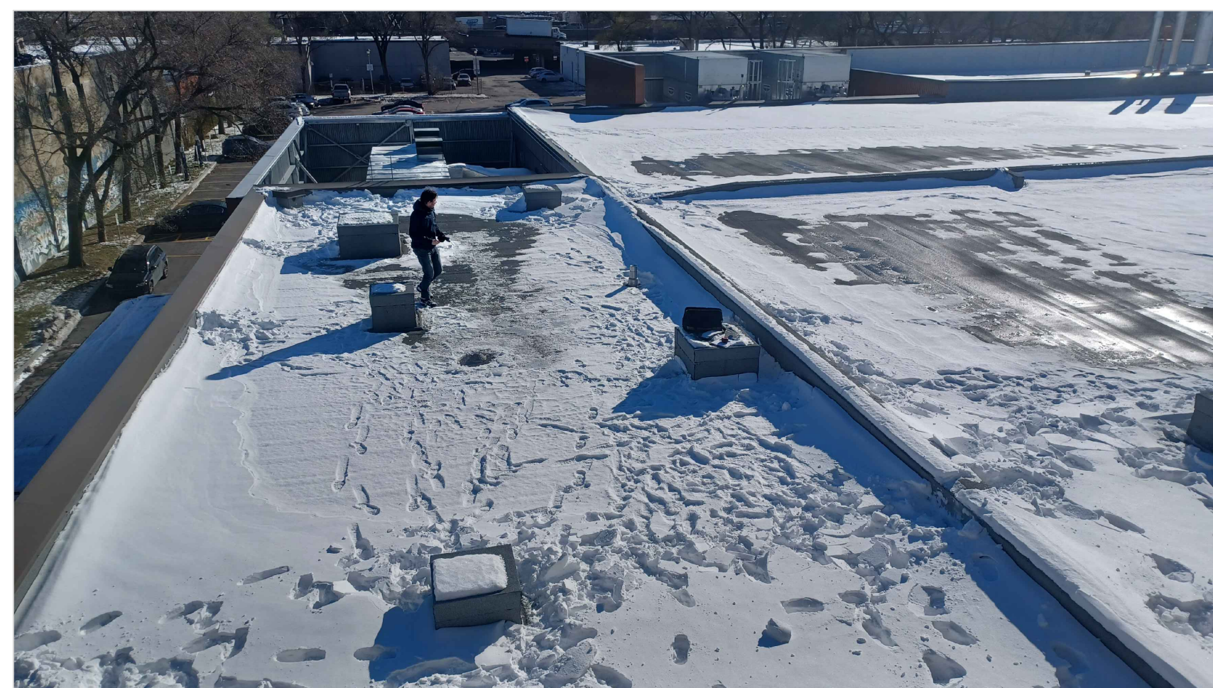
PHOTO #2 - EMPLACEMENT DES CONDUITS SUR LE TOIT
