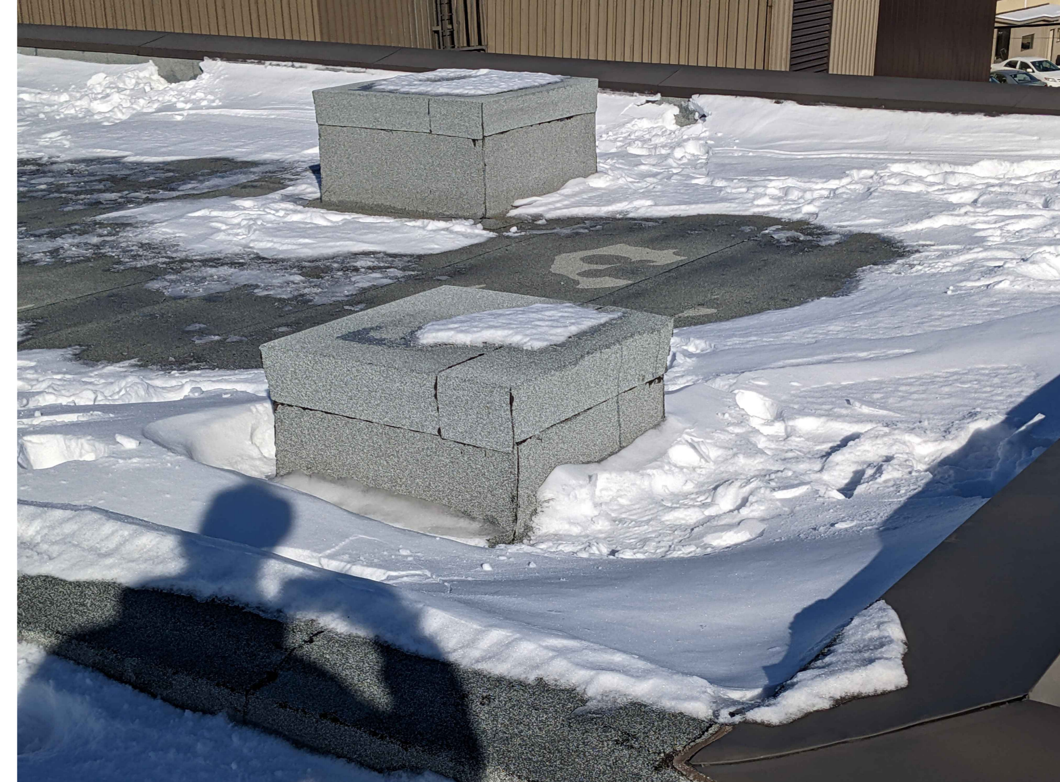
02 OUVERTURES AU TOIT EXISANTES OBTURÉES A190 ECH.: 1 : 10
