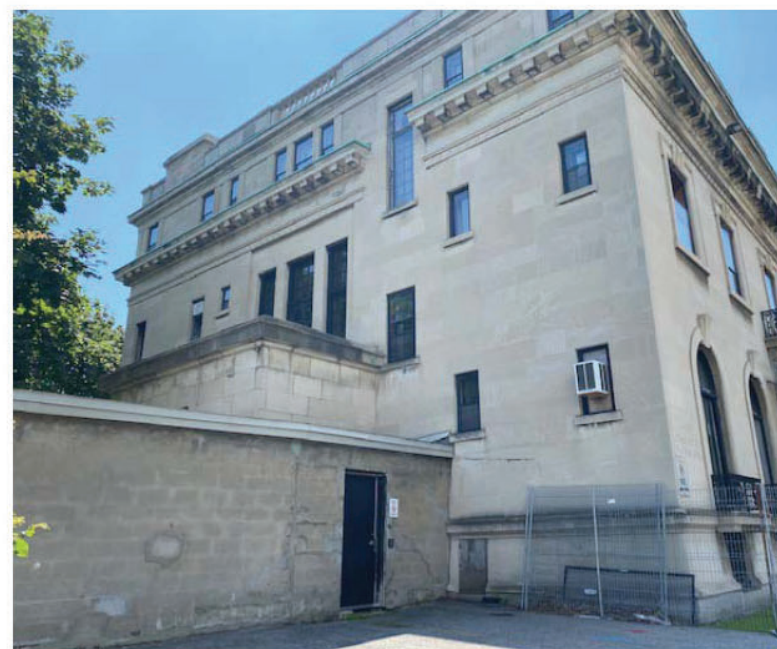
Photo du Tunnel existant qui sera démoli (côté Purvis)
