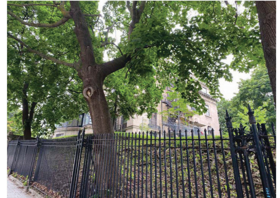
La clôture existante et son socle de pierre entourant une partie de la propriété, sont à restaurer et/ou préserver.
