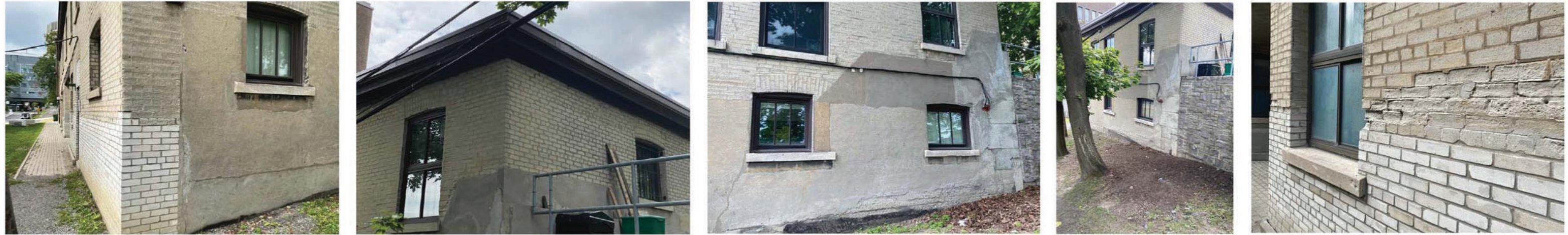
Images démontrant l'état existant des briques de l'annexe, menant au besoin de remplacement de celles-ci. Voir section 3.12 du document pour la brique proposée qui s'agence à la brique existante.
