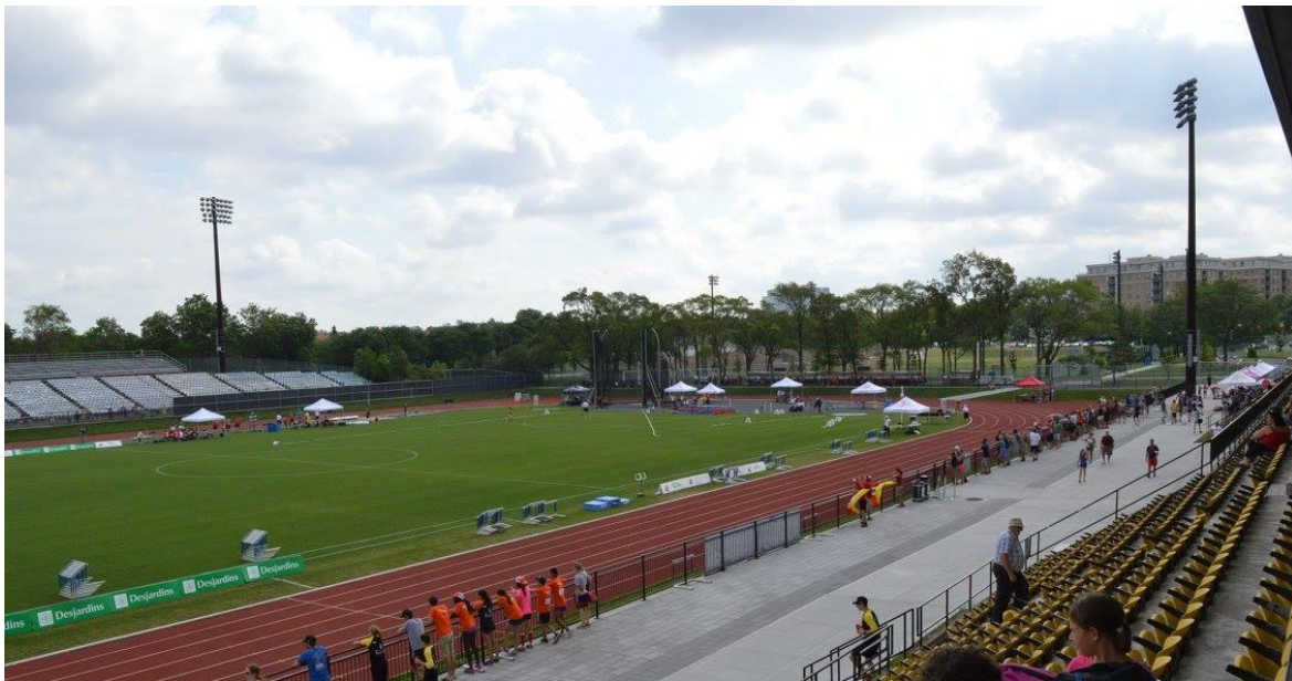
Piste extérieure depuis les rénovations en 2016
