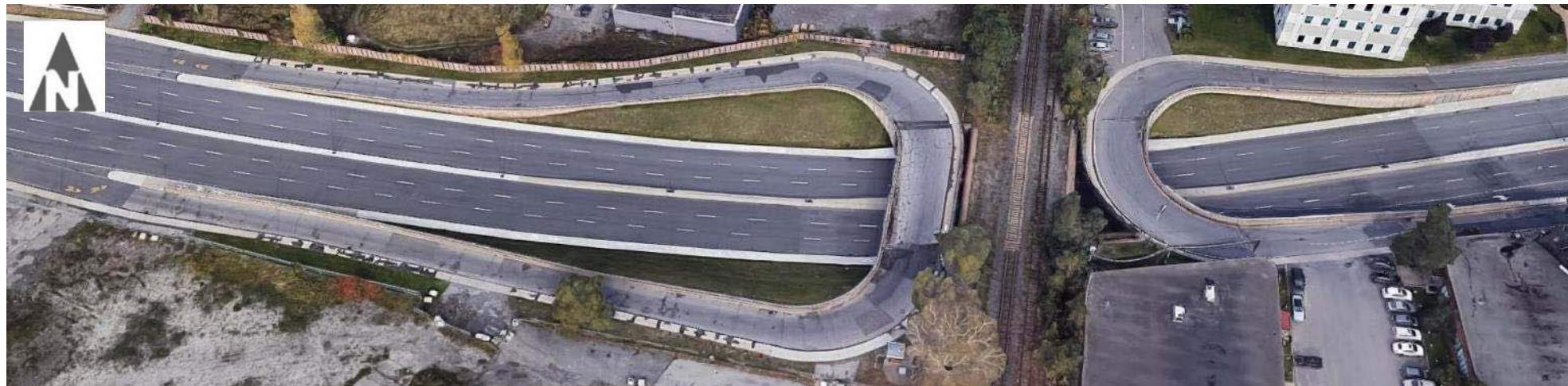
Structures au-dessus du passage inférieur Marcel-Laurin/CN; tournebrides Nord et Sud
