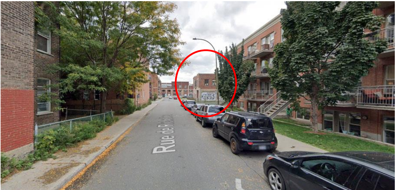
FIGURE 39. La rue de Richelieu vers l'ouest. L'immeuble de la Canadian Foundry Supplies & Equipment Limited (encerclé) se confond dans ce paysage majoritairement en brique. Source : STM.
