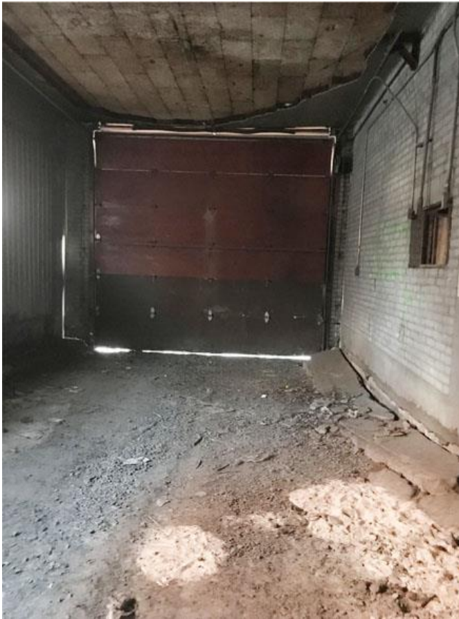
FIGURE 30. Intérieur du passage qui traverse toute la profondeur du bâtiment. La porte apparaissant sur la photographie est celle qui donne sur la rue de Richelieu. Source : STM.
