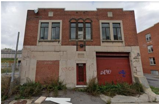
FIGURE 20 La façade principale au sud. La composition symétrique et le recours à de la pierre reconstituée en béton caractérise cette façade d'inspiration art déco. Source : Google Street View.
