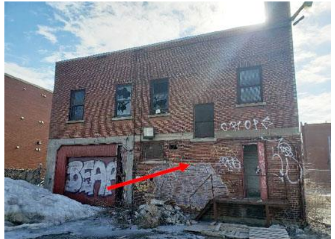
FIGURE 21 La façade arrière (nord) qui ne possède ni traitement architectural particulier, ni composantes ornementales. Les fenêtres sont de type à guillotine. Source : STM.
