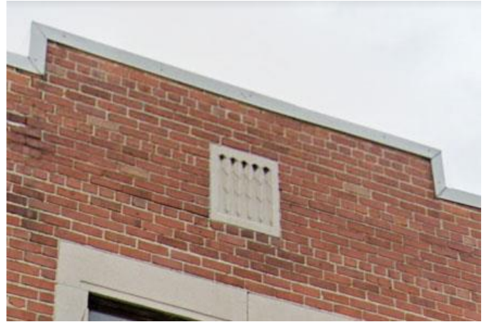
FIGURE 27 Parapet au sommet de la façade principale et son solin métallique. Une insertion en pierre reconstituée en béton moulé, contrastant avec la brique, est ornée de motifs d'inspiration art déco. Source : Google Street View.
