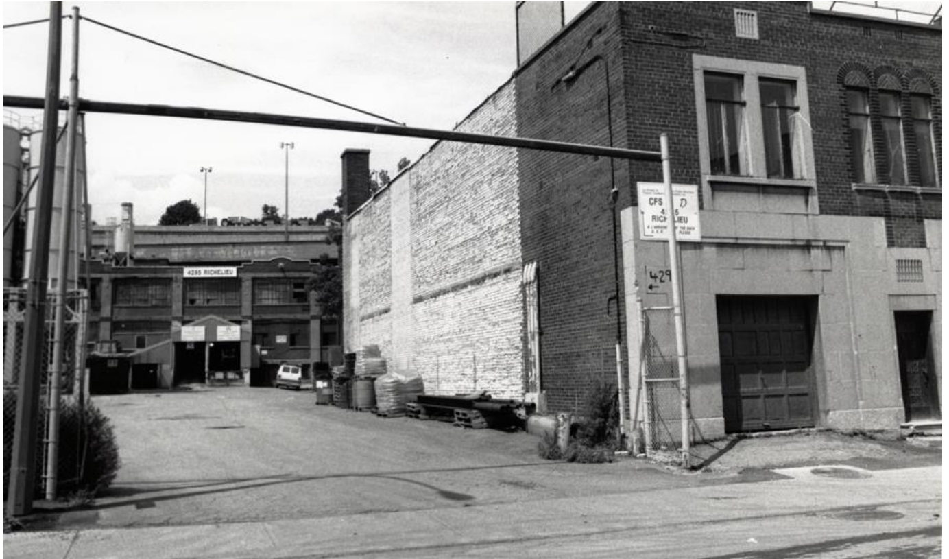
FIGURE 18 À droite, l'immeuble administratif à l'étude et, au fond, l'ancienne usine de la Canadian Foundry Supplies & Equipment Limited vers 1992. Source : Société historique de Saint-Henri, 198p29.
