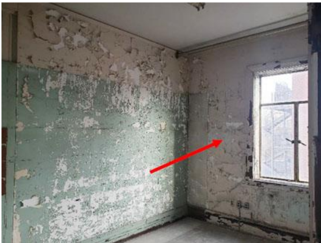
FIGURE 35 Autre espace de bureaux se situant à l'étage de l'immeuble à l'étude. Source : STM.
