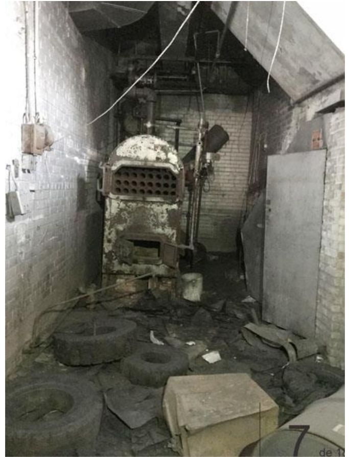
FIGURE 32. Intérieur du bâtiment au rez-de-chaussée, dans la partie qui servait autrefois de garage. Source : STM.
