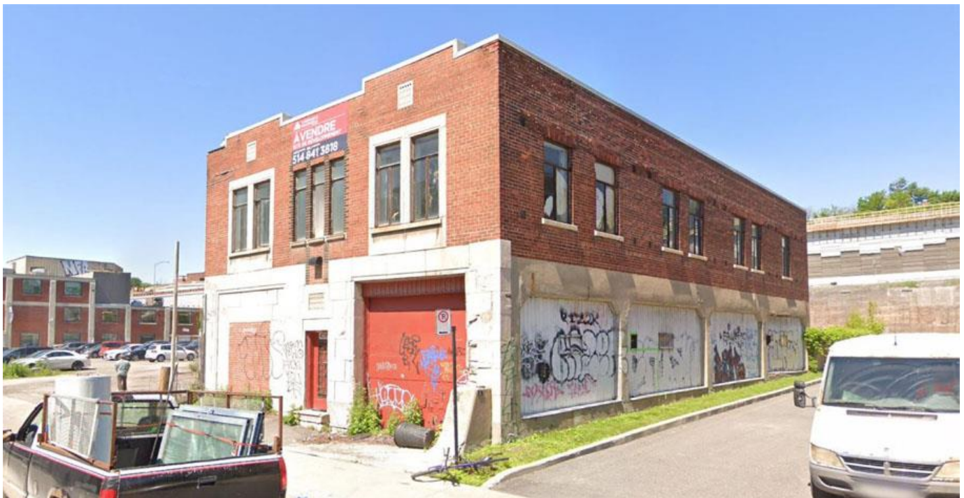
FIGURE 22 Sur la façade latérale est, le rez-de-chaussée était originellement ouvert entre les colonnes en béton. À l'étage, sept fenêtres à battants avec imposte sont disposées de façon régulière. La seule composante ornementale de cette façade est l'insertion de briques debout foncées à intervalle régulier entre les fenêtres. Source : STM.
