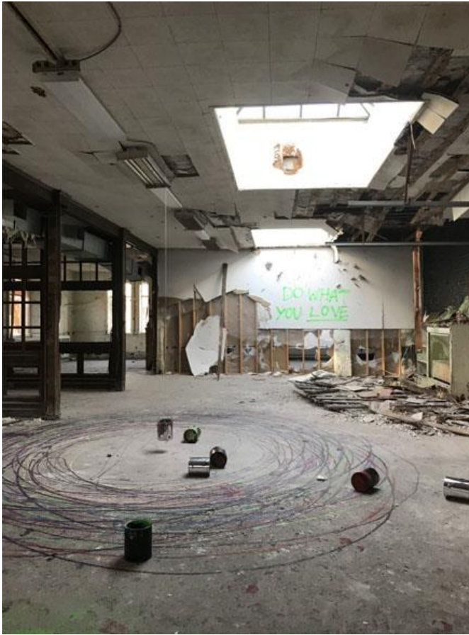
FIGURE 34 À l'étage, grande aire ouverte éclairée par des puits de lumière. À gauche, les vestiges des cloisons de bois vitrées qui séparaient des bureaux. Source : STM.
