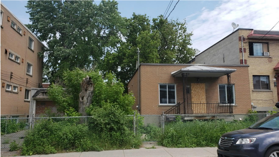
Façade avant du bâtiment :
