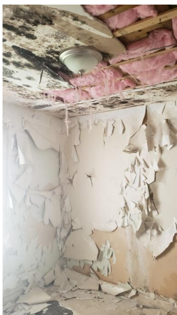
i. isolant et finition délabrés
