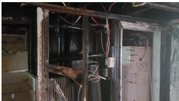
i. pourriture des compositions de mur
