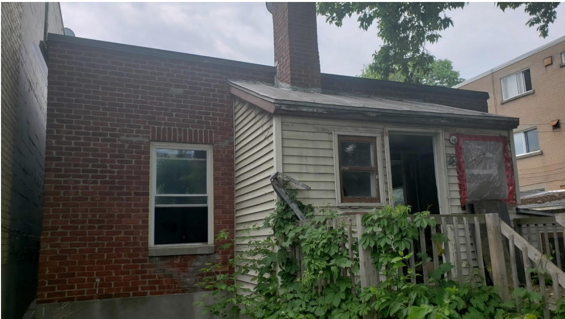
Façade arrière du bâtiment :
