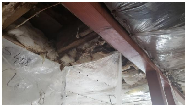
ii. pourriture des compositions de plancher
