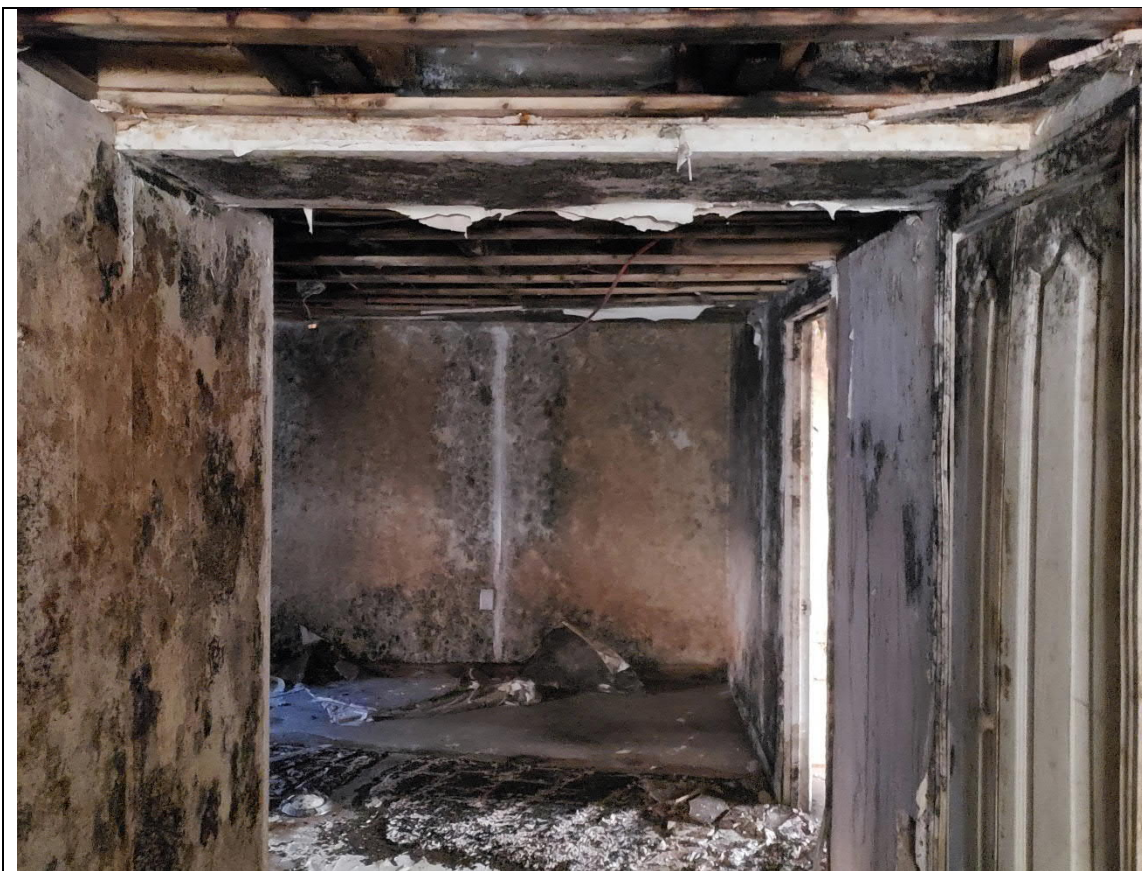
Photo 2 : État actuel du sous-sol
