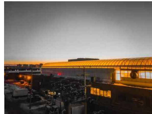
Vue du toit de la centrale agricole.
