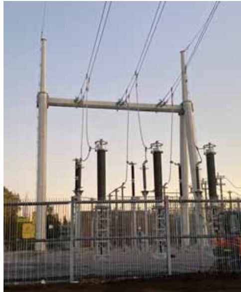
Figure 7 : Terminal aérosouterrain à 120 kV, poste Atwater
