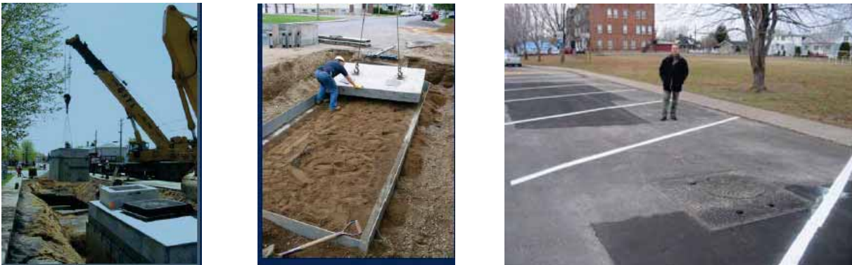
Figure 6 : Installation et fermeture des baies de jonctions
