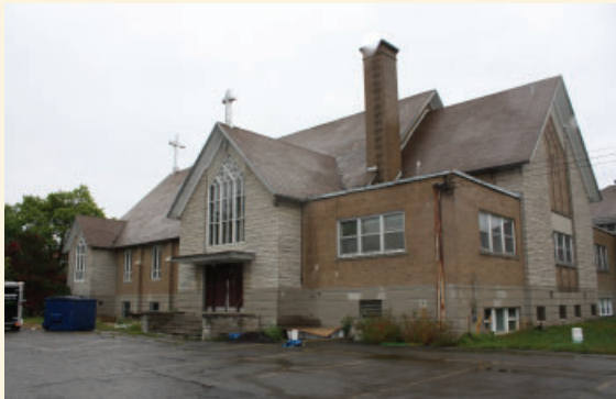
Façades latérale (nord) et arrière (abside) de l'église (source : Ville de Montréal, 2019)
