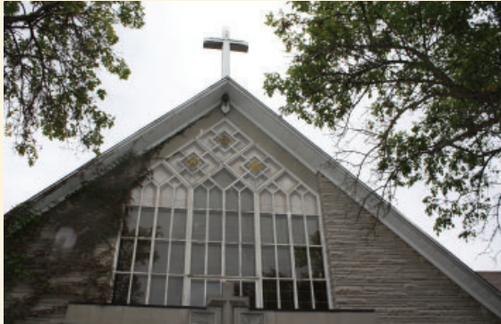
Détail de la façade principale de l'église sur l'avenue Durham (source : Ville de Montréal, 2019)
