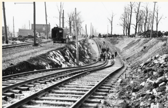
Travaux pour le tramway près de l'avenue Millen, 1945 (source : Archives de la STM)
