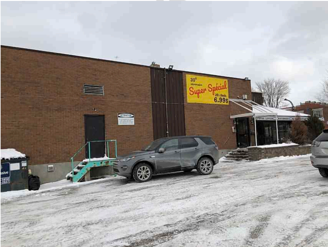
3 - Façade côté ouest
