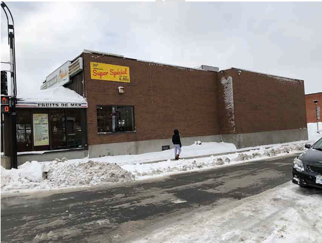
5 - Façade côté est (9 e avenue)
