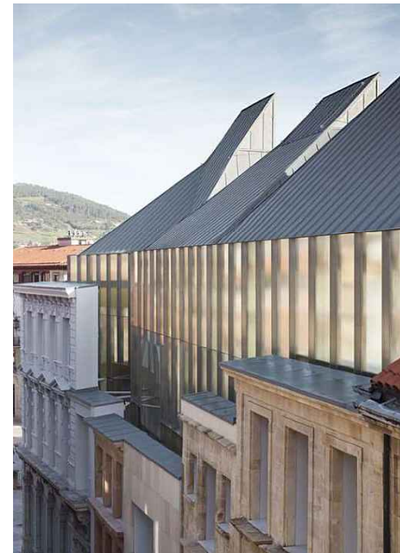
Exemple de façades hétérogènes et ajout
