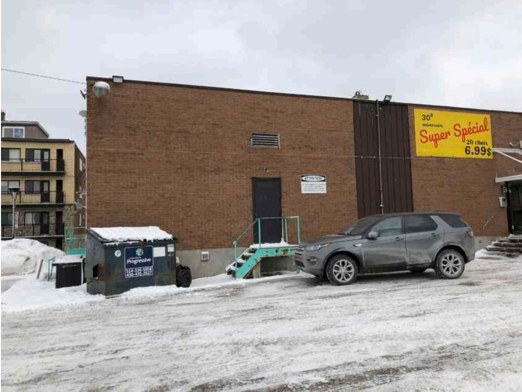
2 - Façade côté ouest
