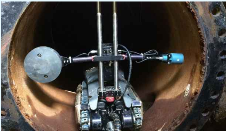
Exemple d'une technologie électromagnétique robotique pour l'auscultation d'une conduite en béton précontraint lorsqu'elle est hors service
