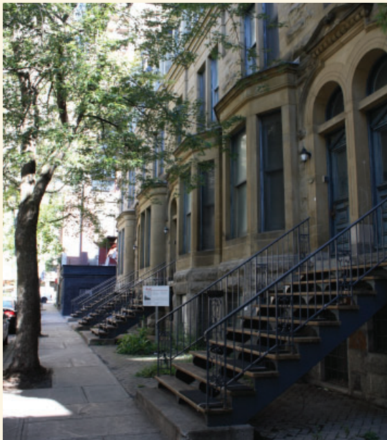
Vue depuis le trottoir devant l'ensemble (source : Ville de Montréal, septembre 2020)
