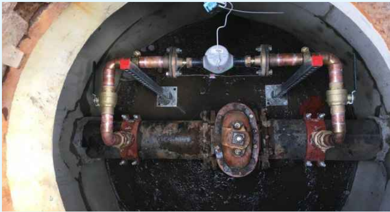
Exemple d'un compteur d'eau installé en dérivation sur une conduite d'aqueduc pour mesurer l'eau distribuée dans un micro secteur
