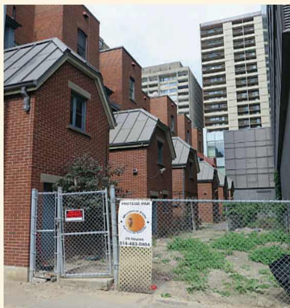
Annexes derrière chaque bâtiment (source : Ville de Montréal, septembre 2020)
