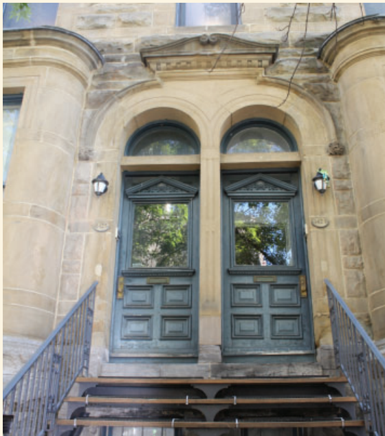
Entrées menant aux logements du 1423 et 1425, rue Pierce (source : Ville de Montréal, septembre 2020)
