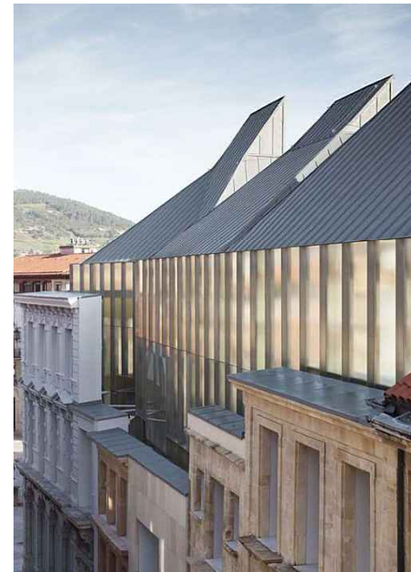
Exemple de façades hétérogènes et ajout
