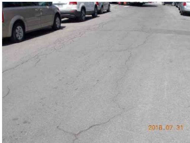
Fissuration longitudinale et transversale
