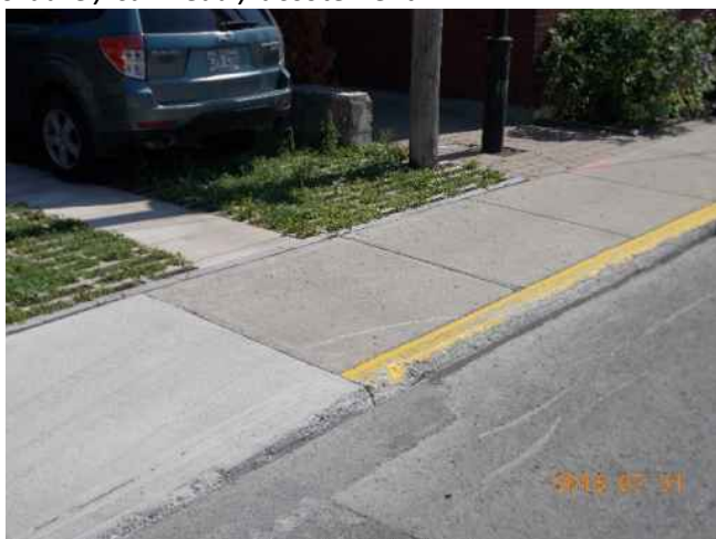
Érosion par abrasion mineure en bordure de trottoir
