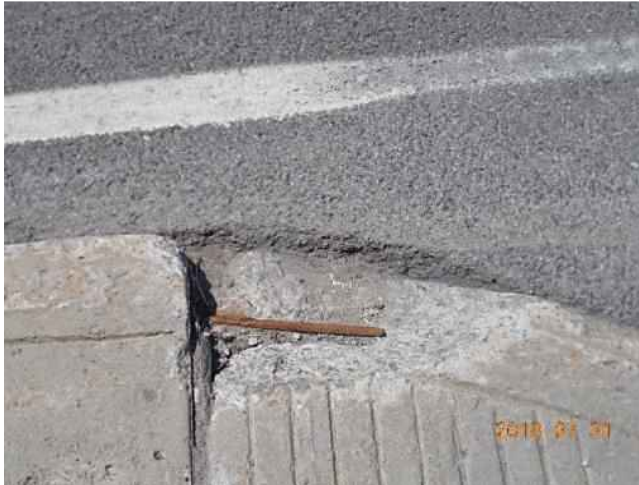
Éclatement au coin du trottoir en béton
