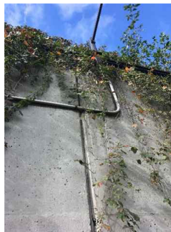
Conduits en surface des murs de soutènement
