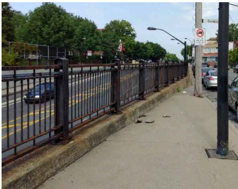
Figure 18 : Garde-corps fixé au haut des murs de soutènement
