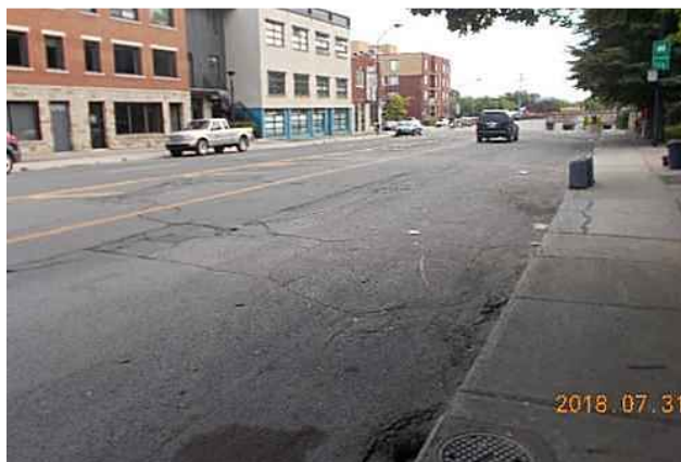
Fissuration transversale et longitudinale sur toute la longueur
