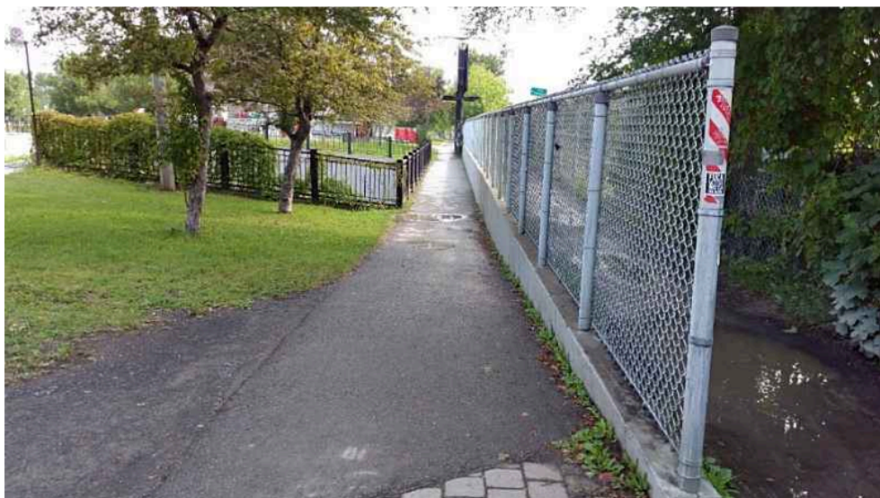
Figure 13 : Pont ferroviaire P.F. 81-5170B - Piste cyclable – Voie direction ouest abaissée et direction est surélevée
