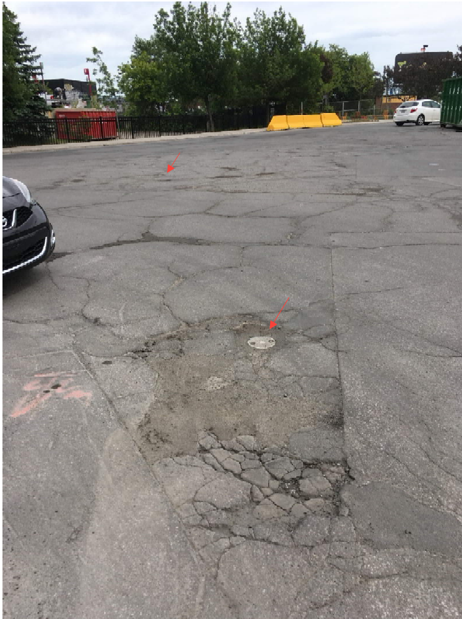
PHOTO 3 Emplacement du forage 17G058-003 et du carottage 17G058-C003.
