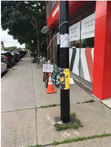
Coffret d'alimentation et de contrôle 0633_A5H-3a
