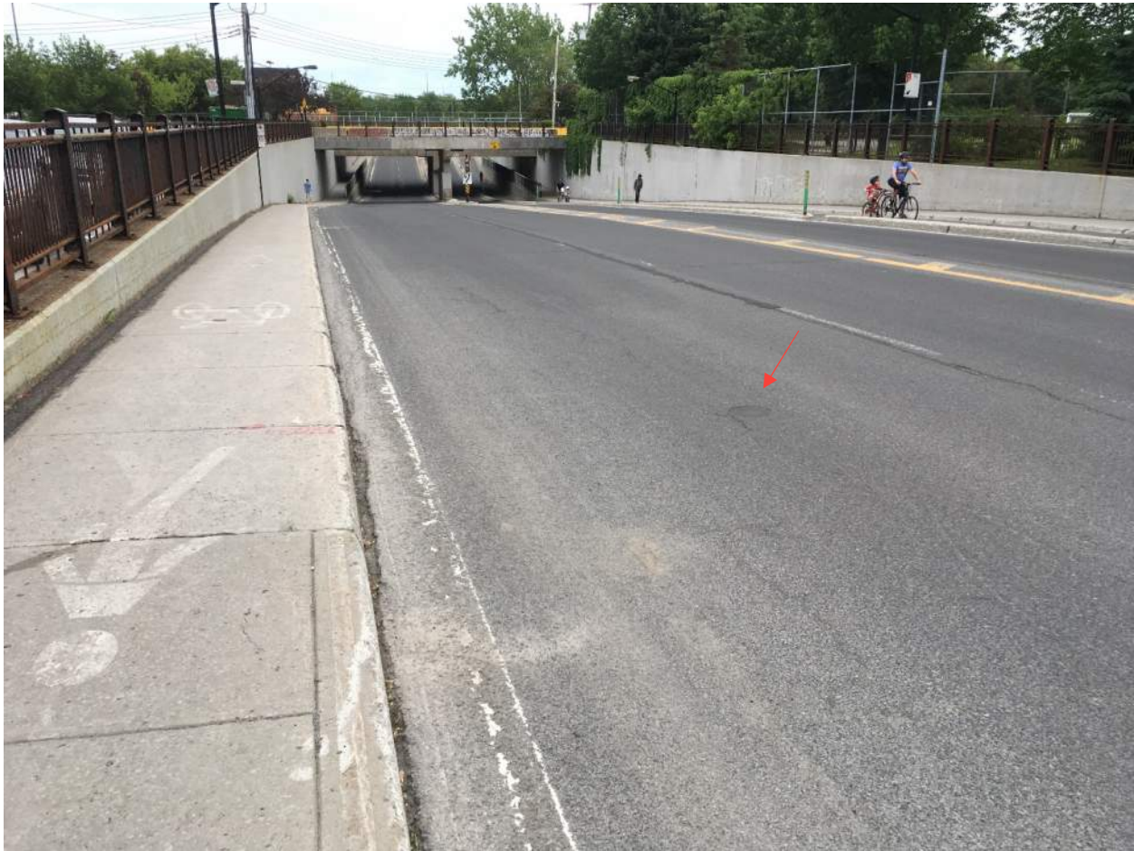
PHOTO 9 Emplacement du forage 17G058-009 (carotte de chaussée uniquement).
