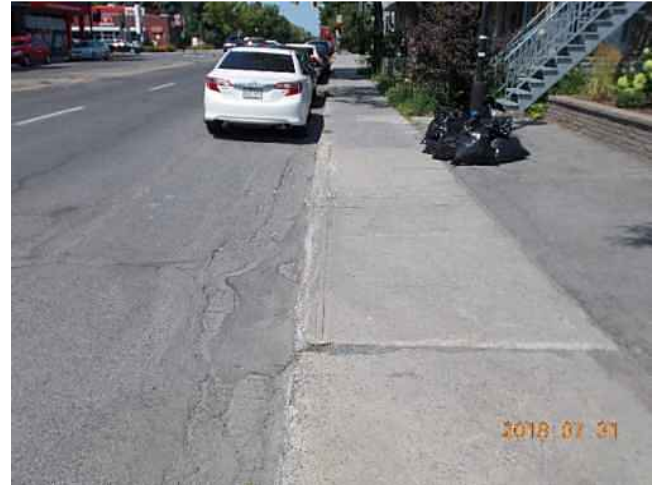
Traces d'érosion par abrasion longeant le trottoir
