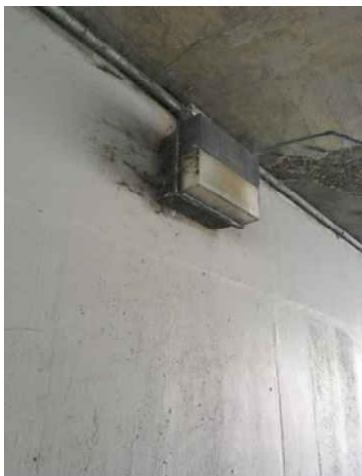
Luminaire mural sous le pont ferroviaire
