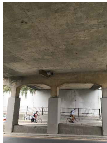
Luminaire de type « Cobra » sous le pont d'étagement routier
