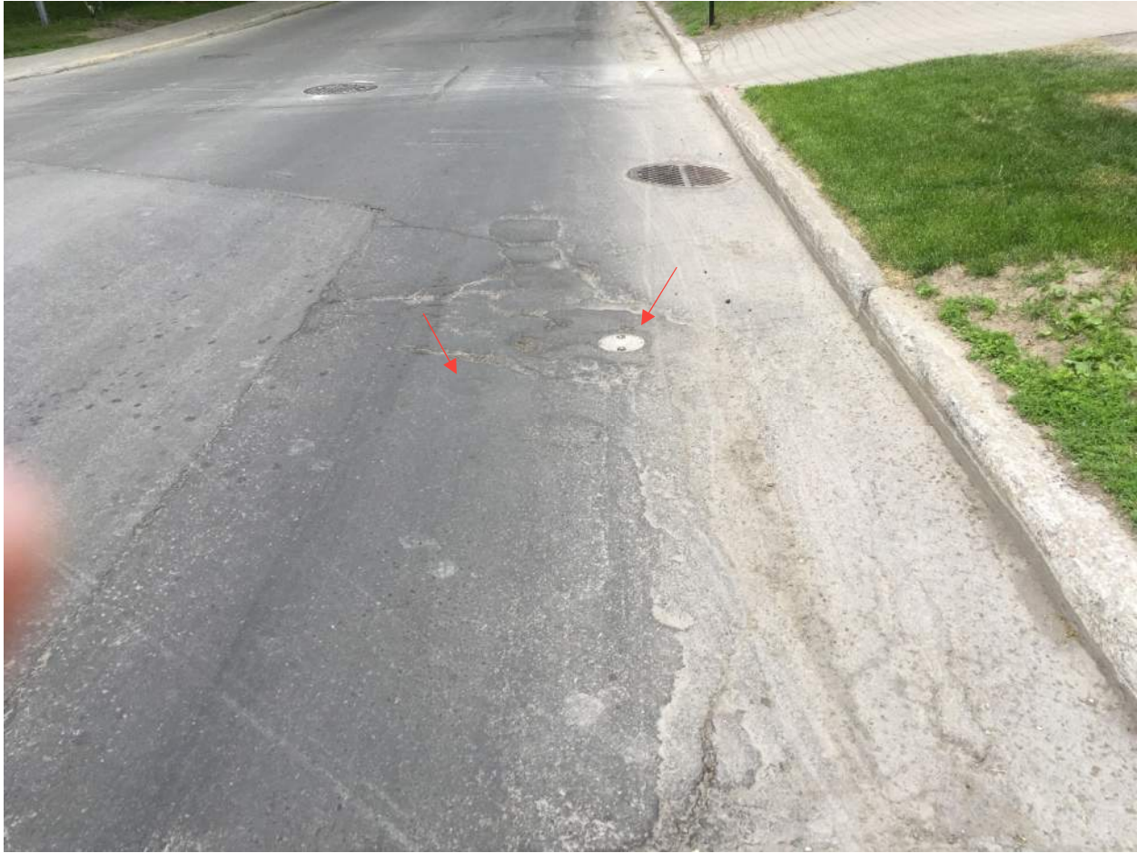
PHOTO 15 Emplacement du forage 17G058-015 et du carottage 17G058-C015.
