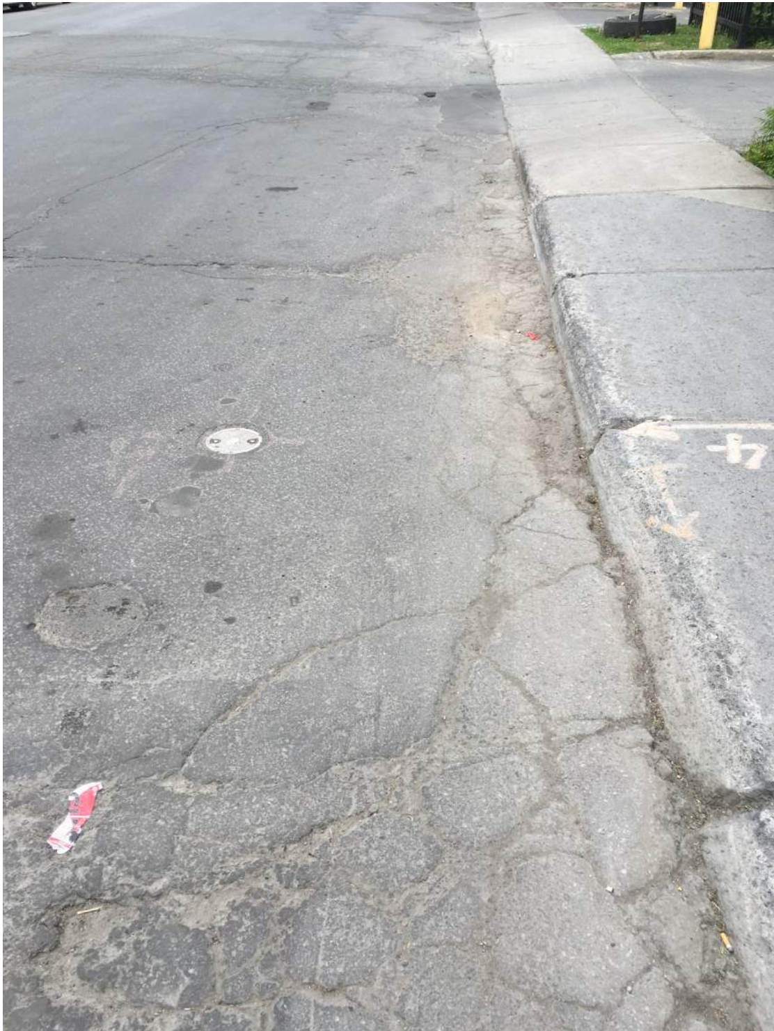
PHOTO 2 Emplacement du forage 17G058-002 et du carottage 17G058-C002.
