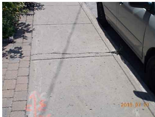
Fissure transversale et épaufre
