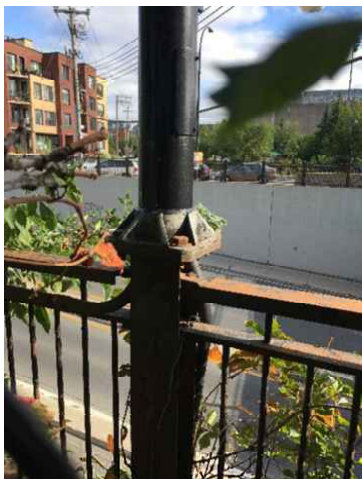
Fût sur poteau de garde-corps au-dessus des murs de soutènement
