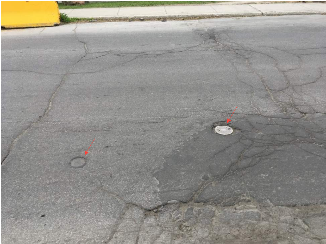
PHOTO 6 Emplacement du forage 17G058-006 et du carottage 17G058-C006.
