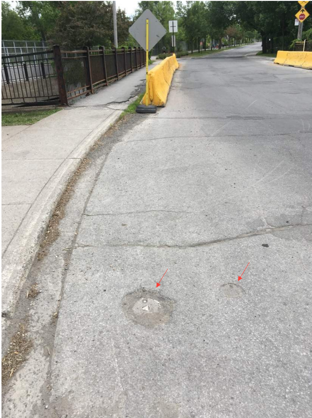
PHOTO 4 Emplacement du forage 17G058-004 et du carottage 17G058-C004.
