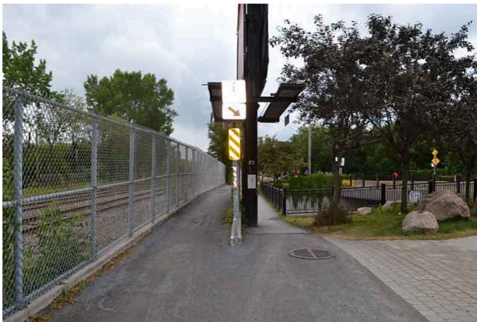
Figure 15 : Pont ferroviaire P.F. 81-5170B – Panneau publicitaire
