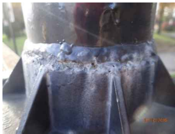
Soudure à la base d'un fût en mauvais état
