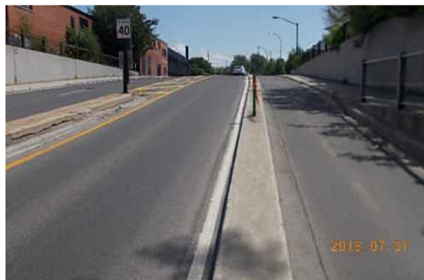
Ressuage au niveau des pistes de roues
