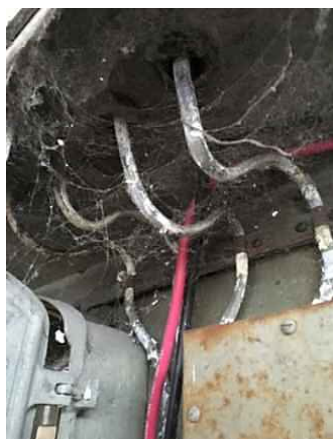
Conducteurs à remplacer à la sortie de la distribution encastrée
