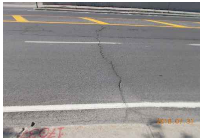
Fissuration transversale sur les deux voies direction nord
