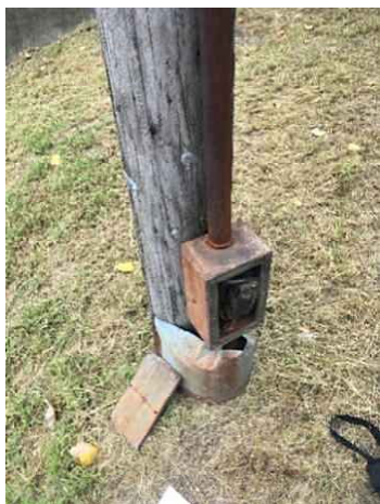
Coffret de branchement sur poteau de bois
