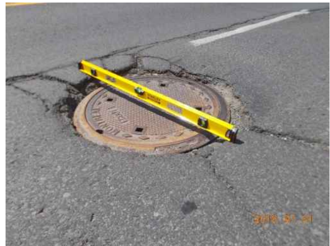
Affaissement de tête de regard
