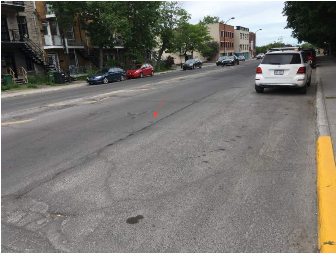
PHOTO 12 Emplacement du forage 17G058-012 (carotte de chaussée uniquement).
