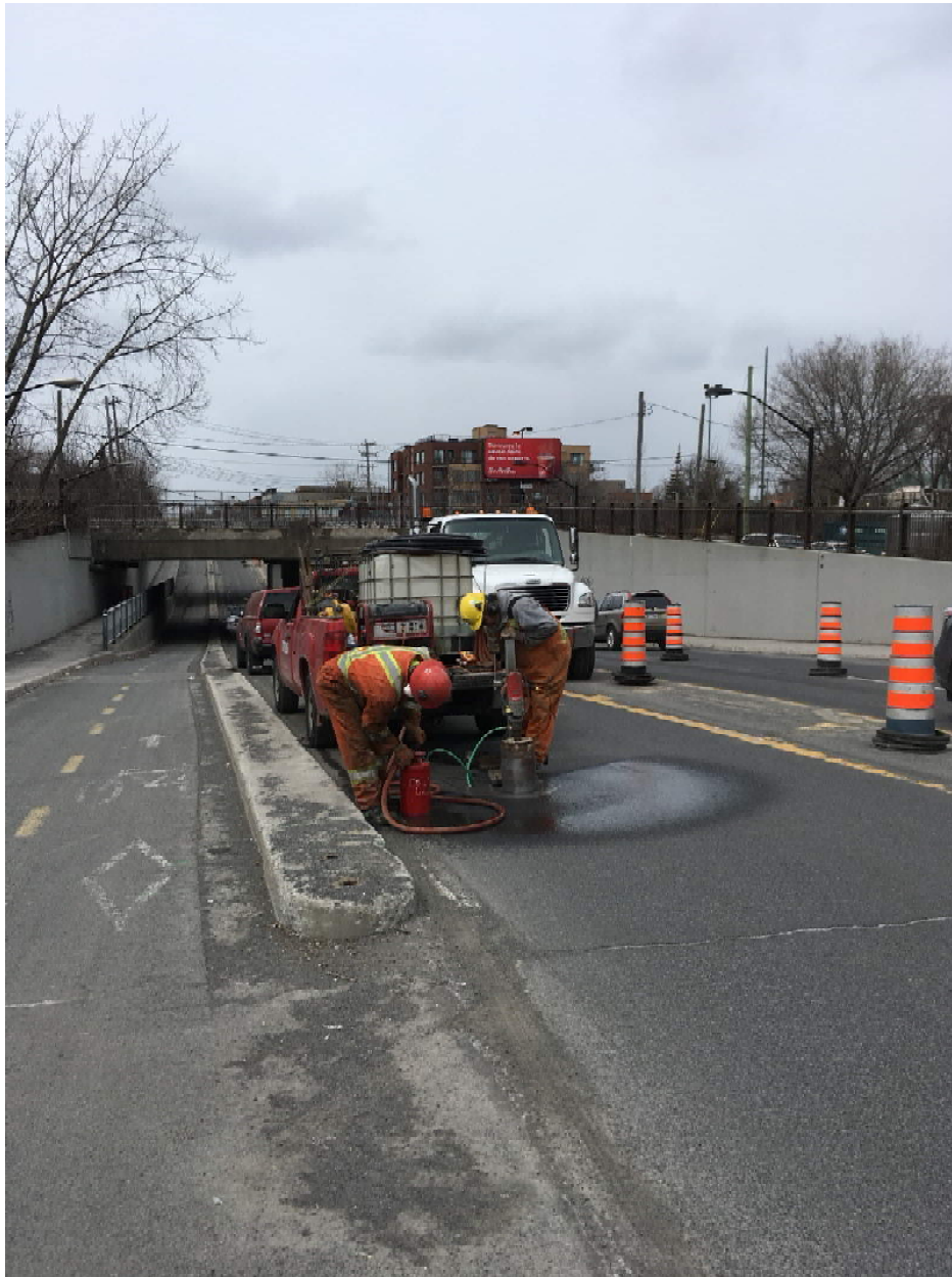
PHOTO 10 Emplacement du forage 17G058-010 (carotte de chaussée uniquement).
