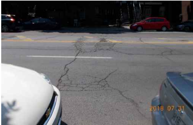
Fissuration longitudinale et transversale. Présence de carrelage
