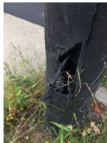
Fût en mauvais état
