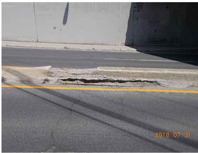
Éclatement du béton de l'îlot central
