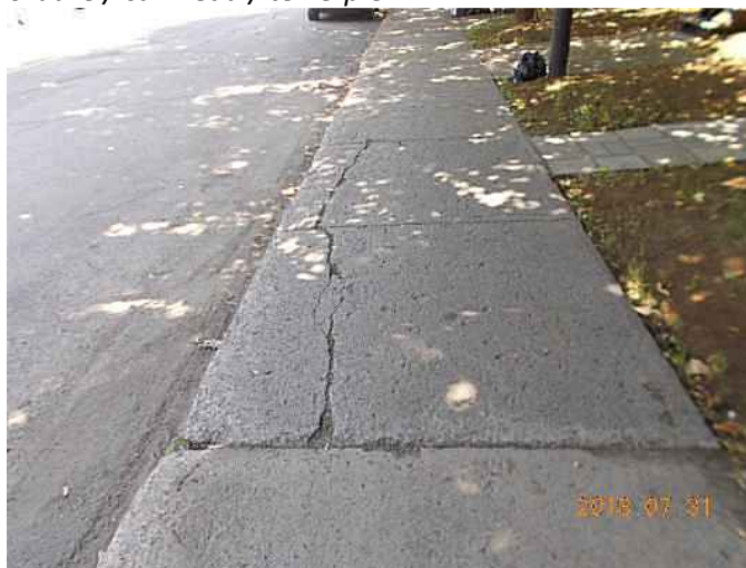
Fissure longitudinale sur une section du trottoir
