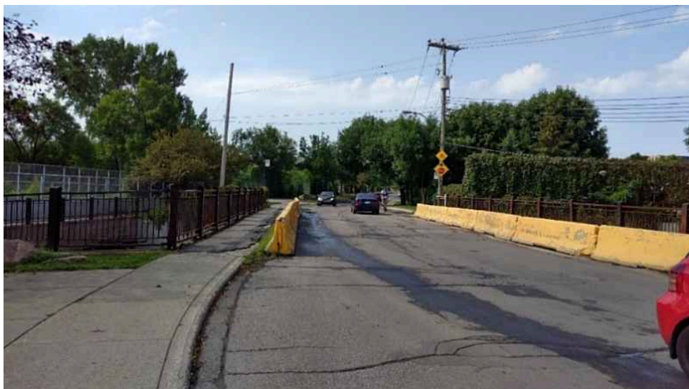
Figure 7 : Pont d'étagement routier P.E. 81-5169A – Tablier
