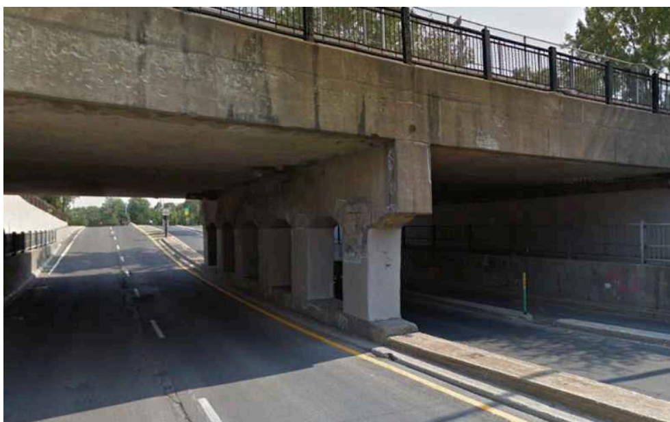
Figure 9 : Pont ferroviaire P.F. 81-5170B – Pile
