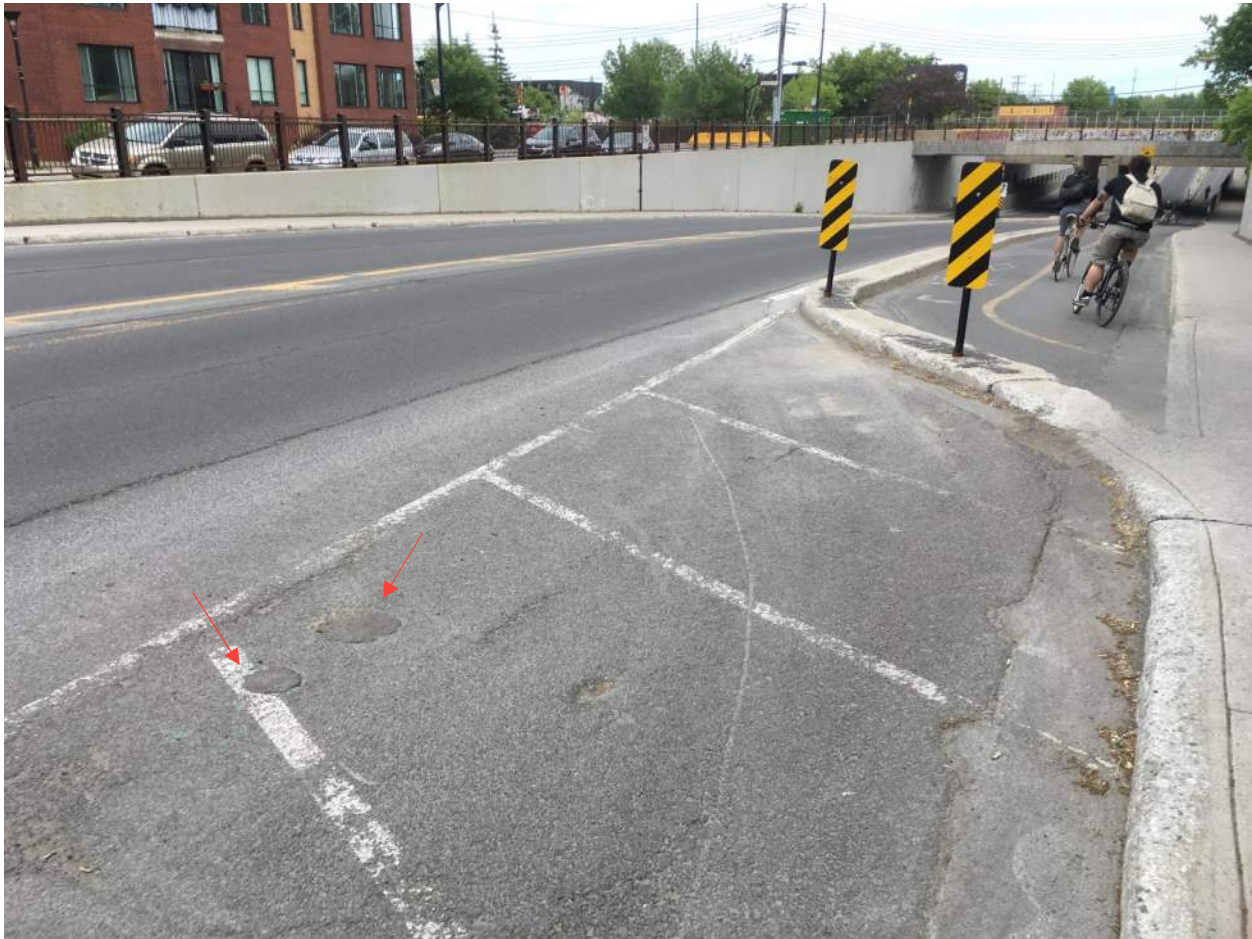
PHOTO 7 Emplacement du forage 17G058-007 et du carottage 17G058-C007.
