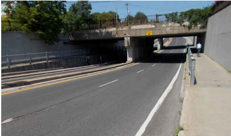
Pont ferroviaire P.F. 81-5170B – Vue en élévation
