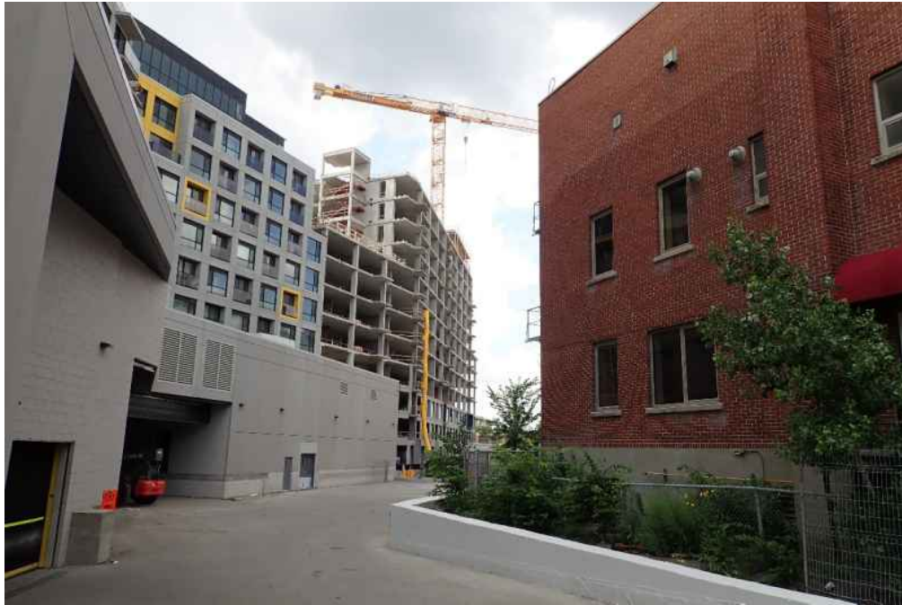
Photo 2: Vue de la façade gauche du site du projet
