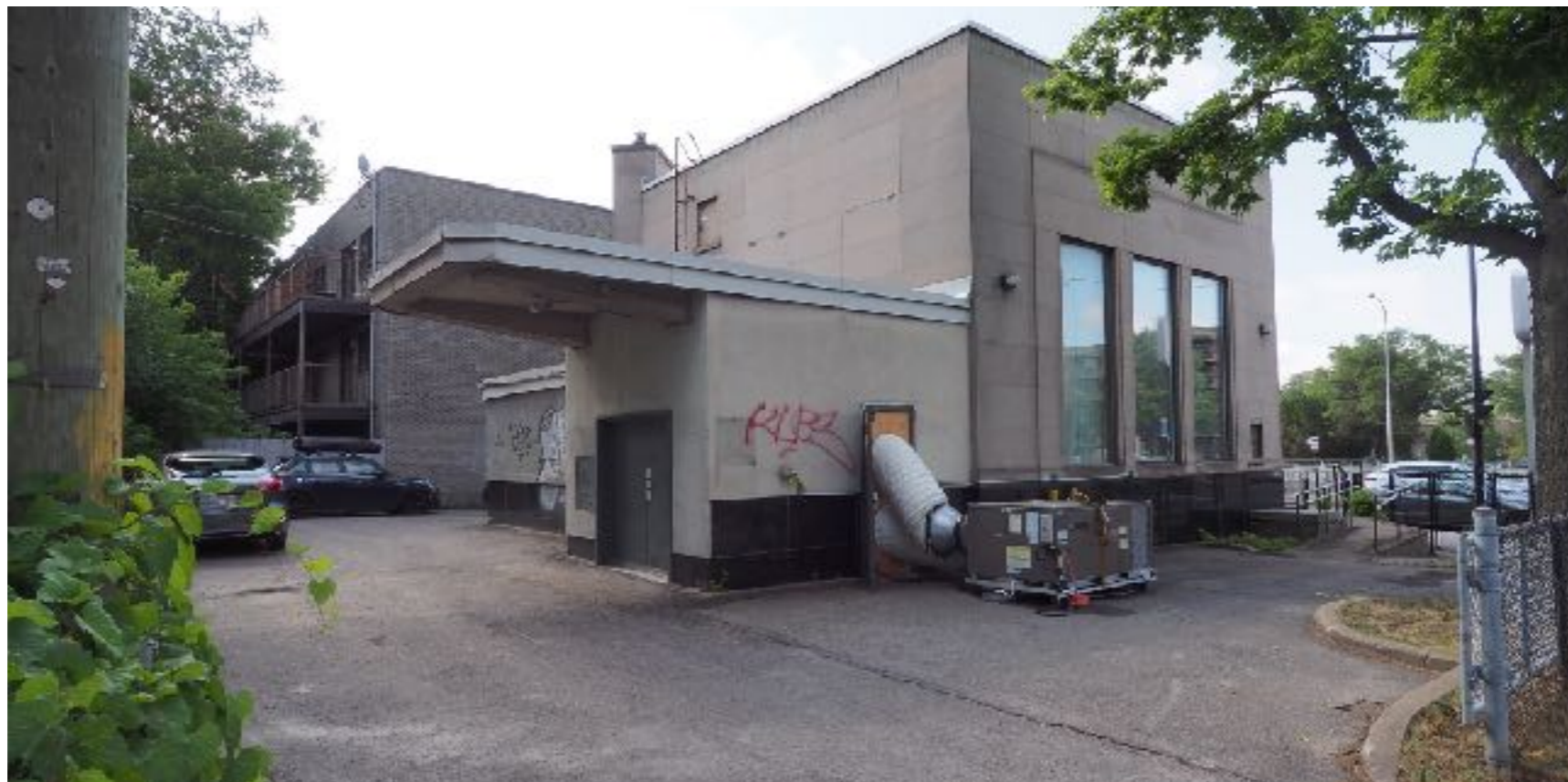
« Entrée » depuis le boulevard Décarie Espace de circulation à l'arrière du bâtiment et cour latérale nord Source : Gris Orange Consultant inc., 2019
