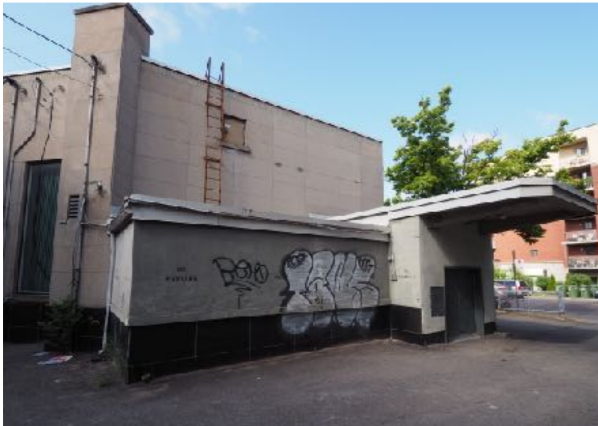
Détail de la frise du couronnement Détail du guichet de service à l'auto Source : Gris Orange Consultant inc., 2019
