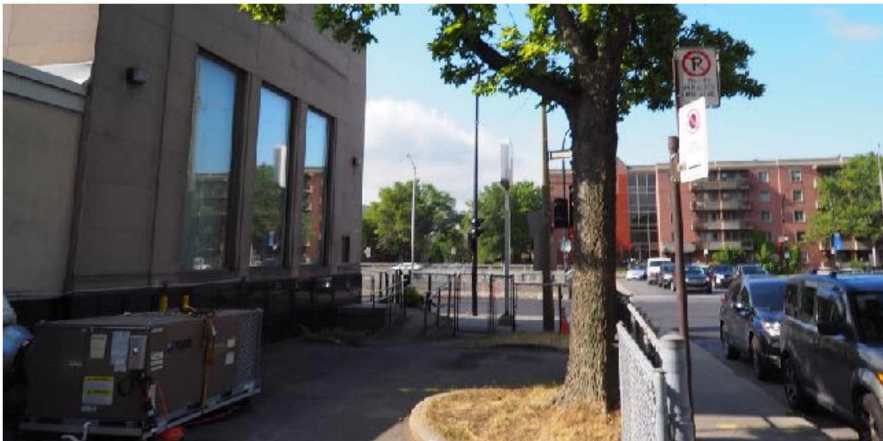
Alignement zéro, boulevard Décarie Espace de circulation à l'arrière du bâtiment et cour latérale nord Source : Gris Orange Consultant inc., 2019
