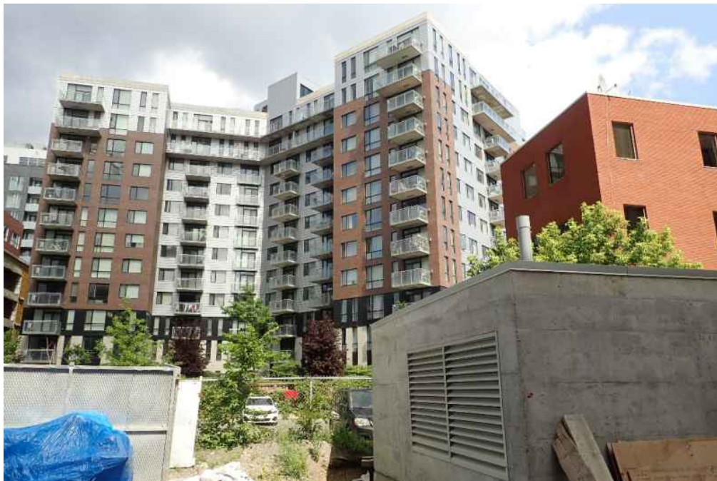
Photo 3: Vue de la façade arrière du site du projet
