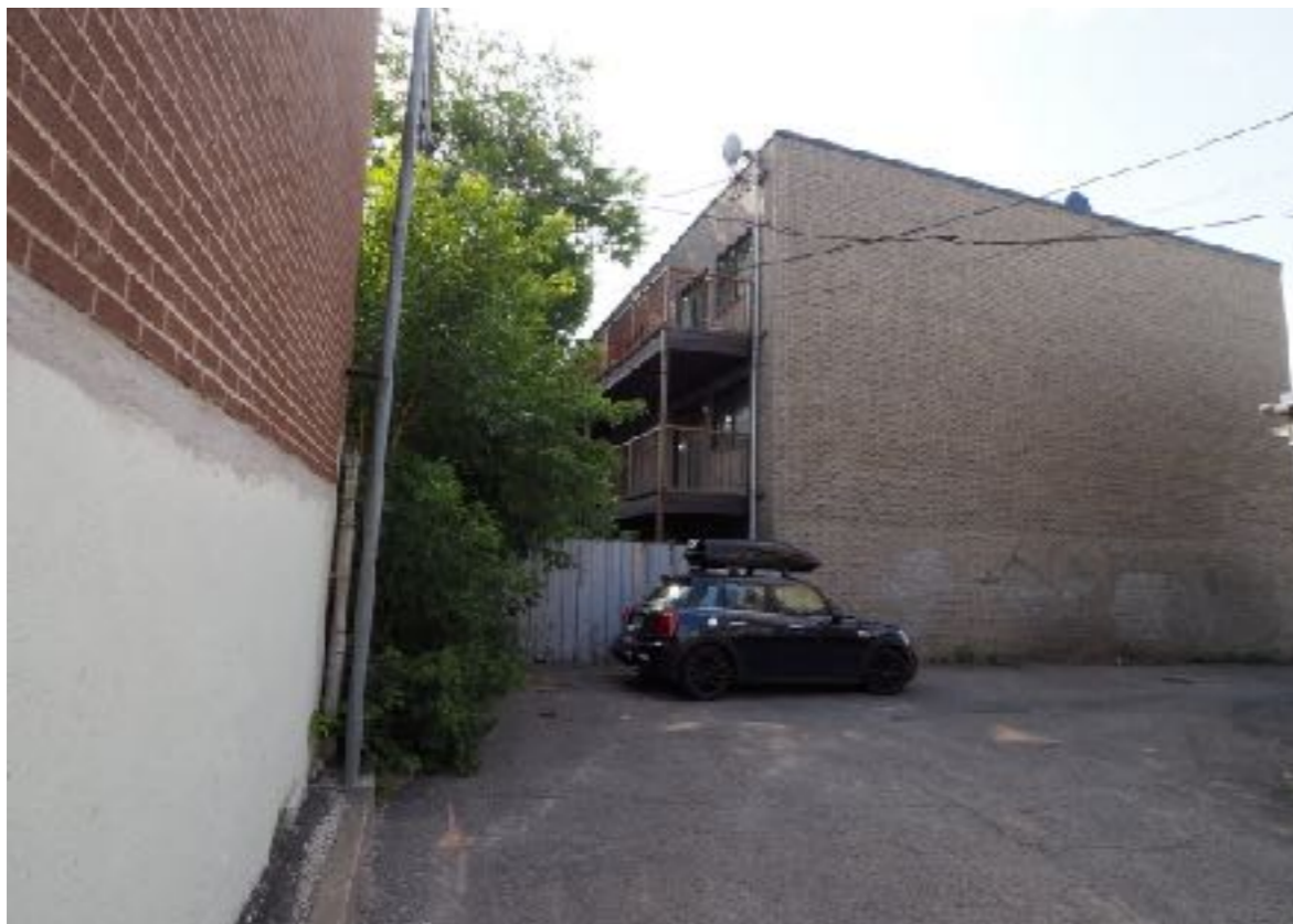
Bâtiment voisin 5665-5685, boulevard Décarie Façade latérale aveugle du 5665-5685, boulevard Décarie Source : Gris Orange Consultant inc., 2019
