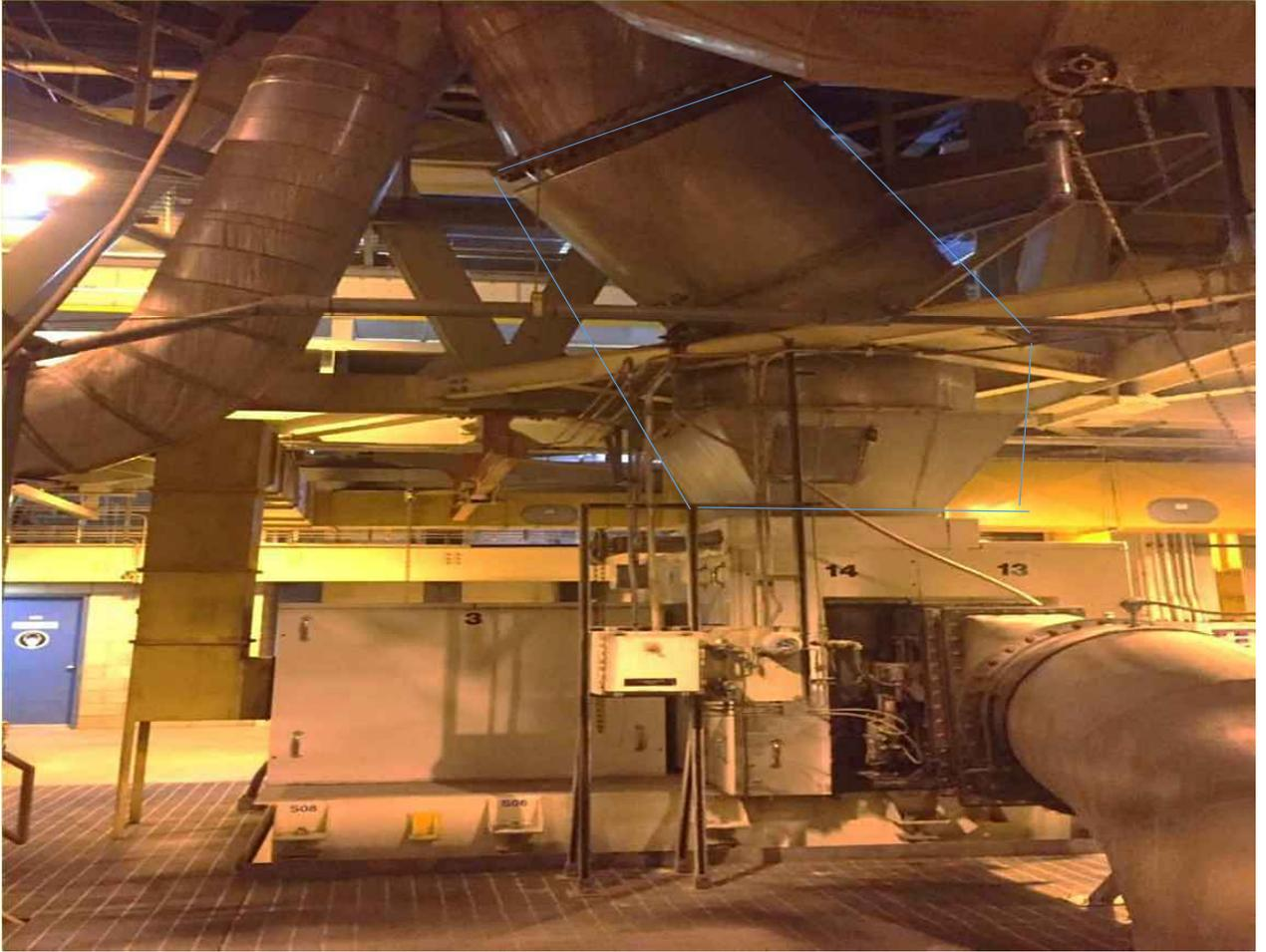
Figure 2: Photographie du silencieux installé sur la cheminée de l'incinérateur No 2
