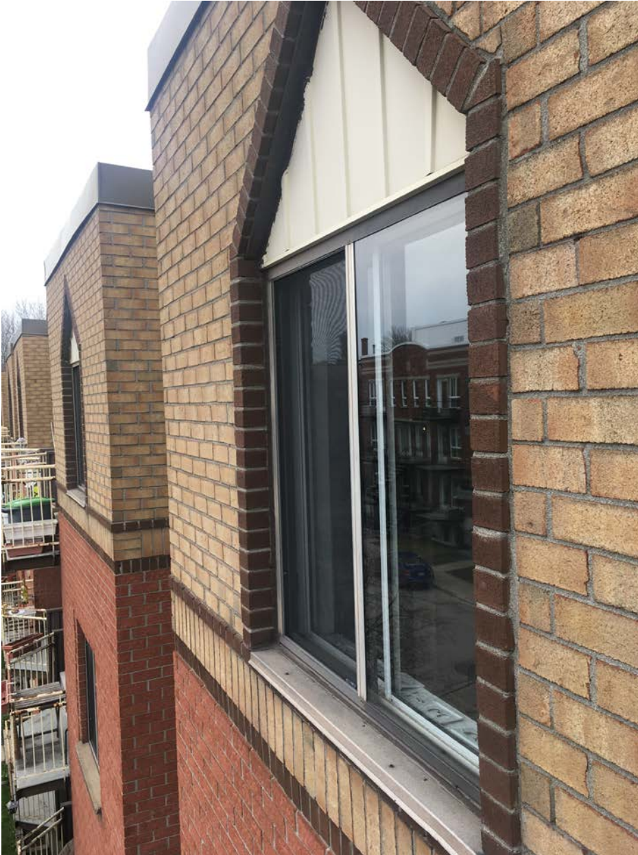
Photo a. appareil de maçonnerie typique autour des fenêtres coulissantes au 3e étage
