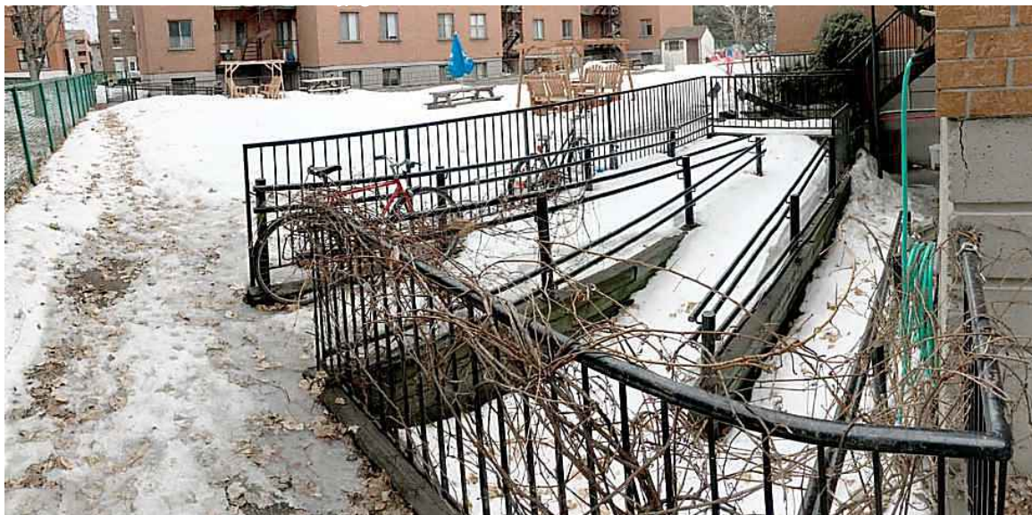
Figure 4 : Rampe extérieure pour personne à mobilité réduite
