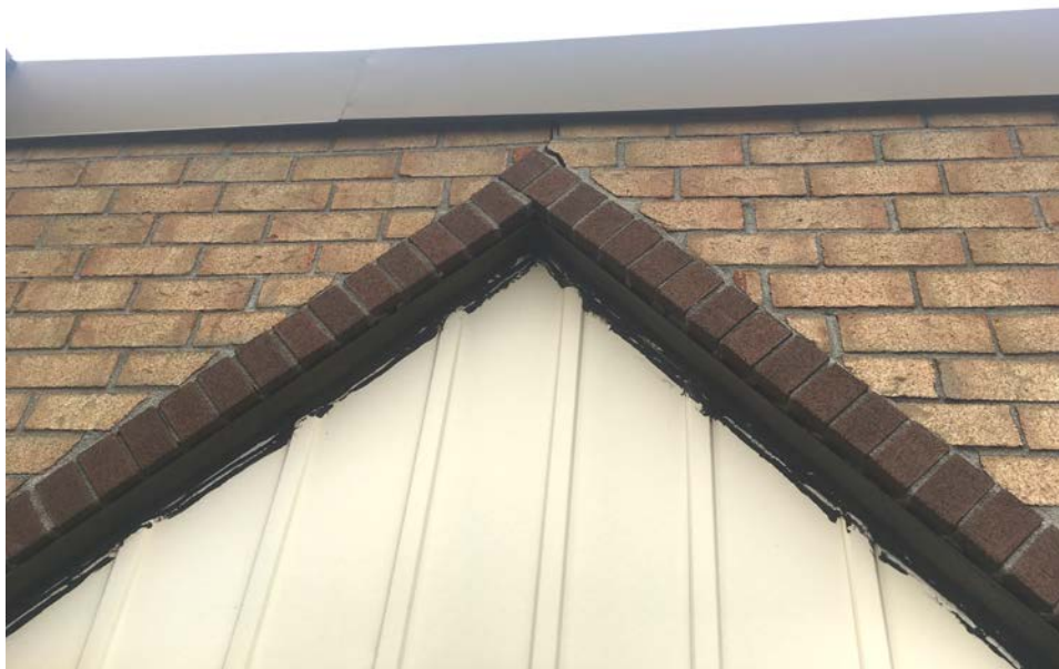
Photo j. tête de porte patio typique au 3e étage
