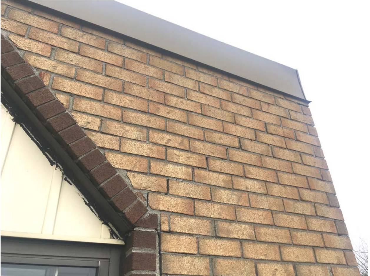
Photo i. fissure diagonale et désolidarisation au coin supérieur droit de la façade – 3e étage
