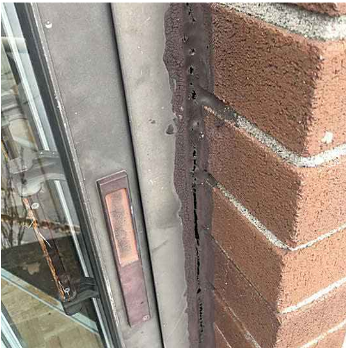
Photo e. agrandi de la vétusté et défaillance du joint de scellant – jambage
