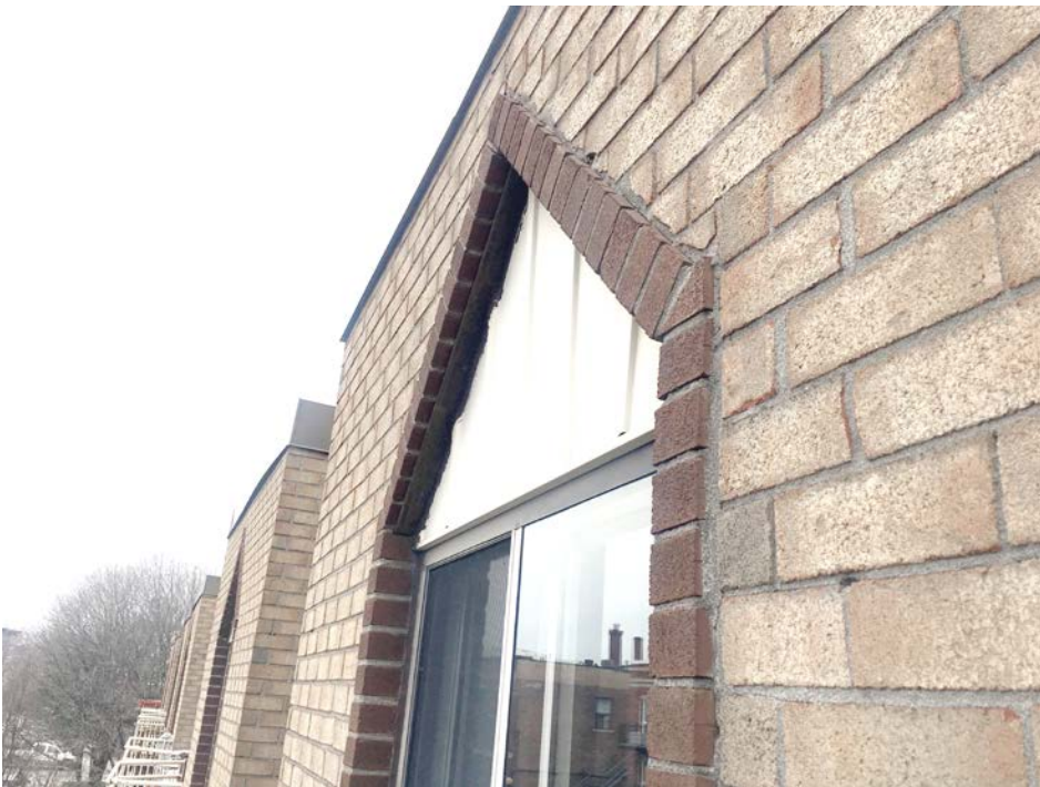
Photo c. vue rapprochée de la tête de fenêtre typique des coulissantes au 3e étage
