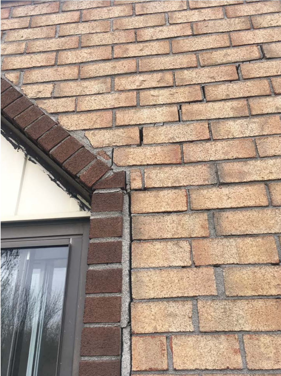
Photo h. fissure diagonale et désolidarisation à la jonction du jambage de la porte patio et de la maçonnerie – 3e étage
