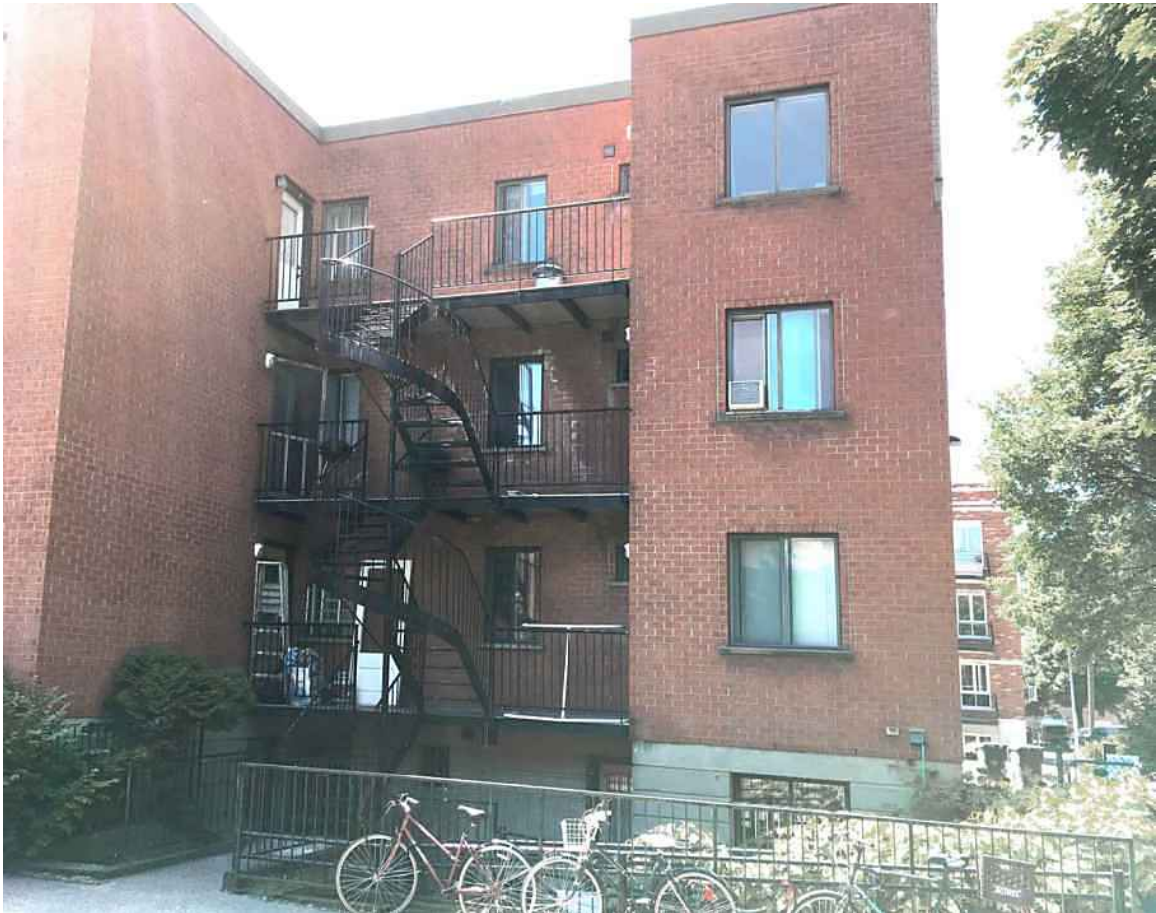
Figure 11 : Escalier d'issue arrière
