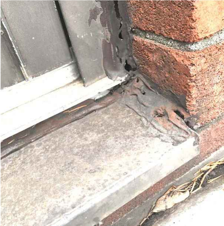
Photo f. agrandi de la vétusté et défaillance du joint de scellant – jonction seuil/jambage
