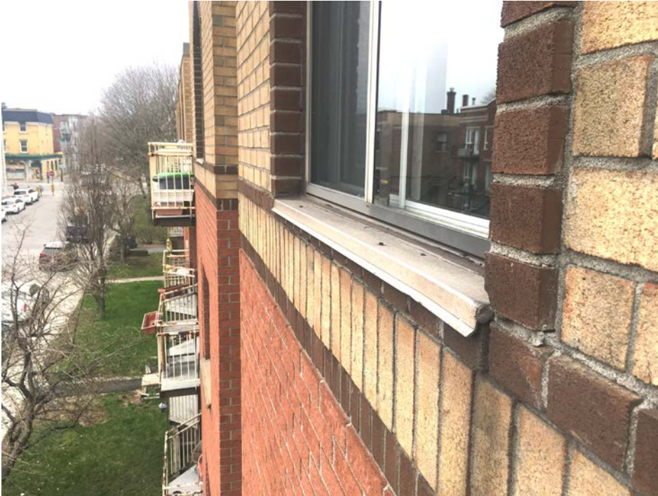
Photo b. vue rapprochée de l'allège de fenêtre typique des coulissantes au 3e étage
