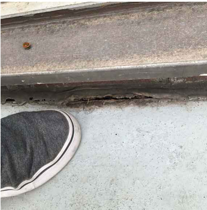
Photo g. conséquence de la défaillance d'évacuation d'eau : la putréfaction du pontage de fibre de verre des balcons
