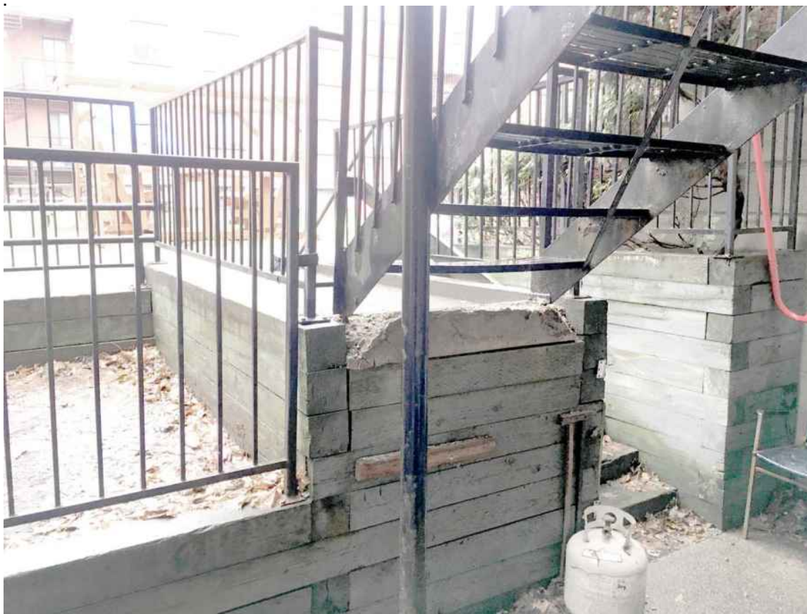
Figure 6 : Base d'assise en béton des escaliers d'issue
