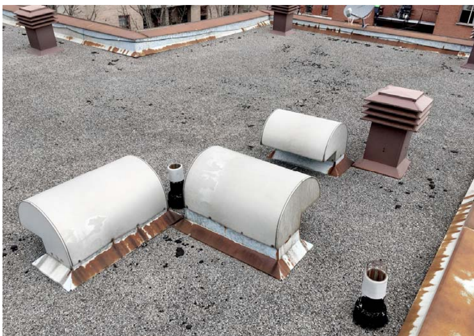
Figure 10 : Sorties d'air au toit
