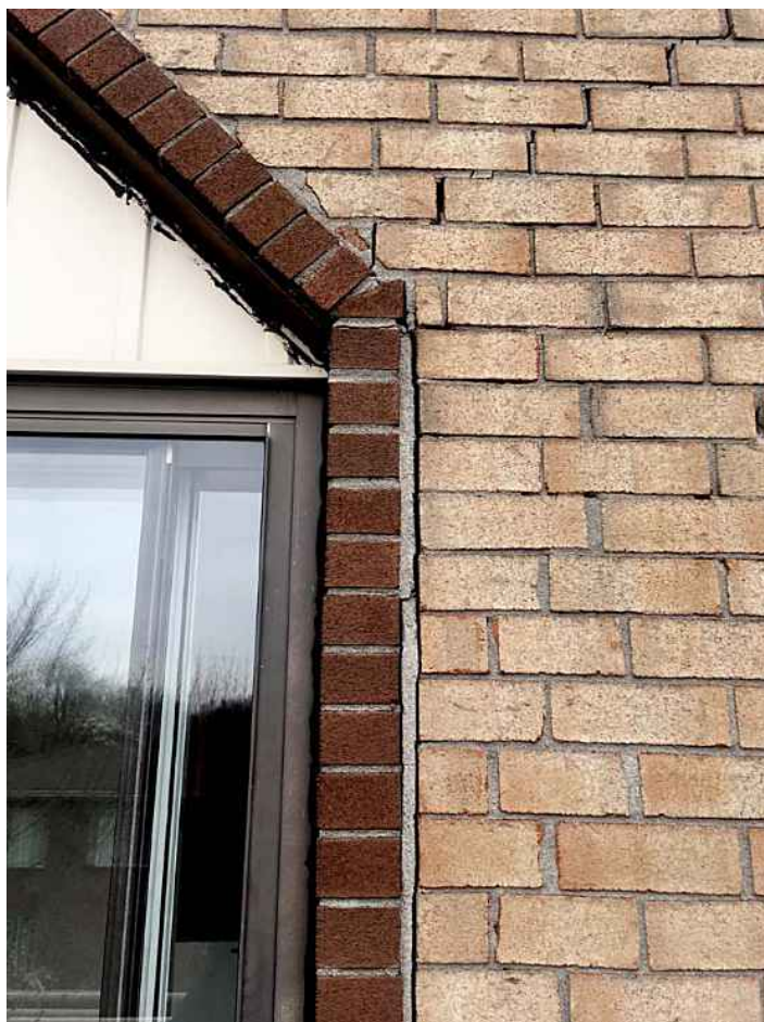
Figure 7 : Désolidarisation, fissuration du parement de maçonnerie –logement 545-8
