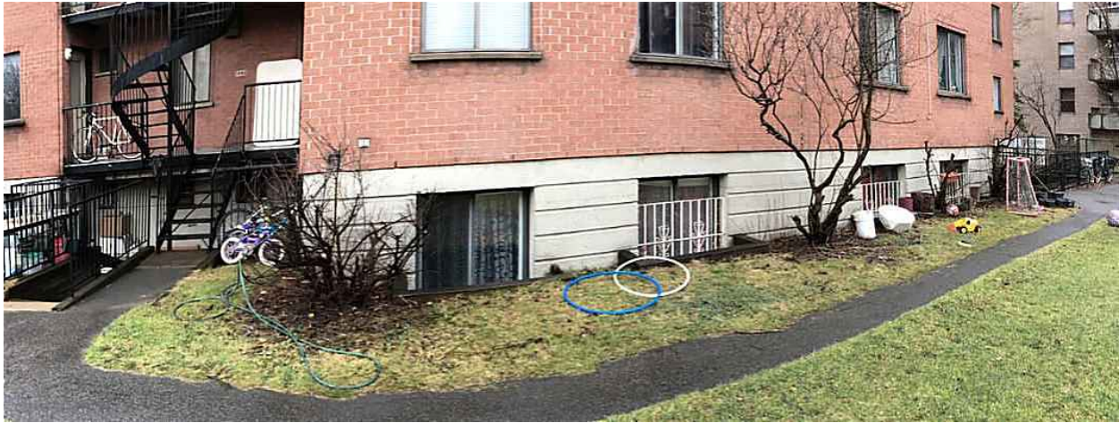
Figure 12 :Panoramique des fenêtres grillagées – façade cour
