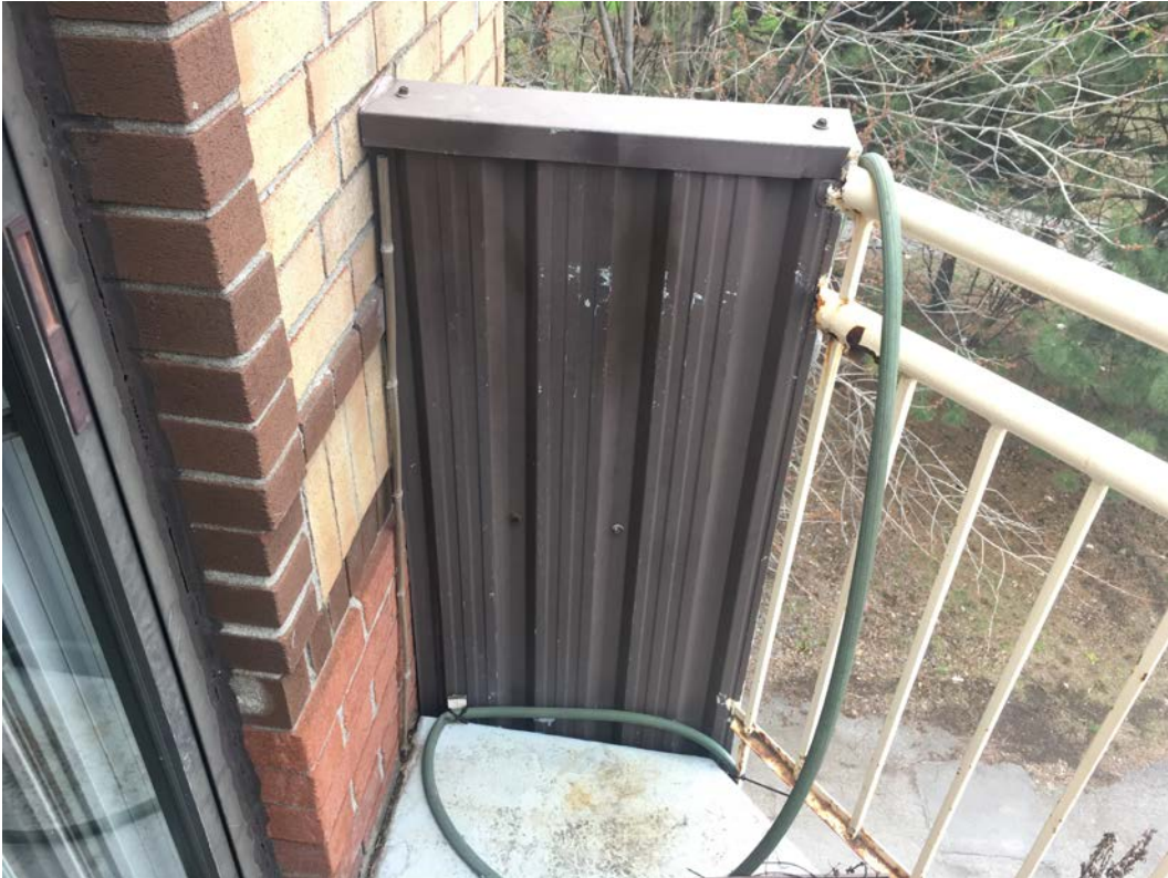
Photo d. appareil de maçonnerie typique au jambage des portes coulissantes du 3e étage
