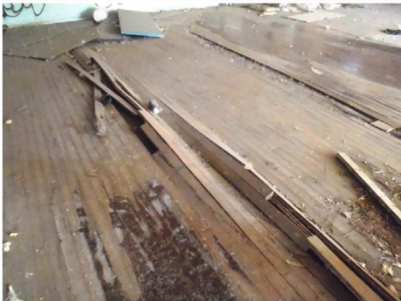
Photo 77 : Soulèvement des lattes du plancher de l'étage sous l'effet de l'eau qui va dessus
