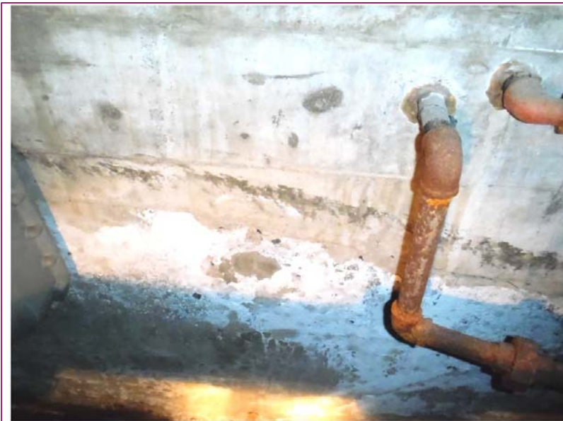
Photo 21 : Effritement du béton de la fondation Ouest dû à la présence d'efflorescences
