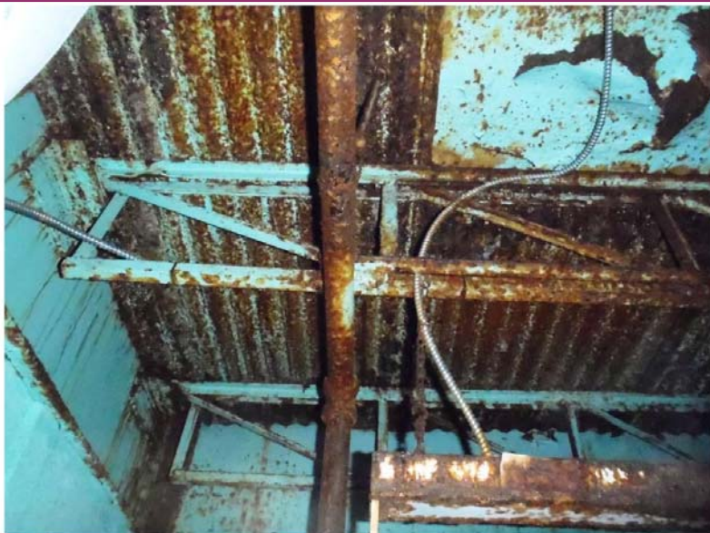
Photo 30 : Charpente de plancher du rez-de-chaussée en acier très dégradée secteur Sud-Est du sous-sol
