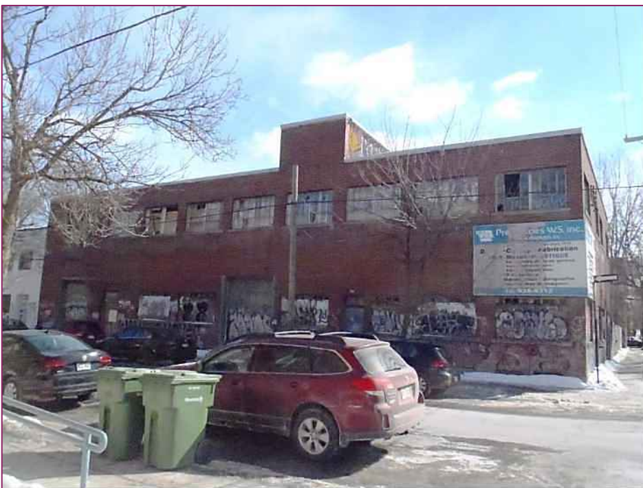
Photo 1 : Façade Nord du bâtiment inspecté longeant la rue Augustin-Cantin
