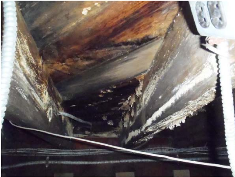
Photo 35 : Champignons et moisissures à l'intrados de la charpente de bois du plancher du rez-de-chaussée
