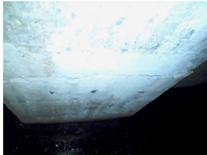
Photo 9 : Déplacement vers l'intérieur de la partie basse du pilastre sous la fissure par rapport au haut
