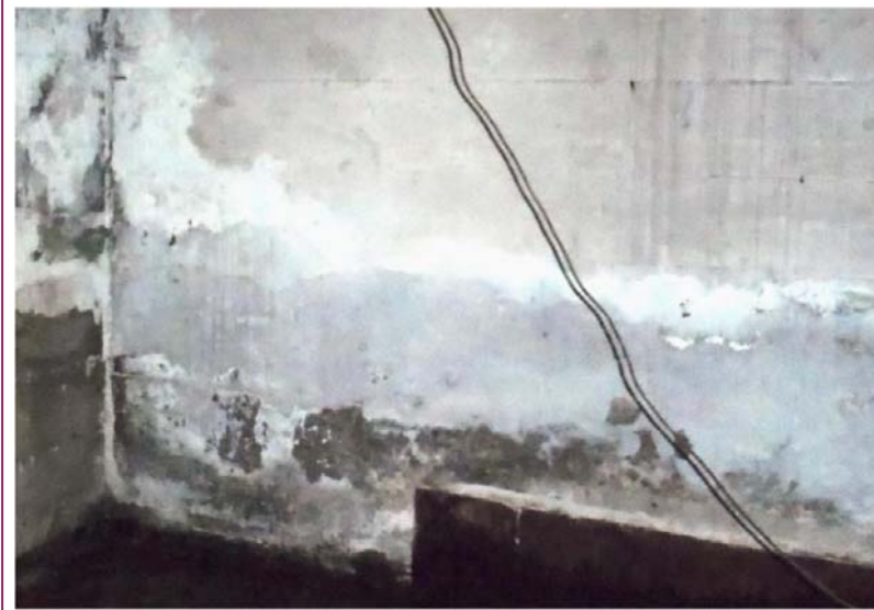
Photo 22 : Effritement du béton de la fondation Nord dû à la présence d'efflorescences
