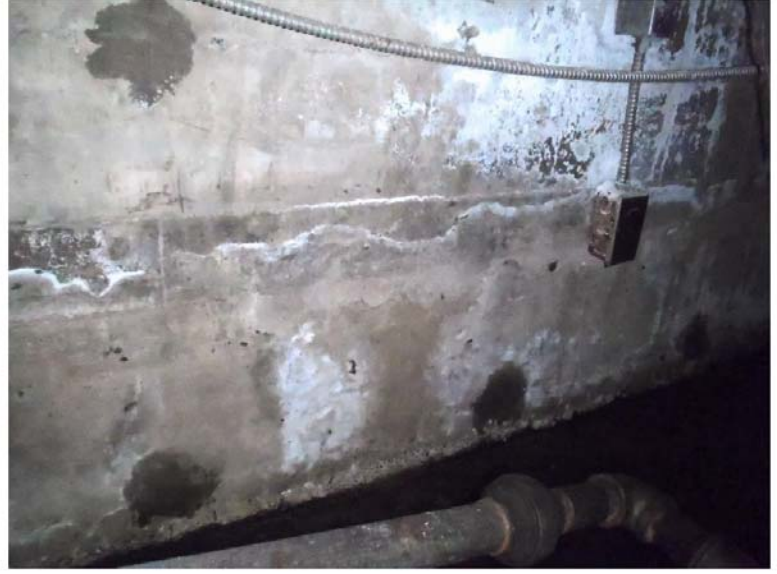
Photo 6 : Fissure au mur de fondation Ouest qui se propage presque horizontalement en direction Nord
