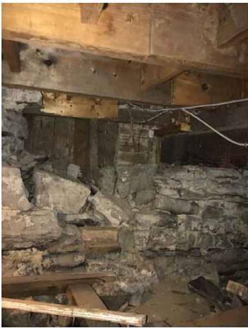
Photo A ; Section retirée de la fondation
