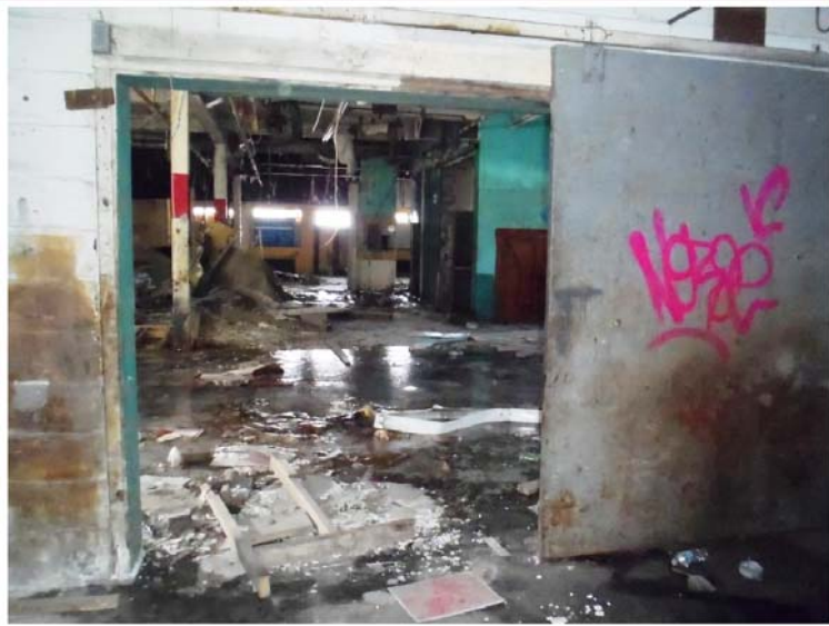
Photo 46 : Succession de trois poteaux au rez-de-chaussée pour le support de la poutre maîtresse
