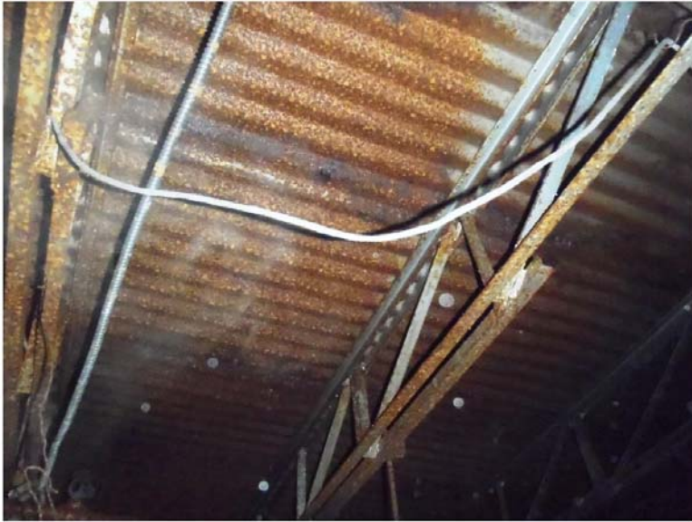
Photo 34 : Charpente de plancher du rez-de-chaussée en acier très dégradée secteur Sud-Est du sous-sol
