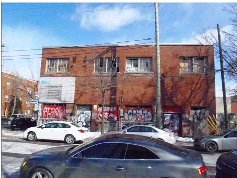
Photo 2 : Façade Ouest du bâtiment inspecté longeant la rue Island
