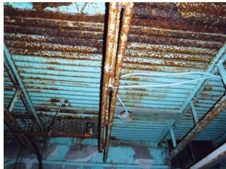
Photo 33 : Charpente de plancher du rez-de-chaussée en acier très dégradée secteur Sud-Est du sous-sol
