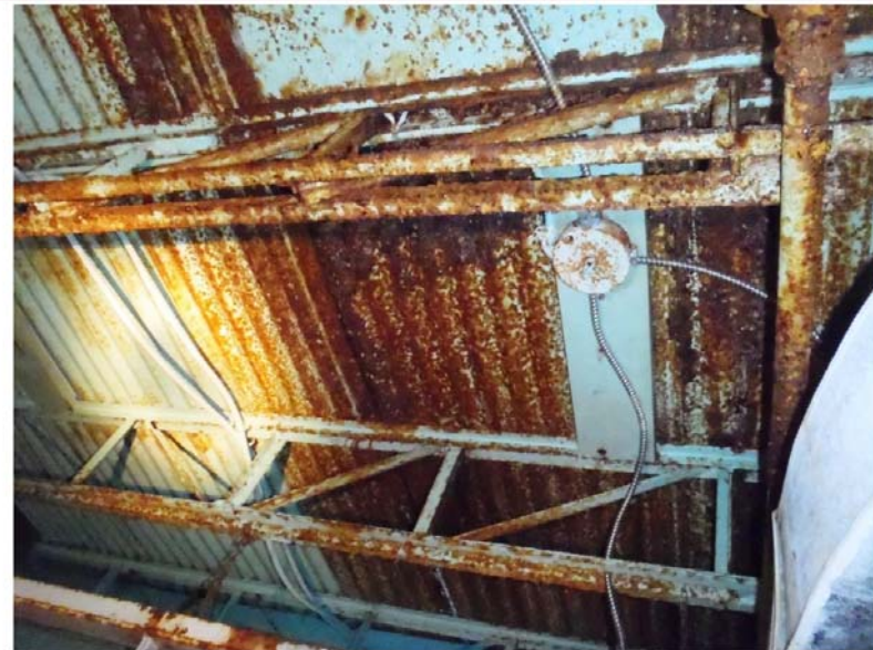
Photo 32 : Charpente de plancher du rez-de-chaussée en acier très dégradée secteur Sud-Est du sous-sol
