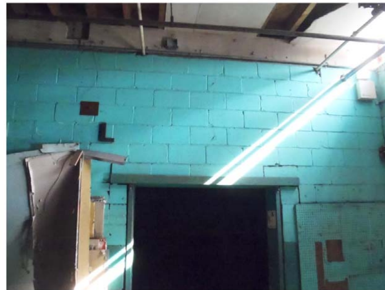
Photo 58 : Lézardes au-dessus d'un linteau dans le mur qui sépare le garage du reste du rez-de-chaussée
