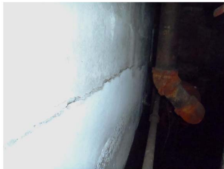
Photo 10 : Déplacement vers l'intérieur de la partie basse du mur Ouest sous la fissure par rapport au haut
