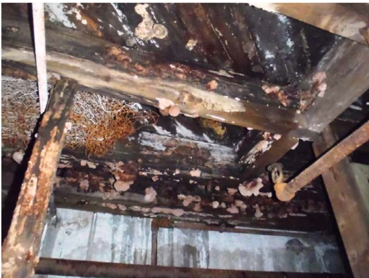
Photo 39 : Champignons et moisissures à l'intrados de la charpente de bois du plancher du rez-de-chaussée
