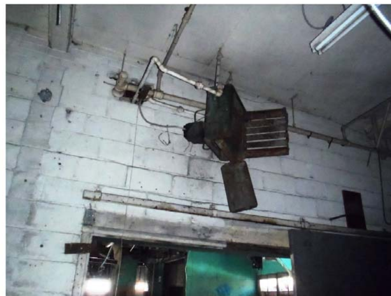
Photo 45 : Poteau d'acier sous la poutre maîtresse inséré dans le mur de blocs de béton séparant le garage
