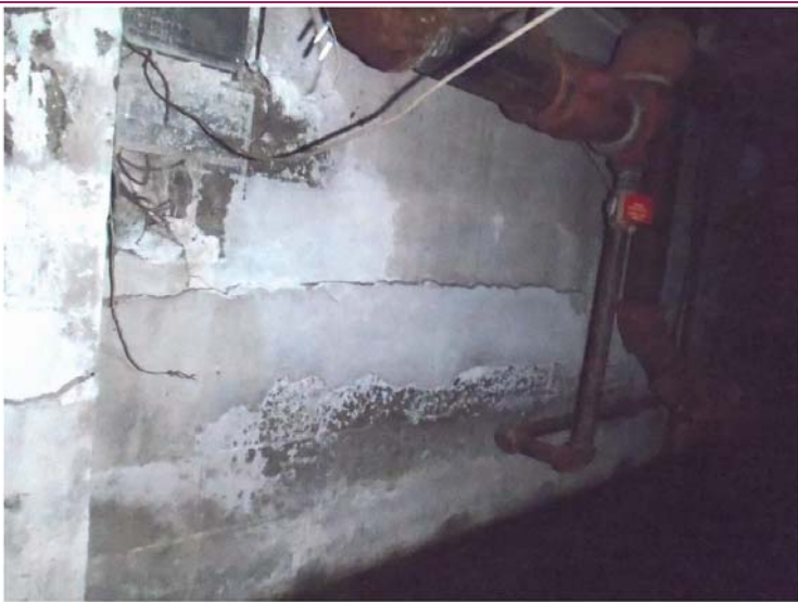
Photo 15 : Réparations de mortier fissurées à nouveau en partie Nord de la fondation Ouest
