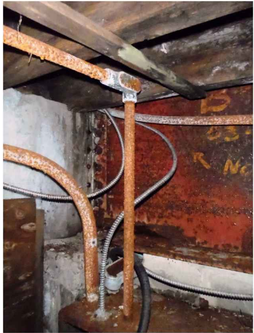
Photo 29 : Poutre maîtresse à son appui sur un massif interne corrodé au niveau de ses assemblages
