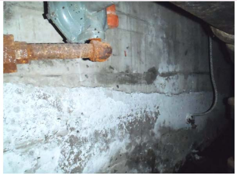
Photo 5 : Portion Sud de la fissure au mur de fondation Ouest avec beaucoup d'efflorescences dessous
