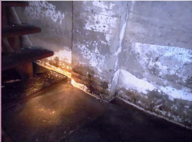
Photo 23 : Béton endommagé par la glace au bas d'un pilastre dans la fondation Sud
