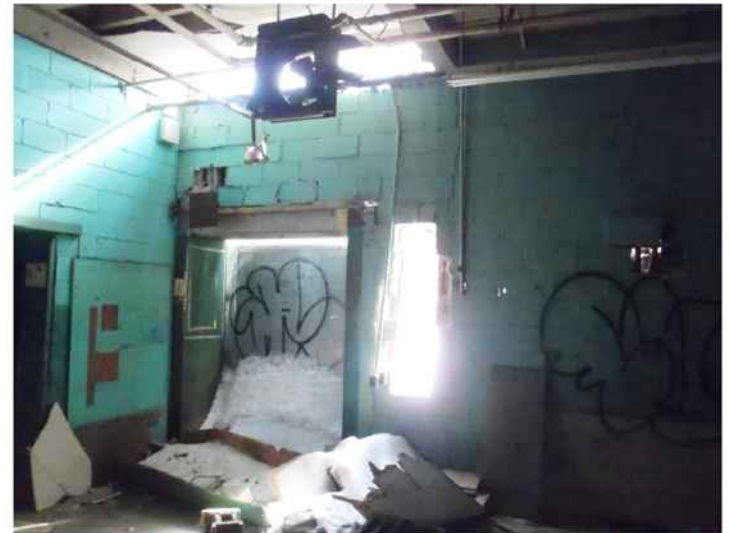
Photo 52 : Endommagement majeur du mur de blocs de béton Sud à l'emplacement d'ouvertures
