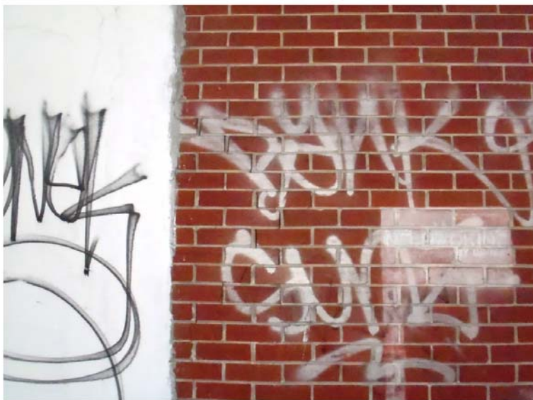
Photo 82 : Lézardes dans le revêtement de brique du mur Nord à la jonction du bâtiment voisin côté Est
