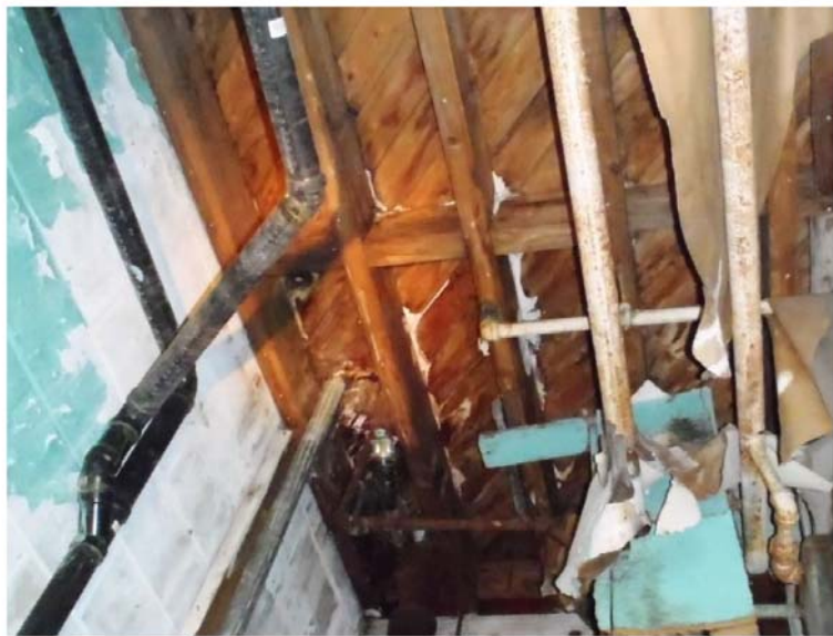
Photo 60 : Charpente du plancher de l'étage exposée où on constate la présence de champignons
