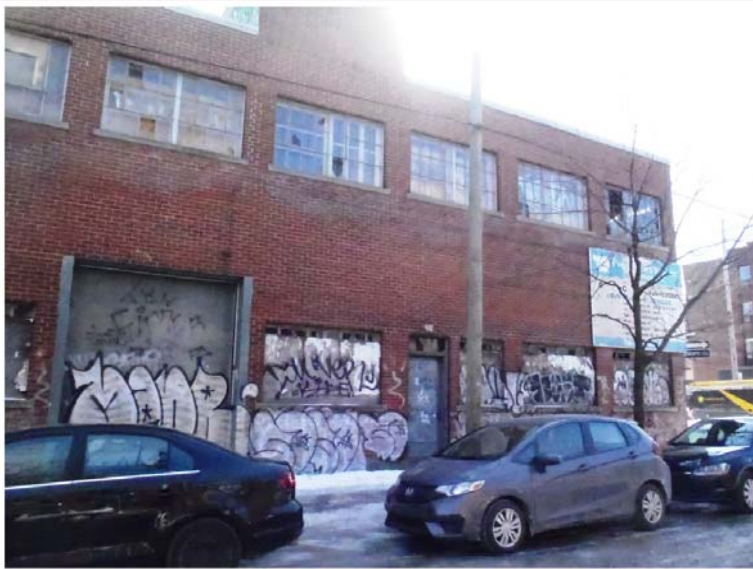
Photo 81 : Extrémité Ouest de la façade Nord au coin des rues Augustin-Cantin et Island
