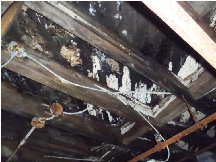
Photo 38 : Champignons et moisissures à l'intrados de la charpente de bois du plancher du rez-de-chaussée
