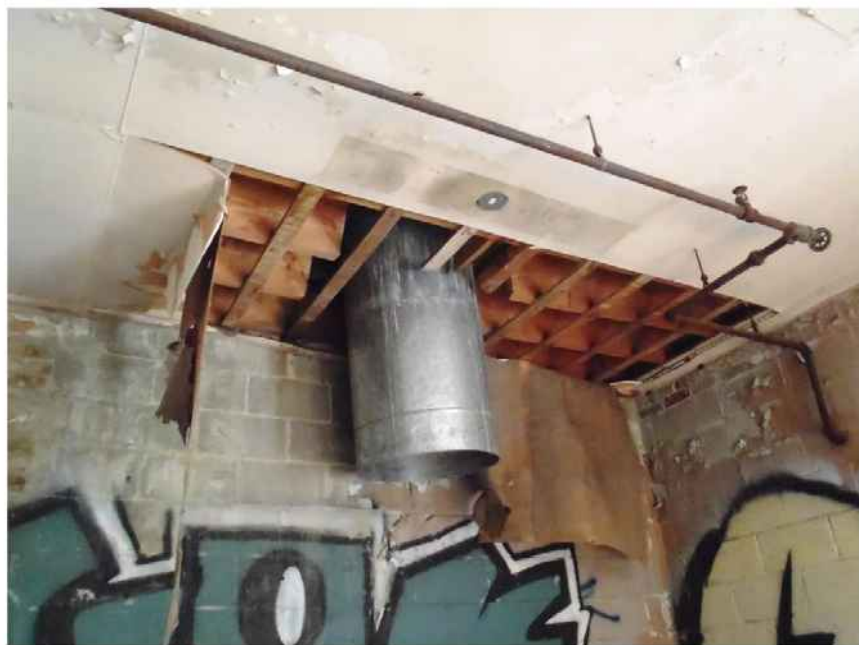
Photo 64 : Solives du toit orientées Nord-Sud au-dessus du garage dont certaines sont coupées
