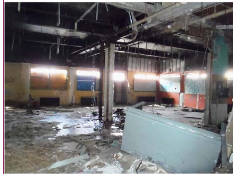
Photo 62 : Signes de vandalisme et présence de déchets au rez-de-chaussée
