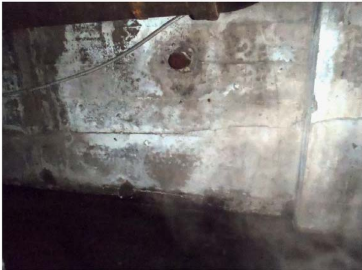
Photo 7 : Fissure au mur de fondation Ouest au Sud du pilastre supportant la poutre maîtresse
