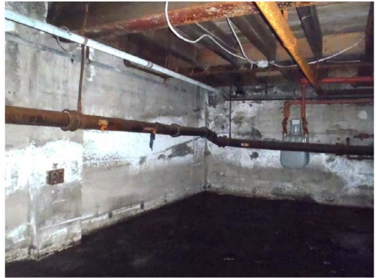
Photo 18 : Efflorescences sous le niveau de joints froids aux murs de fondation Sud et Ouest
