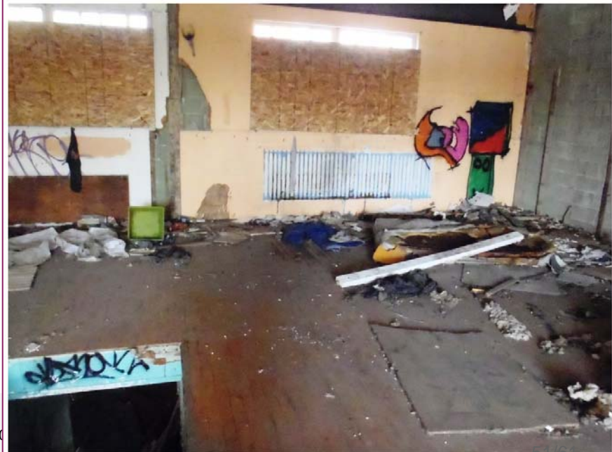
Photo 70 : Matelas et déchets laissés par des gens qui ont squattés sur les lieux à l'étage
