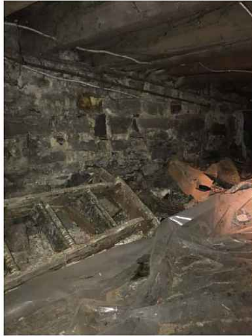
Photo D ; Mur de fondation en moellon
