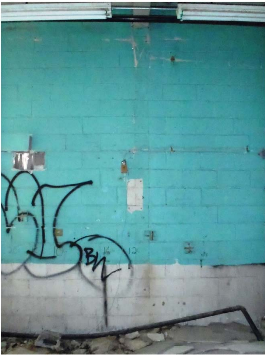
Photo 50 : Fissuration typique des blocs des murs extérieurs vis-à-vis les poteaux d'acier qui y sont insérés
