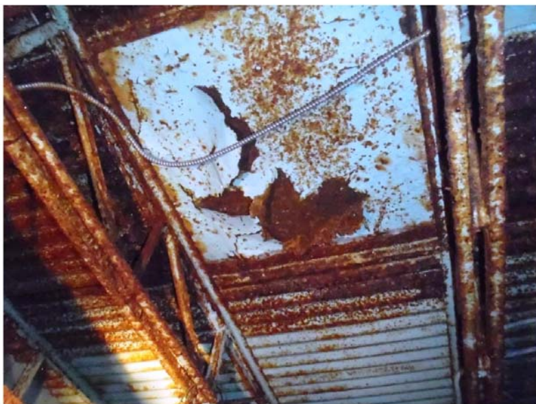
Photo 31 : Charpente de plancher du rez-de-chaussée en acier très dégradée secteur Sud-Est du sous-sol
