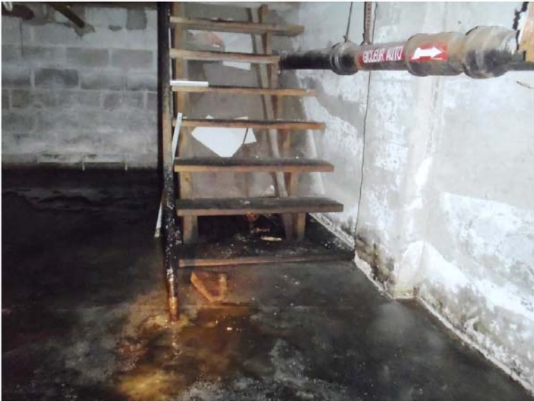
Photo 4 : Pied de l'escalier menant au sous-sol pris dans la glace le long du mur de fondation Sud
