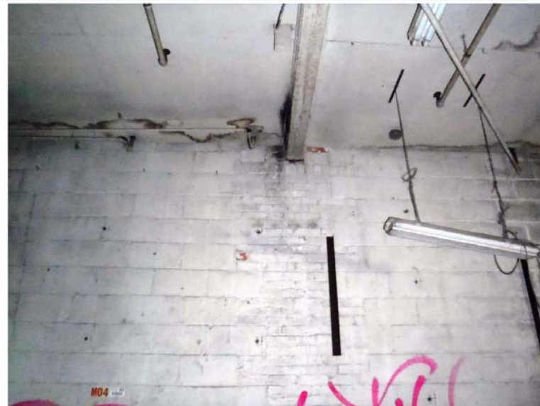
Photo 44 : Massif de briques portant la poutre maîtresse intégré dans le mur en blocs de béton mitoyen Es
