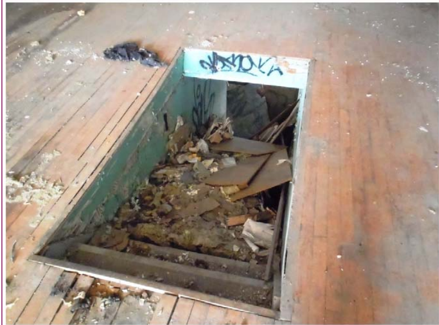
Photo 69 : Escalier rempli de déchets qu'il a fallu escalader pour accéder au second étage
