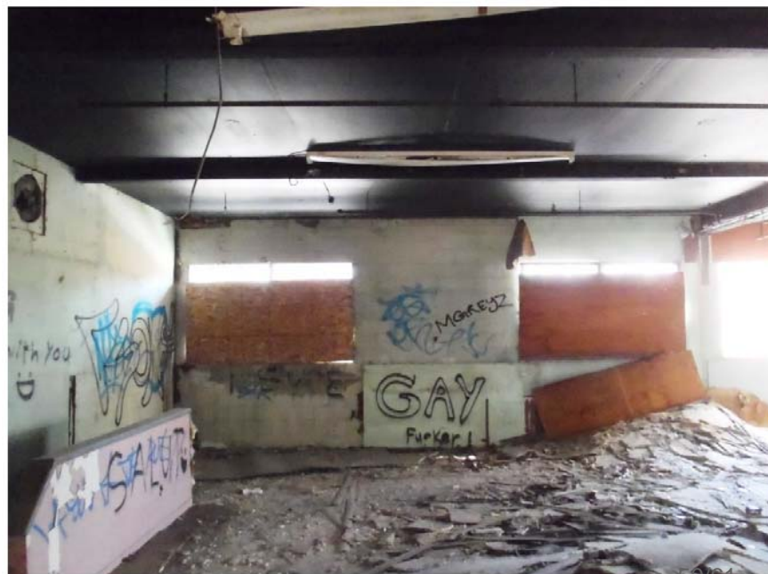
Photo 66 : Nombreux déchets et débris de vandalisme jonchant le plancher de l'étage
