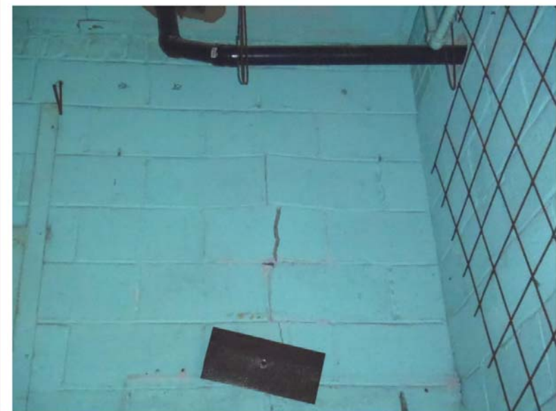
Photo 56 : Blocs de béton défoncés vers l'extrémité Est du mur en façade Sud du bâtiment
