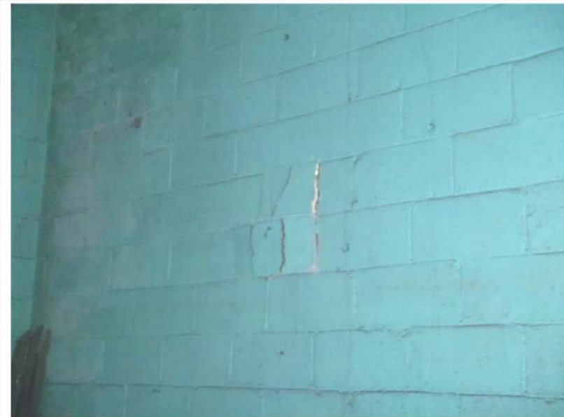
Photo 55 : Blocs de béton défoncés vers l'extrémité Est du mur en façade Sud du bâtiment
