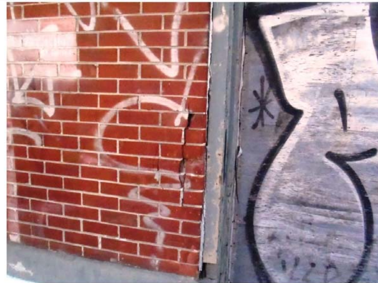
Photo 83 : Endommagement de la brique le long du jambage Est de la porte du garage au mur Nord
