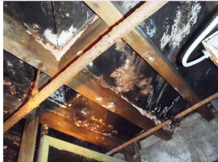
Photo 40 : Champignons et moisissures à l'intrados de la charpente de bois du plancher du rez-de-chaussée
