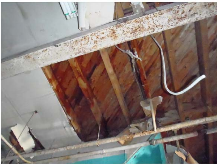
Photo 59 : Charpente du plancher de l'étage exposée où on constate la présence de taches d'humidité
