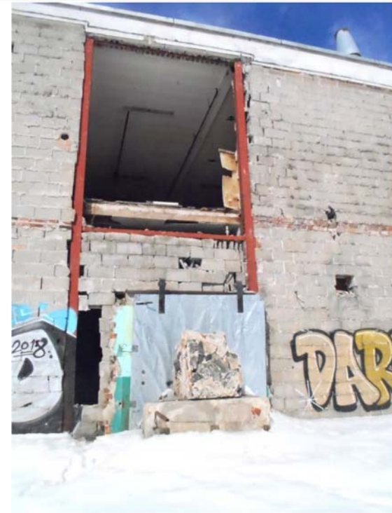
Photo 86 : Ouverture exposée aux intempéries en façade Sud et blocs de béton en piètre état au pourtour
