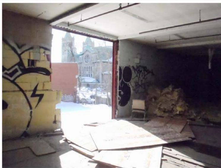
Photo 73 : Ouverture laissée sans protection dans le mur en blocs de béton de la façade Sud
