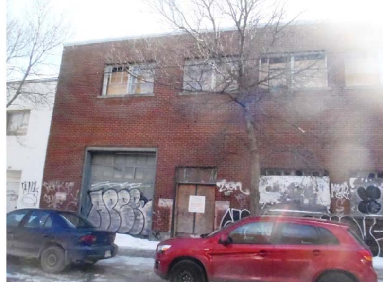
Photo 79 : Extrémité Est de la façade Nord où se situe le garage à la jonction de l'immeuble voisin
