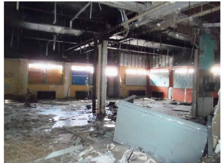
Photo 48 : Eau transformée en glace en surface du plancher du rez-de-chaussée provenant d'un conduit
