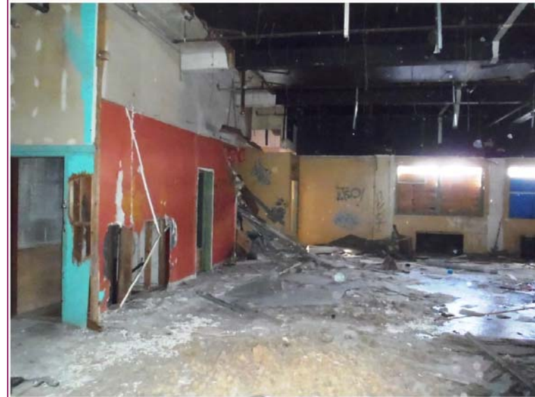
Photo 61 : Signes de vandalisme et présence de déchets au rez-de-chaussée
