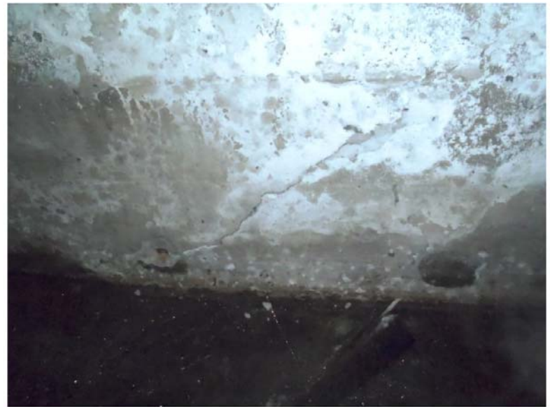
Photo 14 : Fissures en diagonal à l'extrémité Sud de la fondation Ouest
