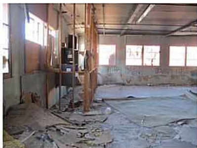
25-26. Bâtiment (A) intérieurs étage, 2013 (Lafontaine & Soucy)
