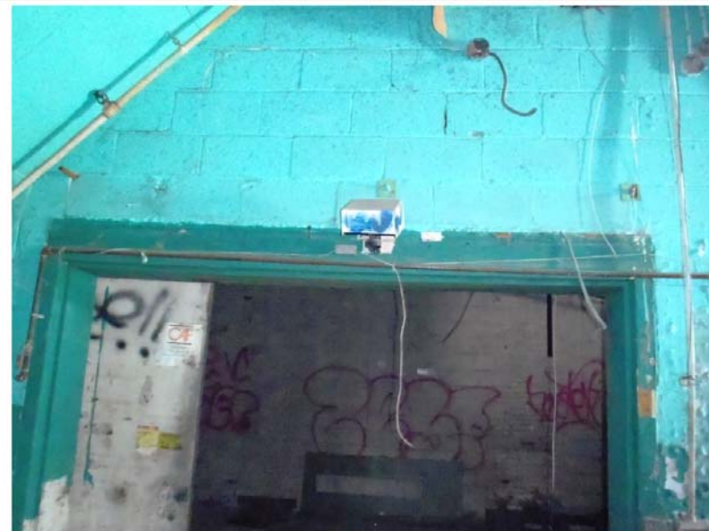
Photo 57 : Lézardes au-dessus d'un linteau dans le mur qui sépare le garage du reste du rez-de-chaussée
