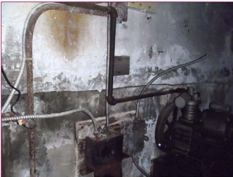
Photo 11 : Fissuration s'élargissant dans la section Nord du mur de fondation Ouest
