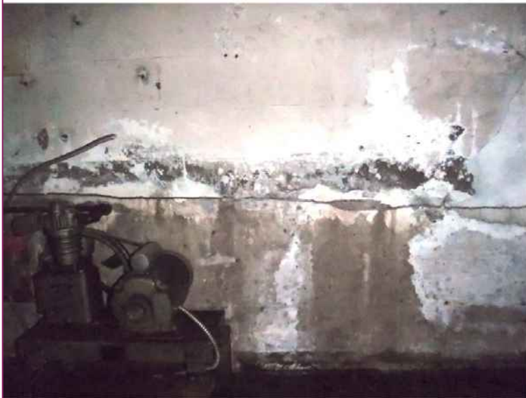
Photo 12 : Fissuration s'élargissant dans la section Nord du mur de fondation Ouest
