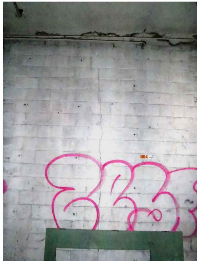
Photo 54 : Fissuration en partie Nord du mur mitoyen Est en blocs de béton sur presque toute sa hauteur
