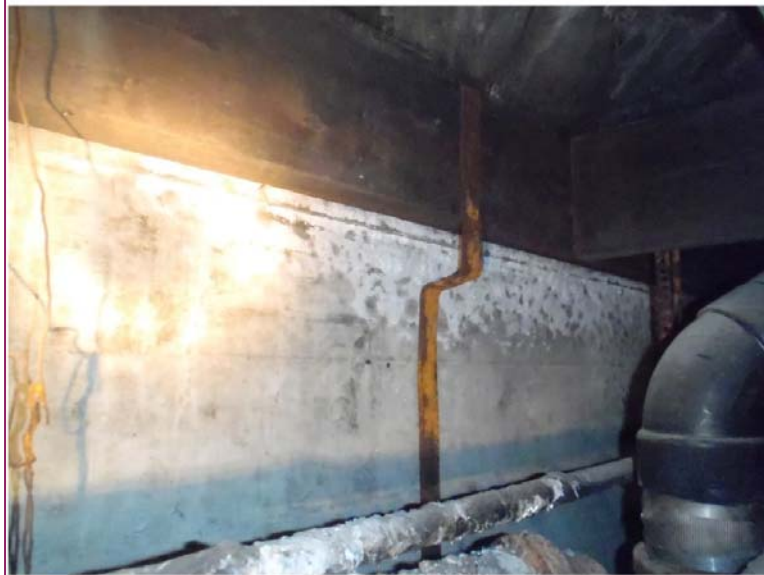
Photo 20 : Efflorescences présentes en partie haute de la fondation en façade Sud
