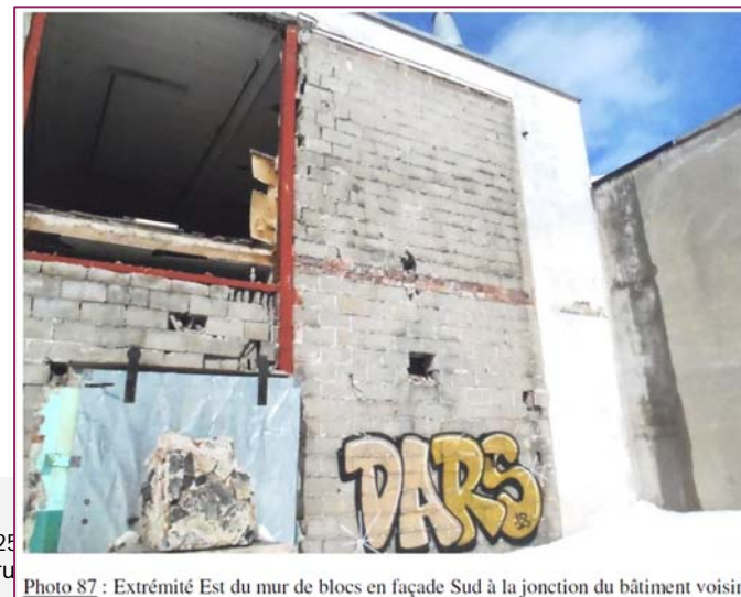
Photo 87 : Extrémité Est du mur de blocs en façade Sud à la jonction du bâtiment voisin
