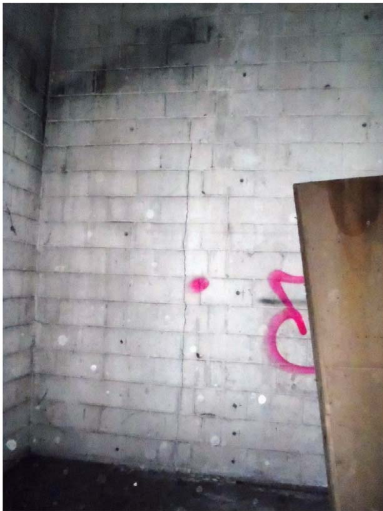
Photo 53 : Fissuration en partie Nord du mur mitoyen Est en blocs de béton sur presque toute sa hauteur
