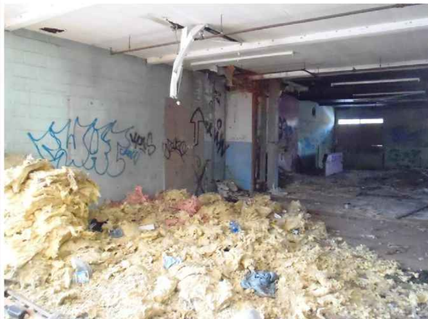
Photo 68 : Nombreux déchets et débris de vandalisme jonchant le plancher de l'étage
