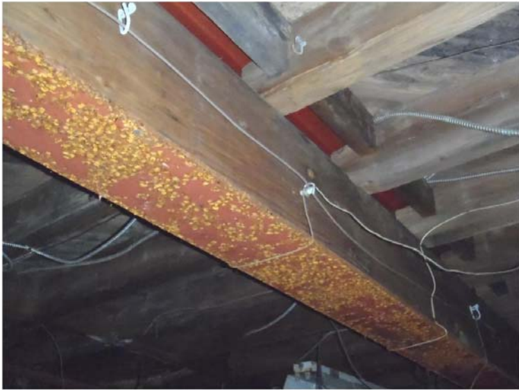
Photo 28 : Poutre secondaire en acier au plancher du rez-de-chaussée avec une corrosion modérée
