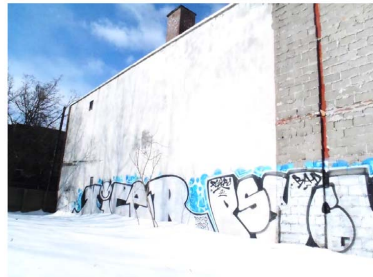
Photo 84 : Revêtement de crépi recouvrant en majorité le mur de blocs Sud à partir de la façade Ouest
