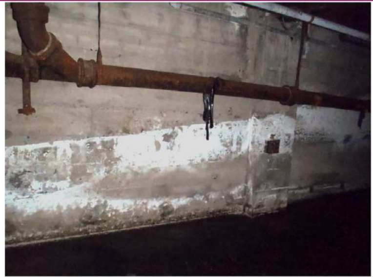
Photo 17 : Efflorescences sous le niveau d'un joint froid au mur de fondation Sud
