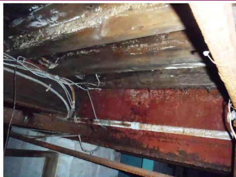
Photo 25 : Poutre maîtresse en acier de 27" au plancher du rez-de-chaussée orientée Est-Ouest
