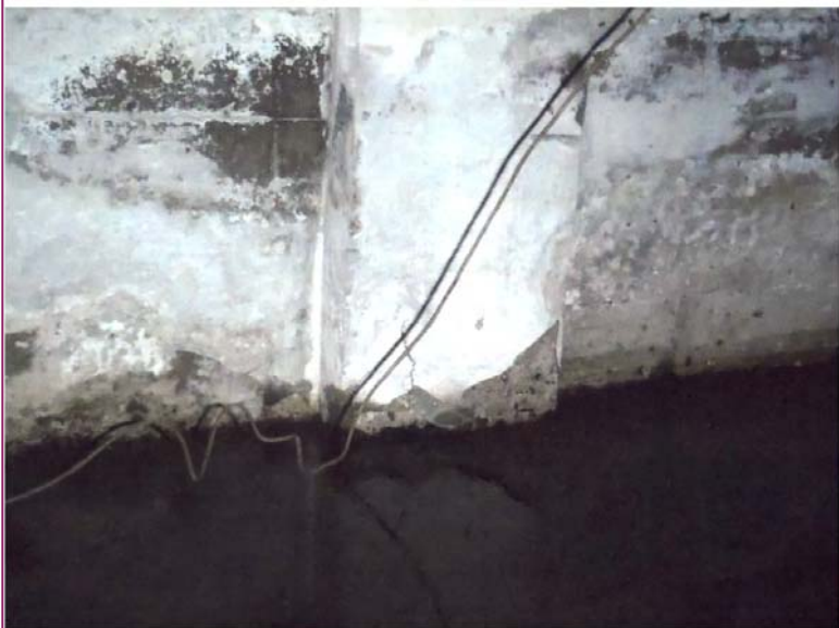
Photo 24 : Béton endommagé par la glace au bas d'un pilastre dans la fondation Nord
