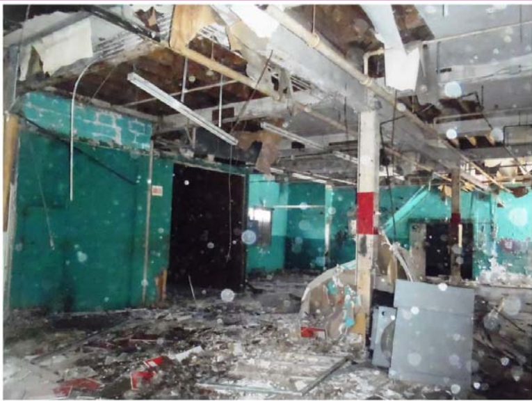
Photo 3 : Poteaux intérieurs soutenant la poutre maîtresse d'où partent celles secondaires
