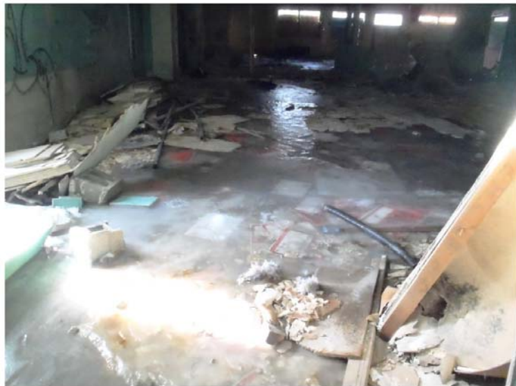
Photo 47 : Eau transformée en glace en surface du plancher du rez-de-chaussée
