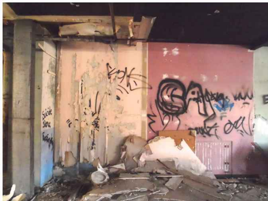
Photo 67 : Nombreux déchets et débris de vandalisme jonchant le plancher de l'étage
