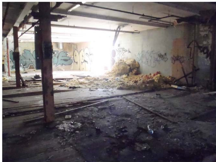
Photo 65 : Nombreux déchets et débris de vandalisme jonchant le plancher de l'étage
