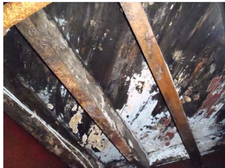
Photo 41 : Champignons et moisissures à l'intrados de la charpente de bois du plancher du rez-de-chaussée
