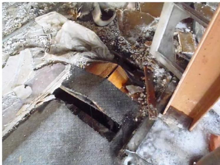
Photo 74 : Présence d'eau transformée en glace au pied d'un poteau d'acier à l'étage
