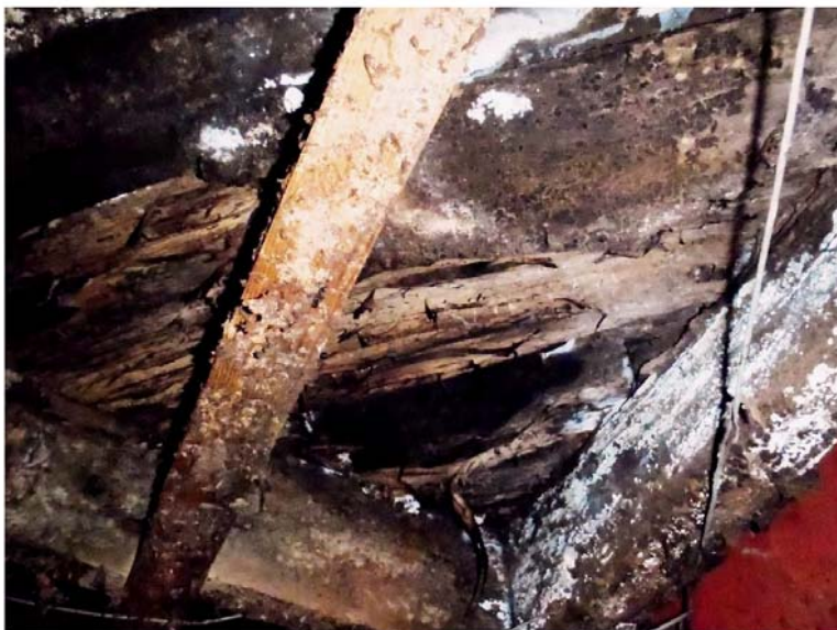
Photo 43 : Champignons et moisissures à l'intrados de la charpente de bois du plancher du rez-de-chaussée
