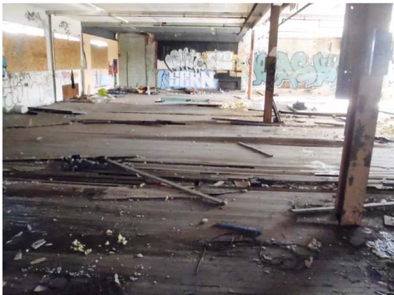
Photo 78 : Détérioration généralisée du plancher de l'étage sous l'effet de l'eau qui va dessus
