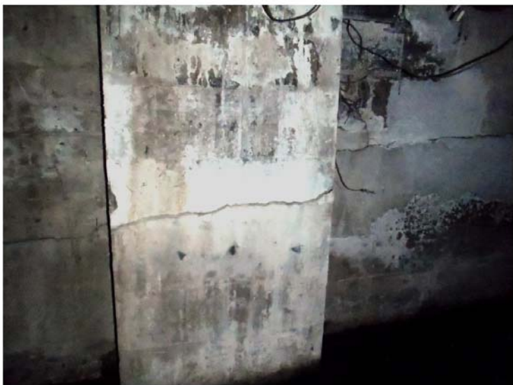
Photo 8 : Fissure à la fondation en façade Ouest traversant le pilastre qui supporte la poutre maîtresse
