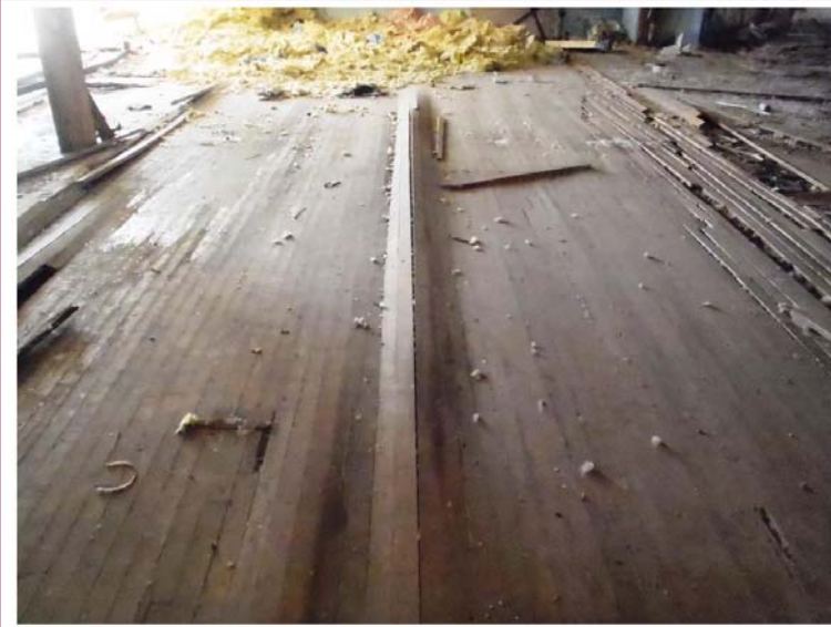
Photo 75 : Soulèvement des lattes du plancher de l'étage sous l'effet de l'eau qui va dessus
