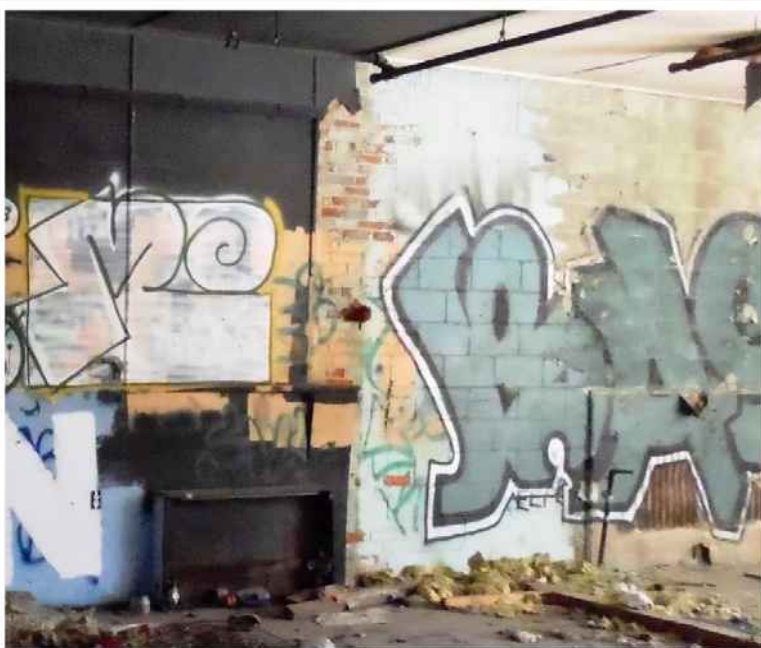
Photo 63 : Massif de briques portant la poutre maîtresse intégré dans le mur en blocs de béton mitoyen Est
