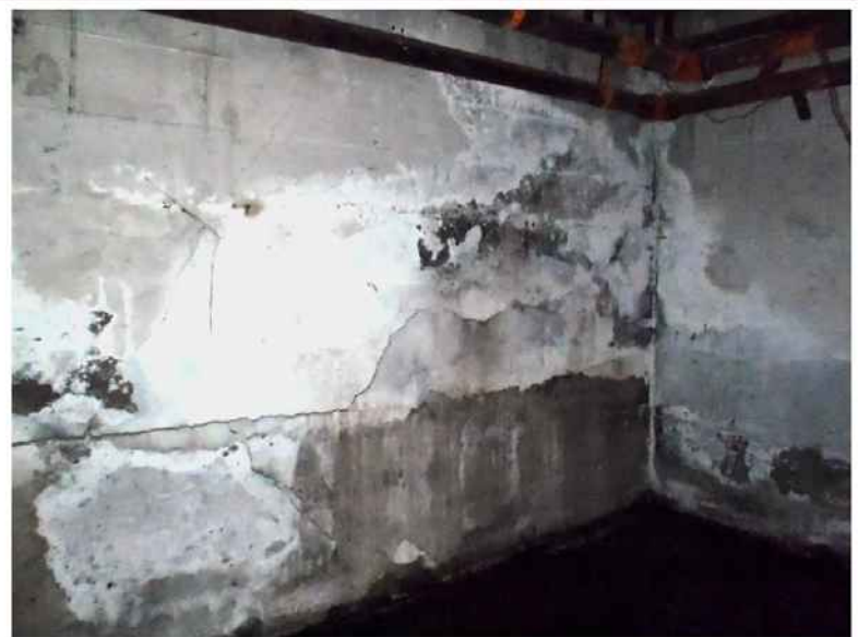
Photo 13 : Diverses fissures à l'extrémité Nord de la fondation Ouest émanant de celle longitudinale
