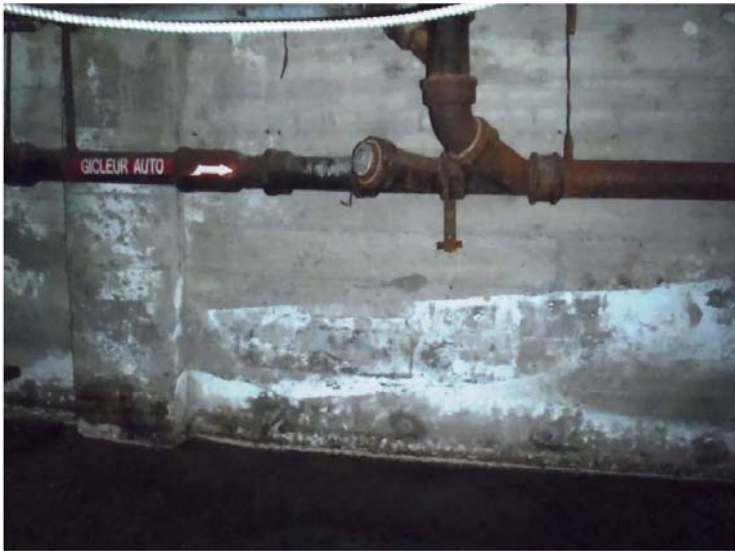
Photo 16 : Efflorescences sous le niveau d'un joint froid au mur de fondation Sud
