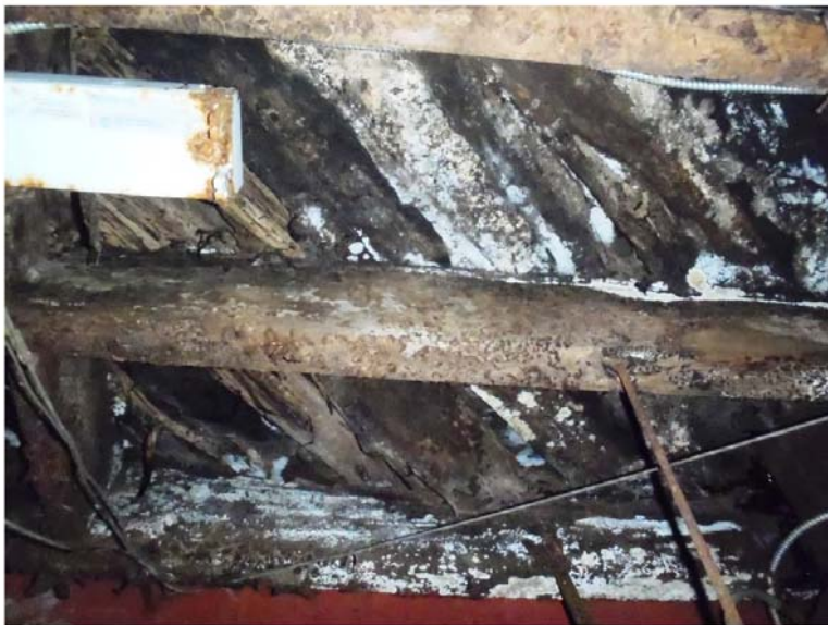
Photo 42 : Champignons et moisissures à l'intrados de la charpente de bois du plancher du rez-de-chaussée
