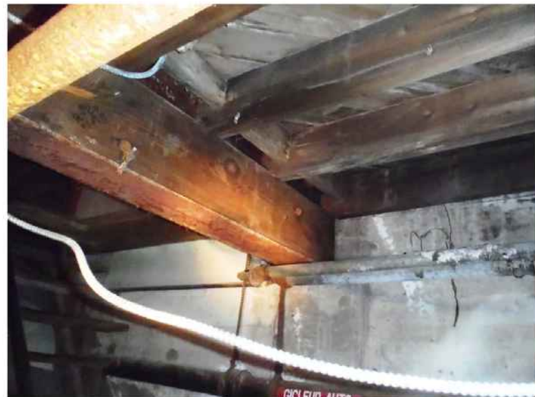
Photo 26 : Poutre secondaire en acier de 18" au plancher du rez-de-chaussée à son appui au mur Su
