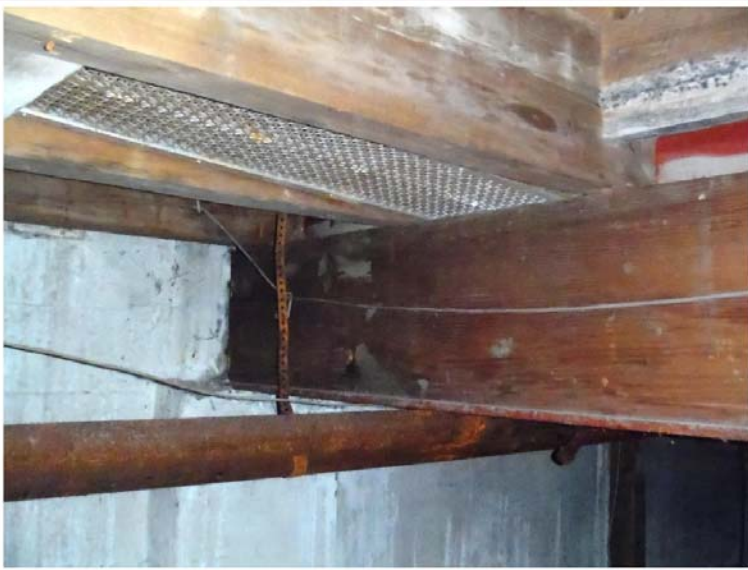
Photo 27 : Poutre secondaire en acier de 18" au plancher du rez-de-chaussée à son appui au mur Nord
