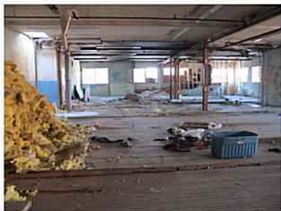
23-24. Bâtiment (A) intérieurs étage, 2013 (Lafontaine & Soucy)
