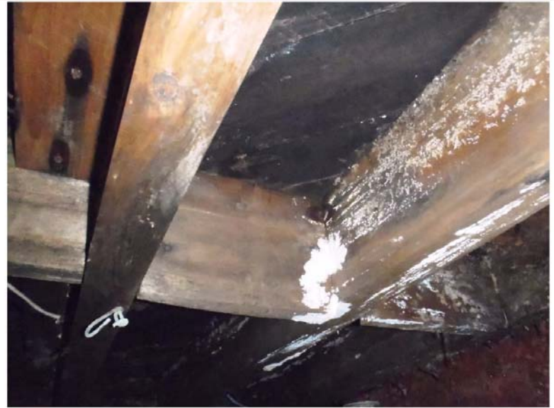
Photo 36 : Champignons et moisissures à l'intrados de la charpente de bois du plancher du rez-de-chaussée
