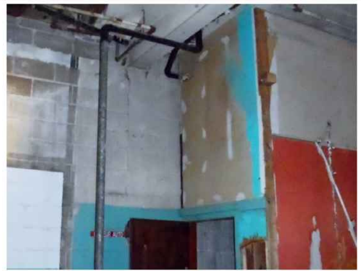
Photo 51 : Fissuration typique des blocs des murs extérieurs vis-à-vis les poteaux d'acier qui y sont insérés
