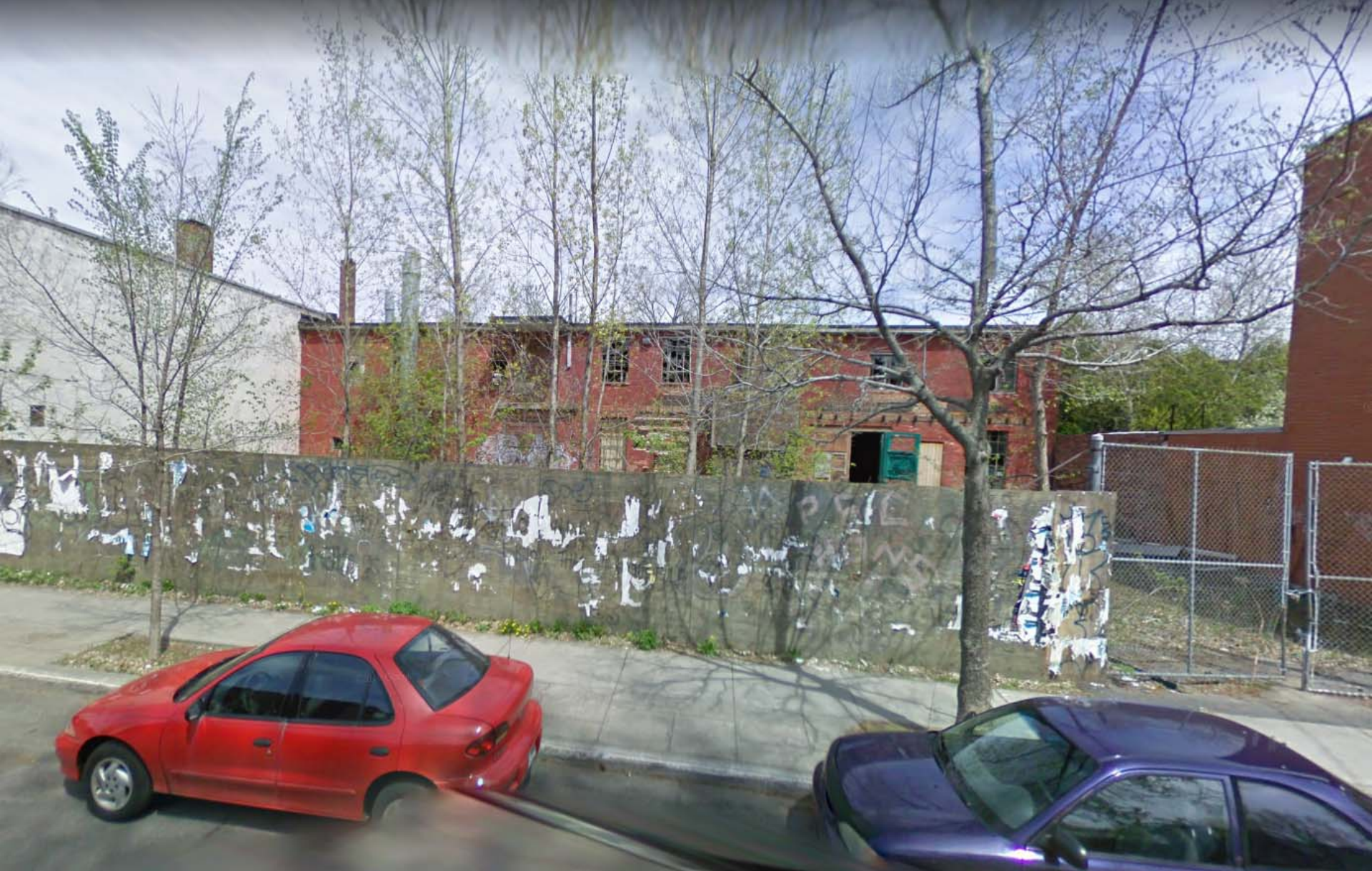
Partie démolie suite à un ordre de démolition partielle (bâtiment dangereux) - juin 2018
