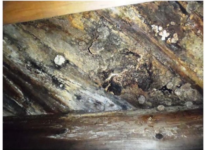
Photo 37 : Champignons et moisissures à l'intrados de la charpente de bois du plancher du rez-de-chaussée
