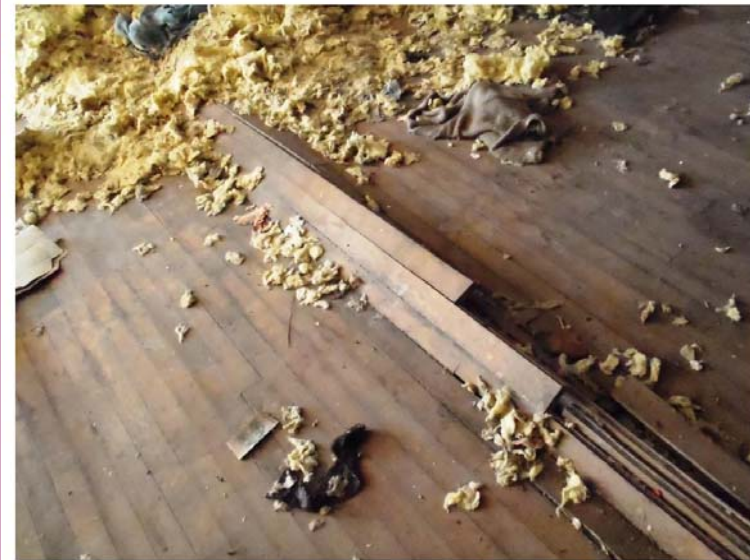
Photo 76 : Soulèvement des lattes du plancher de l'étage sous l'effet de l'eau qui va dessus
