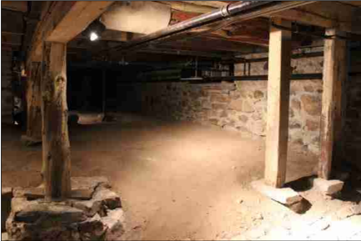
Figure 8- Zone visée par le projet architectural : Photographie
