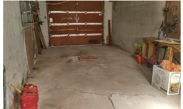
Indices de pyrite sous la dalle du garage. Indices de pyrite sous la dalle du garage.
