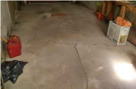
Indices de pyrite sous la dalle du garage. Indices de pyrite sous la dalle du garage.
