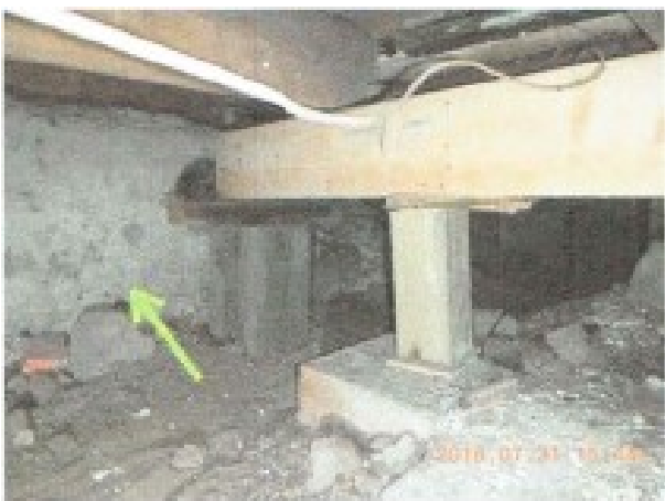
Mur mitoyen en moellon.
