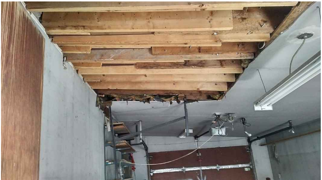
Structure du toit du garage artisanale, non-conforme.
