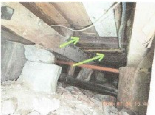
Structure de plancher artisanale.
