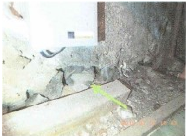
Les pierres se détachent au bas de la fondation.
