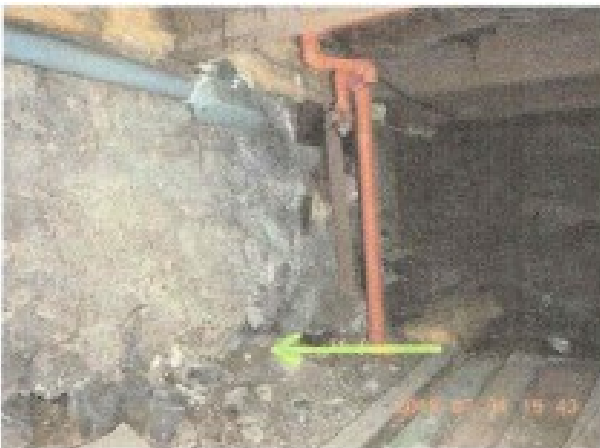
Le bas de la fondation se dégrade.
