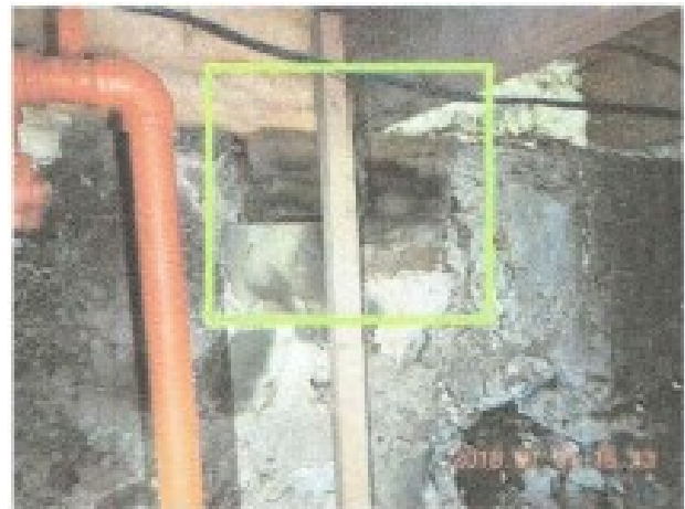
Support inadéquat pour une solive de plancher.
