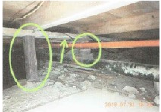
Mauvais support de solives.
