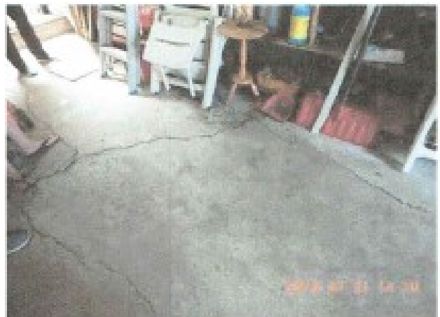
Indices de pyrite sous la dalle du garage.
