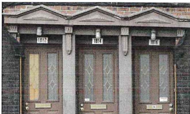
*Bâtiment A : Les frontons de bois qui coiffent les portes d'entrée sont d'origine. Par contre, les portes d'acier sont récentes.*
