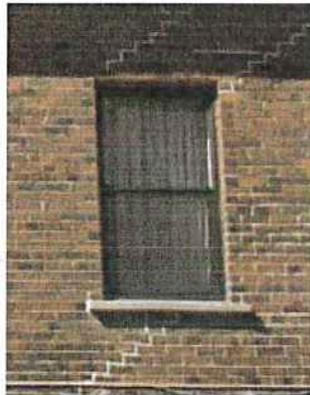
*Bâtiment A : Plusieurs fissures apparaissent sur la brique qui se désolidarise de la structure.*
