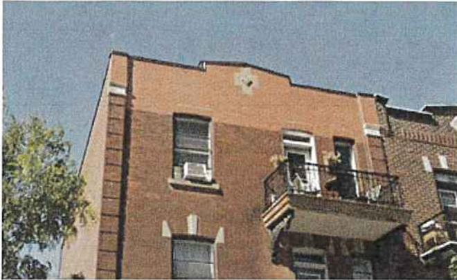
Bâtiment B : La brique de façade a été remplacée au parapet.
