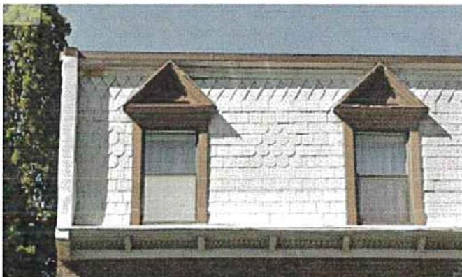
*Bâtiment A : La toiture en fausse mansarde, la corniche en bois, les tuiles d'ardoise et les lucarnes en bois à fronton triangulaire sont d'origine.*
