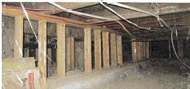
*Bâtiment A : De récents murs nains et semelles de béton reprennent les charges des poutres au vide sanitaire.*
