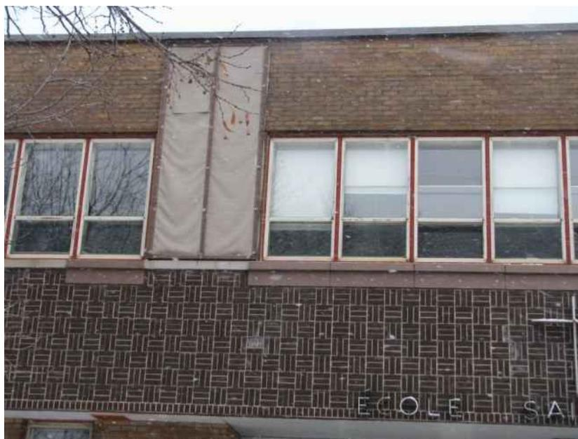
**Figure 37 : Traces d'infiltration d'eau et dégradation au niveau de la maçonnerie, consolidée par endroits.**
