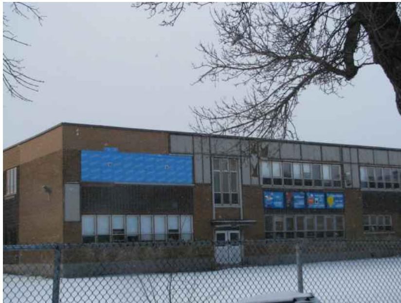
**Figure 39 : Sécurisation temporaire de la maçonnerie en brique.**
