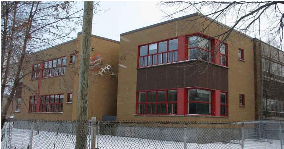
**Figure 19 : L'ajout de 2003 montrant la configuration des fenêtres et l'agencement des couleurs du revêtement avec le parement de brique d'origine.**
