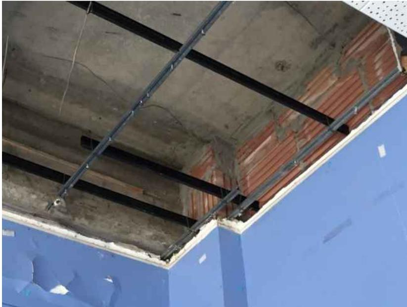
**Figure 42 : Vue montrant une partie de la toiture et du mur non isolés.**
