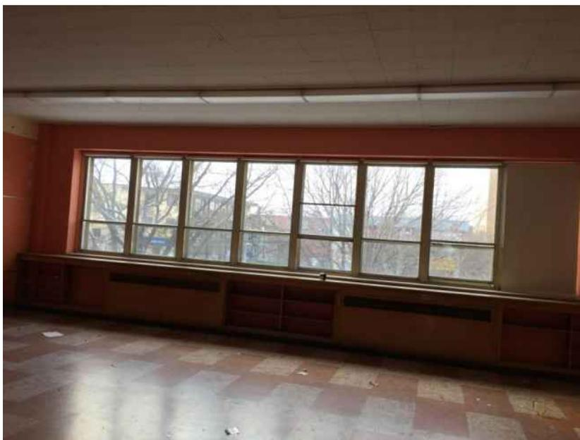
**Figure 32 : Vue d'une classe montrant la configuration des fenêtres, de même que la boiserie d'origine des étagères.**
