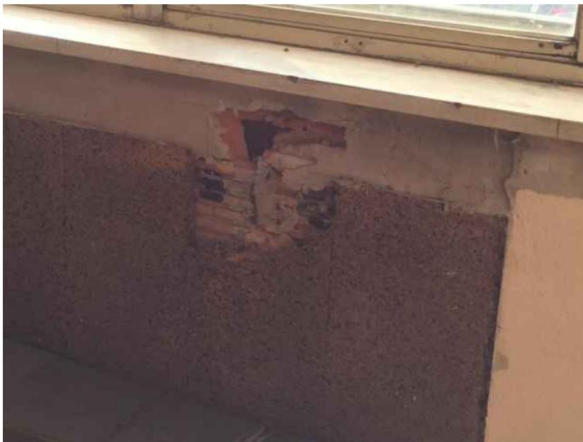
**Figure 41 : Les murs ne sont pas étanches et ne sont pas isolés adéquatement.**
