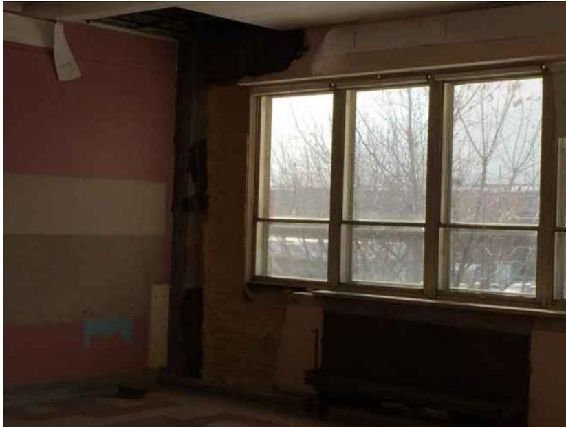
**Figure 40 : Traces d'infiltrations d'eau et de contamination détectées à l'intérieur des murs.**
