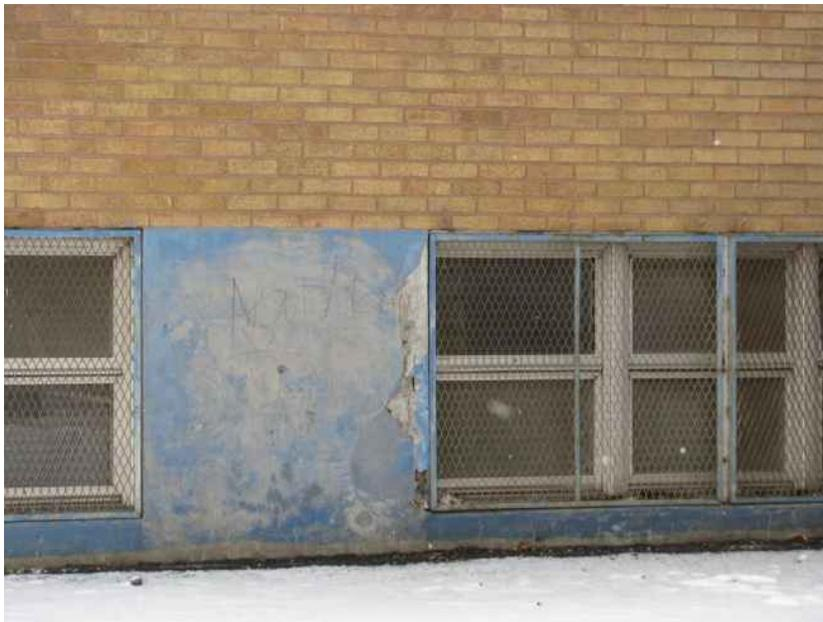
**Figure 43 : Traces de salissure et d'infiltrations d'eau au niveau du soubassement.**
