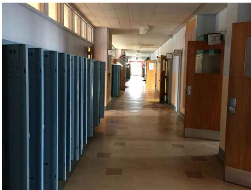
**Figure 30 : Perspective du corridor à l'étage montrant les bandeaux vitrés situés dans la partie supérieure des murs des classes.**
