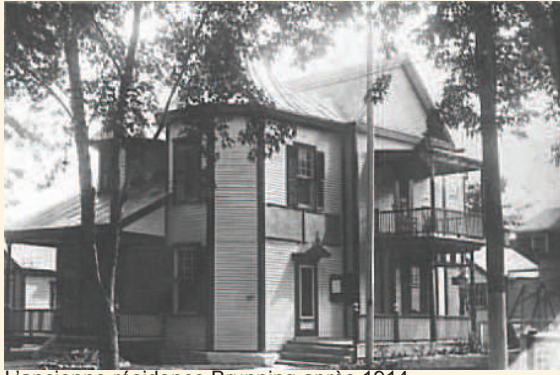
L'ancienne résidence Brunning après 1914
