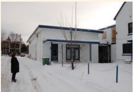
Un des agrandissements à toit plat, en janvier 2015
